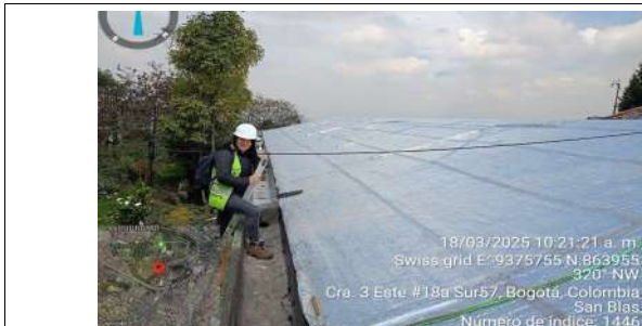
FECHA FOTO: 18/03/2025 DESCRIPCIÓN: Instalacion de manto impermeabilizante en cubierta y canal
