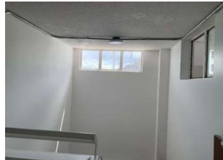
FECHA FOTO: 15/04/2025 DESCRIPCIÓN: aplicación de pintura en muros e instalacion de luminarias
