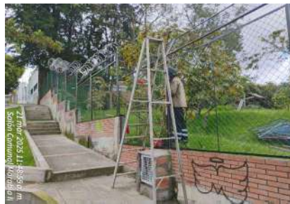
FECHA FOTO: 21/03/2025 DESCRIPCIÓN: Labores de mantenimeinto de reja existente o reposicion con malla nueva.
