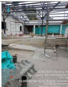
FECHA FOTO: 03/04/2025 DESCRIPCIÓN: Instalación de perfileria metalica para cubierta
