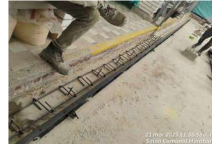
FECHA FOTO: 21/03/2025 DESCRIPCIÓN: acero para paso
