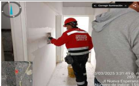
FECHA FOTO: 20/03/2025 3:31:49 p. m. DESCRIPCIÓN: actividad de instalacion de estuco
