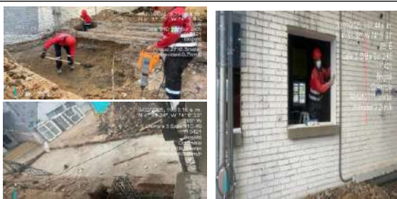
FECHA FOTO: 30/01/2025 DESCRIPCIÓN: Se realizan actividades de excavación y demolición de rampa, zapatas y pañete de perfil ventanería
