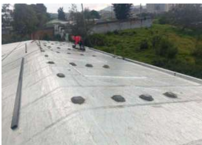
FECHA FOTO: 27/03/2025 DESCRIPCIÓN: nivelacion para instalar perfilera para soportar cubierta
