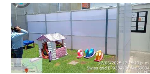
FECHA FOTO: 27/03/2025 DESCRIPCIÓN: Instalacion de cerramiento en policarbonato
