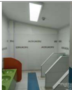
FECHA FOTO: 03/04/2025 DESCRIPCIÓN: instalacion de media caña en PVC
