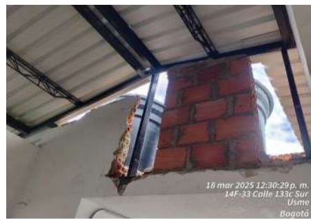
FECHA FOTO: 18/03/2025 DESCRIPCIÓN: mampostería para nivelar cubierta
