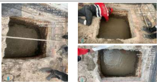
FECHA FOTO: 01/02/2025 DESCRIPCIÓN: Se realizaron actividades de fundida de concreto ciclopeo para zapatas
