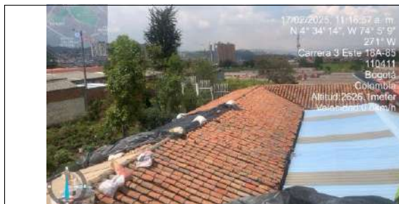
FECHA FOTO: 17/02/2025 DESCRIPCIÓN: Estado del frente
