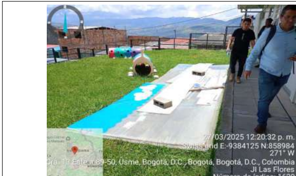
FECHA FOTO: 27/03/2025 DESCRIPCIÓN: Instalacion de cerramiento en policarbonato
