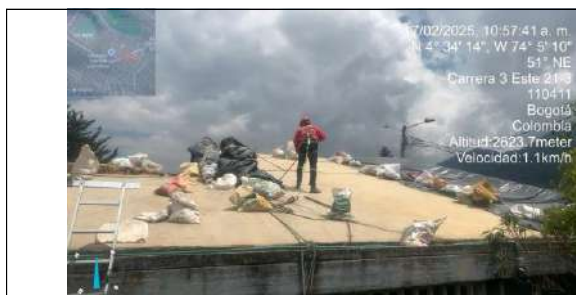
FECHA FOTO: 17/02/2025 DESCRIPCIÓN: Estado del frente
