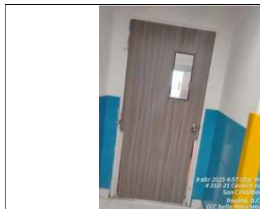
FECHA FOTO: 09/04/2025 DESCRIPCIÓN: instalacion de puerta en madera
