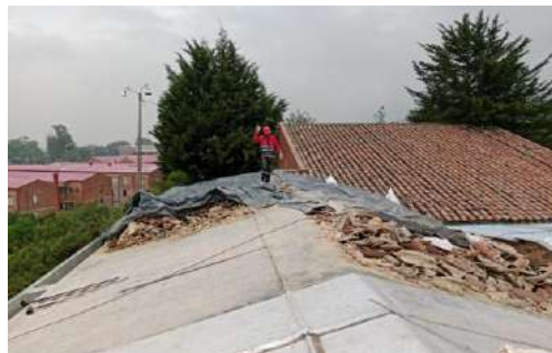
FECHA FOTO: 04/03/2025 DESCRIPCIÓN: Instalacion de manto impermeabilizante y demolición de tejado
