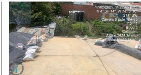
FECHA FOTO: 17/02/2025 DESCRIPCIÓN: Estado del frente
