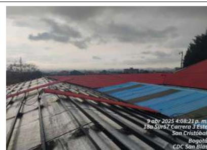
FECHA FOTO: 09/04/2025 DESCRIPCIÓN: Instalacion de cubierta y flanches
