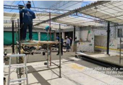
FECHA FOTO: 28/03/2025 DESCRIPCIÓN: Instalacion de estructura metalica para cubierta y desmonte de la cubierta existente
