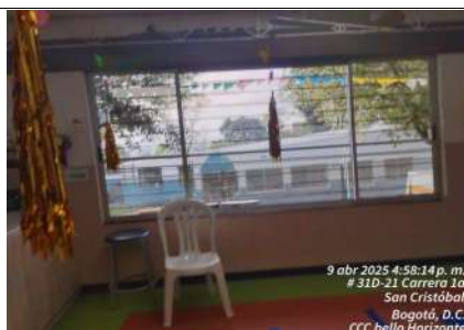
FECHA FOTO: 09/04/2025 DESCRIPCIÓN: instalacion de ventanas
