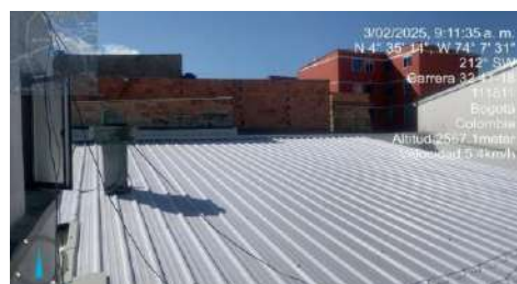
FECHA FOTO: 03/02/2025 DESCRIPCIÓN: Instalación flanche
