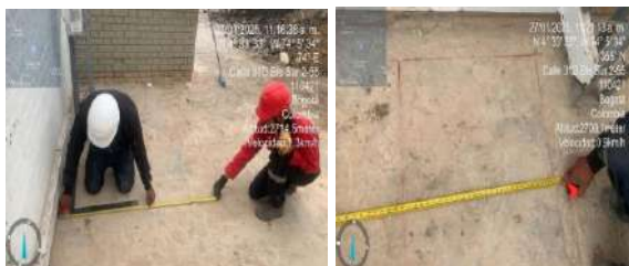
FECHA FOTO: 27/01/2025 DESCRIPCIÓN: Se realizan actividades de replanteo para excavaciones de zapatas y rampa
