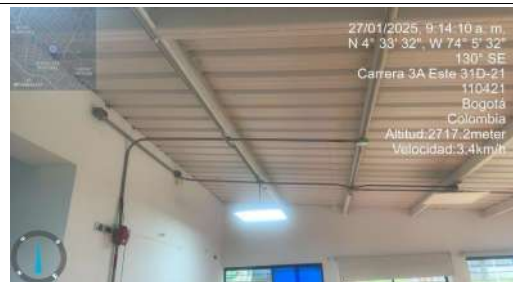
FECHA FOTO: 27/01/2025 DESCRIPCIÓN: Instalación red electrica y luminaria de panel led 60x60 en patio de cuarto de primaria infancia
