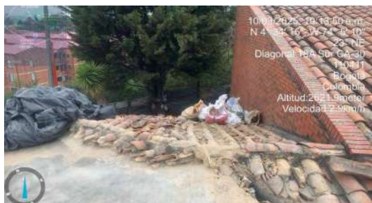
FECHA FOTO: 10/03/2025 DESCRIPCIÓN: Demolición de cubierta y embalaje de residuos de construcción
