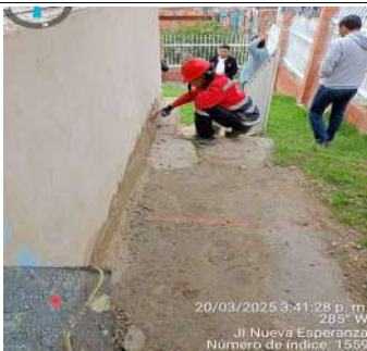
FECHA FOTO: DESCRIPCIÓN: Inicio de construccion de medias cañas.
