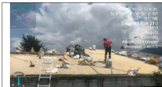
FECHA FOTO: 17/02/2025 DESCRIPCIÓN: Estado del frente
