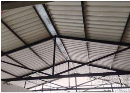
FECHA FOTO: 18/03/2025 DESCRIPCIÓN: Instalación de perfilera metálica y pintura de cerchas y correas, cubierta doble altura primer piso.
