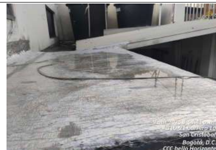
FECHA FOTO: 09/04/2025 DESCRIPCIÓN: se realiza impermeabilizacion de la placa sobre espacio de almacenamiento de alimentos
