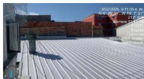
FECHA FOTO: 03/02/2025 DESCRIPCIÓN: Instalación flanche
