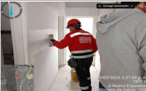
FECHA FOTO: DESCRIPCIÓN: actividad de instalacion de estuco
