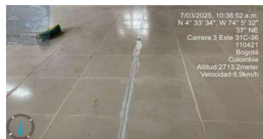
FECHA FOTO: 07/03/2025 DESCRIPCIÓN: Instalacion de boquilla en juntas de dilatación
