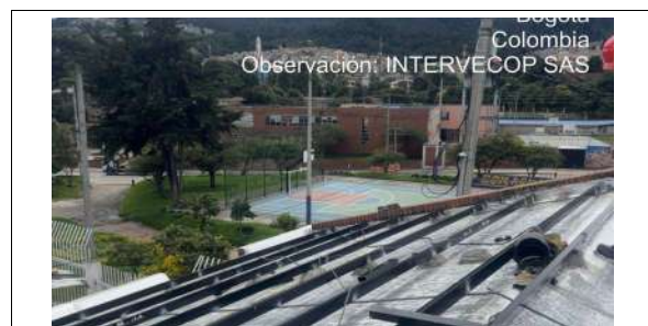
FECHA FOTO: 06/04/2025 DESCRIPCIÓN: Instalacion de perfiles metalicos para el soporte de la cubierta
