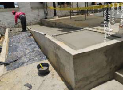
FECHA FOTO: 28/03/2025 DESCRIPCIÓN: fundida de rampa
