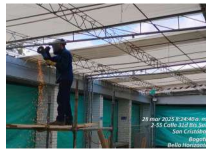
FECHA FOTO: 28/03/2025 DESCRIPCIÓN: desmonte de cubierta metalica
