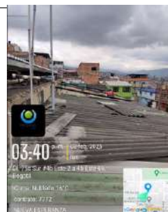
FECHA FOTO: 03/02/2025 DESCRIPCIÓN: Instalación de estructura para cubierta.
