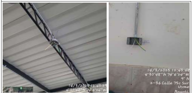
FECHA FOTO: DESCRIPCIÓN: Inicio del alambrado de las salidas eléctricas
