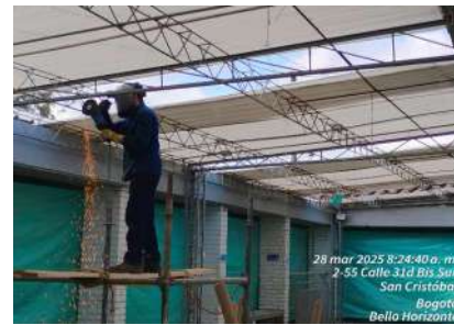
FECHA FOTO: 28/03/2025 DESCRIPCIÓN: desmonte de cubierta metalica
