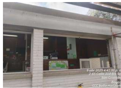
FECHA FOTO: 09/04/2025 DESCRIPCIÓN: Instalación de perfilera de ventanas
