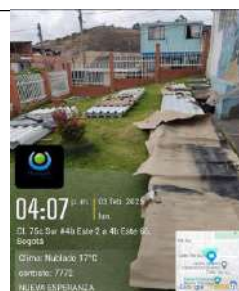
FECHA FOTO: 03/02/2025 DESCRIPCIÓN: Corte material para la cubierta.
