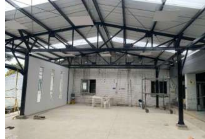
FECHA FOTO: 15/04/2025 DESCRIPCIÓN: aplicación de pintura en muro de drywall
