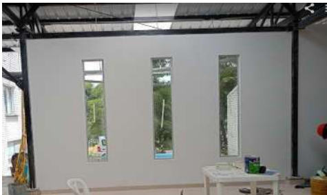
FECHA FOTO: 15/04/2025 DESCRIPCIÓN: Instalación de muro en drywall y perfilera de ventanas y vidrio
