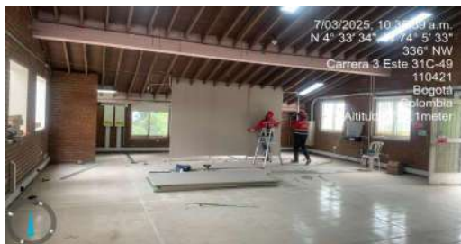
FECHA FOTO: 07/03/2025 DESCRIPCIÓN: Inatallación de draywall cuarto de maquinas
