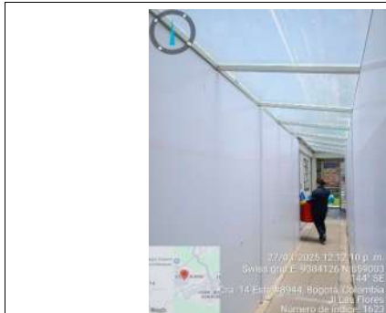
FECHA FOTO: 27/03/2025 DESCRIPCIÓN: Instalacion de cerramiento en policarbonato
