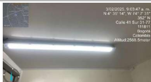
FECHA FOTO: 03/02/2025 DESCRIPCIÓN: Instalación luminarias
