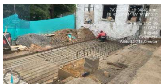
FECHA FOTO: 07/03/2025 DESCRIPCIÓN: Instalación y armado de acero en zona de rampa
