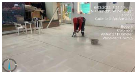
FECHA FOTO: 06/03/2025 DESCRIPCIÓN: Instalacion de boquilla en juntas de dilatación
