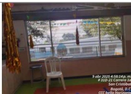
FECHA FOTO: 09/04/2025 DESCRIPCIÓN: instalacion de ventanas
