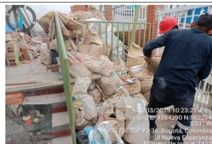
FECHA FOTO: DESCRIPCIÓN: Trabajos de recoleccion de Aseo y recoleccion de escombros
