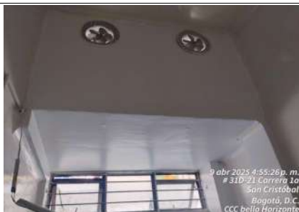
FECHA FOTO: 09/04/2025 DESCRIPCIÓN: pintura de zona afectada por filtracion de agua, se impermeabilizo la placa para superar el problema
