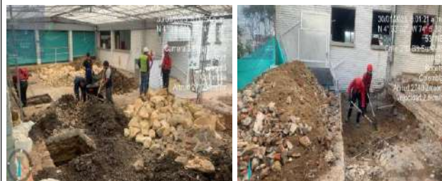
FECHA FOTO: 30/01/2025 DESCRIPCIÓN: Se realizan actividades de excavación y demolición de rampa y zapatas
