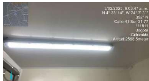
FECHA FOTO: 03/02/2025 DESCRIPCIÓN: Instalación luminarias
