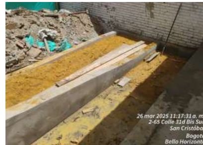
FECHA FOTO: 27/03/2025 DESCRIPCIÓN: extendida y compactacion de recebo
