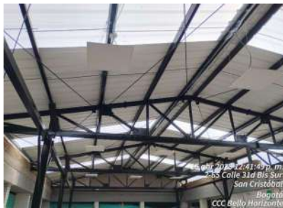
FECHA FOTO: 15/04/2025 DESCRIPCIÓN: Instalación de luminarias en zona social
