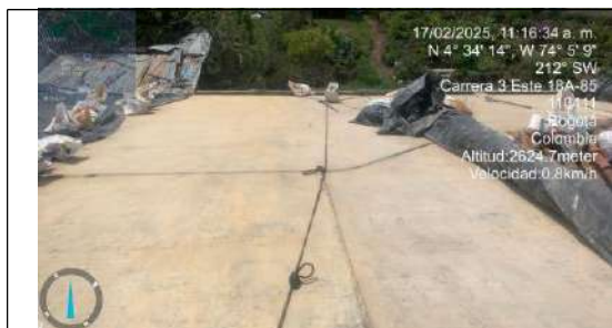
FECHA FOTO: 17/02/2025 DESCRIPCIÓN: Estado del frente
