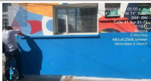
FECHA FOTO: 03/02/2025 DESCRIPCIÓN: Instalación pintura fachada
