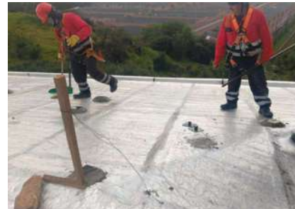
FECHA FOTO: 27/03/2025 DESCRIPCIÓN: Localizacion y repanteo de niveles para instalar cubierta
