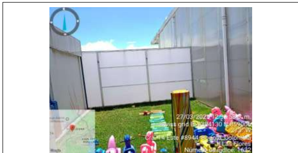
FECHA FOTO: 27/03/2025 DESCRIPCIÓN: Instalacion de cerramiento en policarbonato
