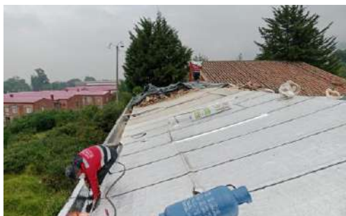
FECHA FOTO: 04/03/2025 DESCRIPCIÓN: Instalacion de manto impermeabilizante
