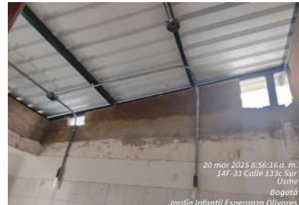
FECHA FOTO: 18/03/2025 DESCRIPCIÓN: pañete de remates de muro
