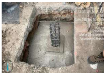
FECHA FOTO: 03/02/2025 DESCRIPCIÓN: Se realizaron actividades de fundida de zapatas y puesta de pedestales
