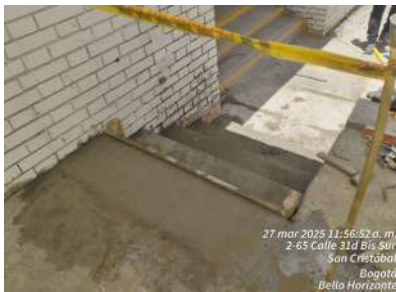
FECHA FOTO: 27/03/2025 DESCRIPCIÓN: fundida de escaleras en concreto
