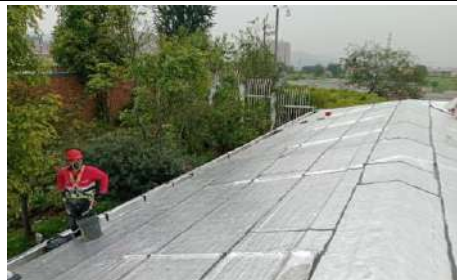
FECHA FOTO: 04/03/2025 DESCRIPCIÓN: Instalacion de manto impermeabilizante
