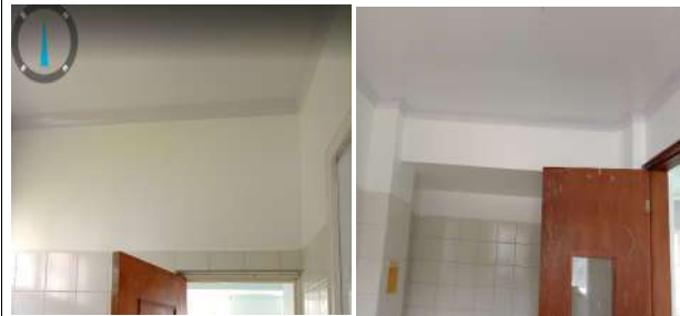
FECHA FOTO: 15/04/2025 DESCRIPCIÓN: Instalacion de media caña en PVC en sala lactante y Baños
