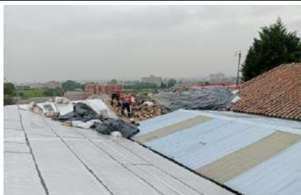
FECHA FOTO: 04/03/2025 DESCRIPCIÓN: Instalacion de manto impermeabilizante
