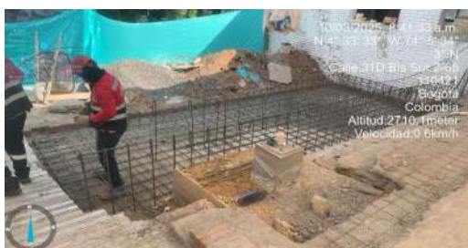
FECHA FOTO: 10/03/2025 DESCRIPCIÓN: Instalación y armado de acero en zona de rampa
