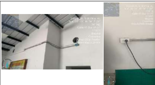
FECHA FOTO: 03/02/2025 DESCRIPCIÓN: Instalación redes electricas
