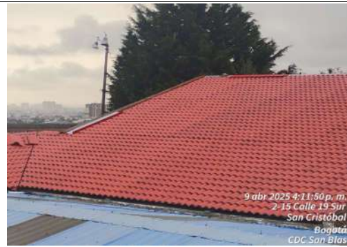
FECHA FOTO: 09/04/2025 DESCRIPCIÓN: Instalacion de cubierta y flanches
