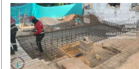
FECHA FOTO: 10/03/2025 DESCRIPCIÓN: Instalación y armado de acero en zona de rampa
