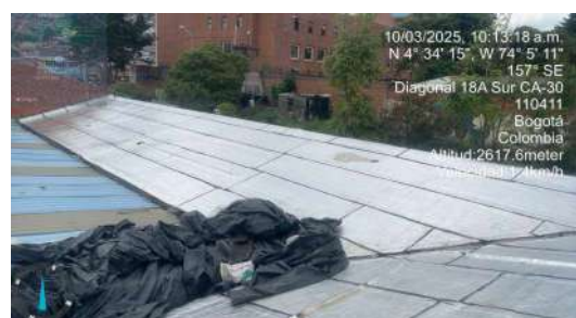
FECHA FOTO: 10/03/2025 DESCRIPCIÓN: Instalacion de manto impermeabilizante en cubierta y canal
