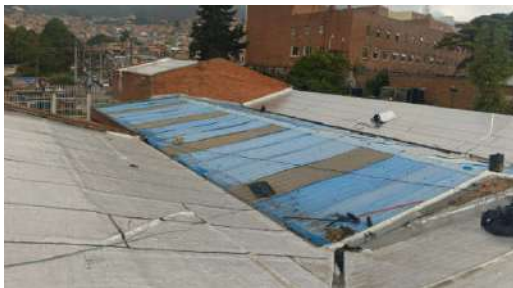
FECHA FOTO: 27/03/2025 DESCRIPCIÓN: Instalacion de manto impermeabilizante en cubierta y canal
