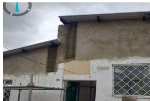
FECHA FOTO: DESCRIPCIÓN: Vista de fachada de entrada con perfiles metalicos fundidos con refuerzo de malla electrosoldada
