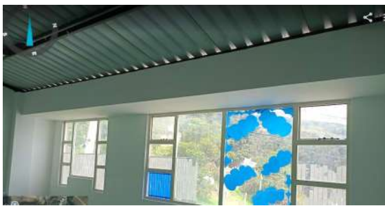
FECHA FOTO: 15/04/2025 DESCRIPCIÓN: aplicación de pintura en muros
