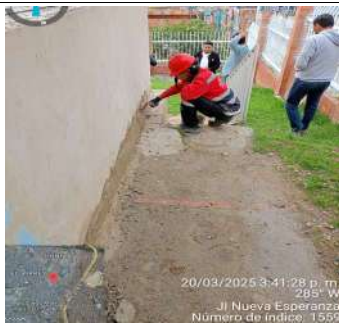
FECHA FOTO: 20/03/2025 3:41:28 p. m. DESCRIPCIÓN: Inicio de construccion de medias cañas.
