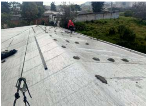
FECHA FOTO: 27/03/2025 DESCRIPCIÓN: nivelacion para instalar perfilera para soportar cubierta
