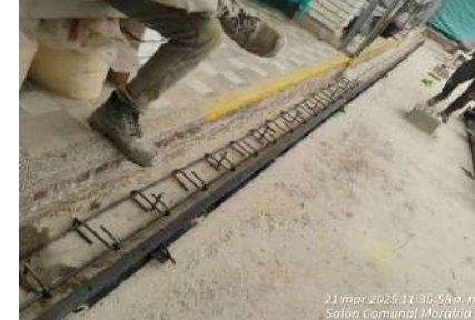
FECHA FOTO: 21/03/2025 DESCRIPCIÓN: acero para paso
