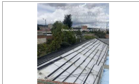
FECHA FOTO: 06/04/2025 DESCRIPCIÓN: Instalacion de perfiles metalicos para el soporte de la cubierta
