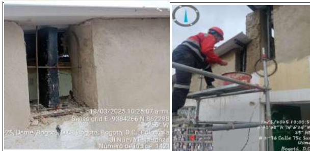
FECHA FOTO: DESCRIPCIÓN: Instalacion de malla electrosoldada en perfiles metalicos que soportan la cubierta.
