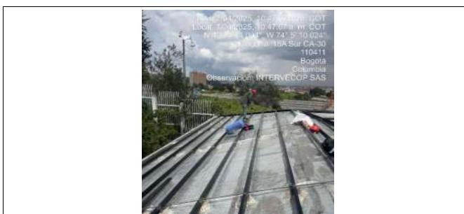
FECHA FOTO: 06/04/2025 DESCRIPCIÓN: Instalacion de perfiles metalicos para el soporte de la cubierta
