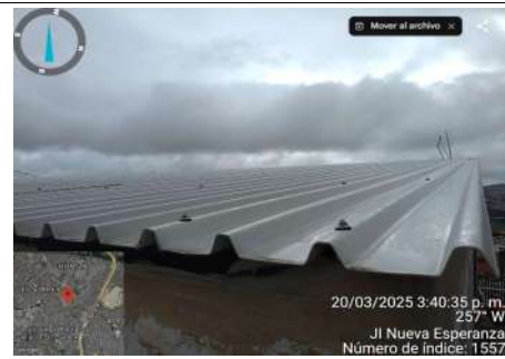
FECHA FOTO: 20/03/2025 3:40:35 p. m. DESCRIPCIÓN: Cubierta instalada en un 100%
