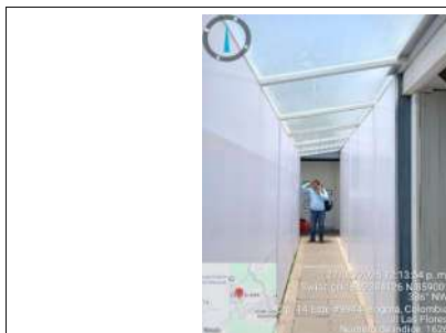
FECHA FOTO: 27/03/2025 DESCRIPCIÓN: Instalacion de cerramiento en policarbonato
