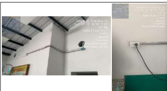
FECHA FOTO: 03/02/2025 DESCRIPCIÓN: Instalación redes electricas
