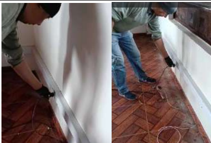
FECHA FOTO: 8/03/2025 DESCRIPCIÓN: Verificación de funcionamiento de red eléctrica.
