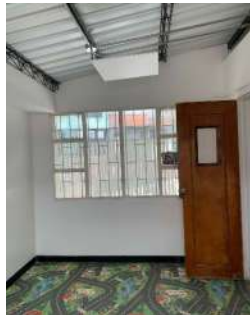
FECHA FOTO: 15/04/2025 DESCRIPCIÓN: aplicación de pintura en muros e instalacion de luminarias
