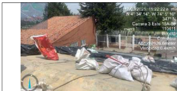
FECHA FOTO: 17/02/2025 DESCRIPCIÓN: Estado del frente
