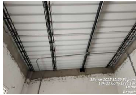
FECHA FOTO: 18/03/2025 DESCRIPCIÓN: Instalaciones eléctricas y remates de muro
