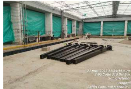
FECHA FOTO: 21/03/2025 DESCRIPCIÓN: Estructura metalica para la cubierta
