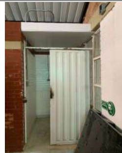
FECHA FOTO: 15/04/2025 DESCRIPCIÓN: instalacion de cielo raso en PVC en zona de enfermeria
