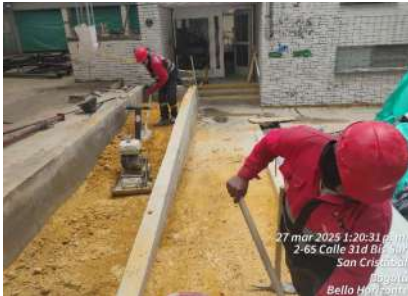
FECHA FOTO: 27/03/2025 DESCRIPCIÓN: extendida y compactacion de recebo
