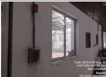
FECHA FOTO: 09/04/2025 DESCRIPCIÓN: Instalación de perfilera de ventanas y vidrio
