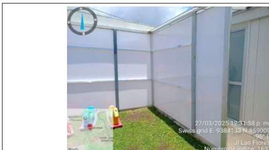
FECHA FOTO: 27/03/2025 DESCRIPCIÓN: Instalacion de cerramiento en policarbonato
