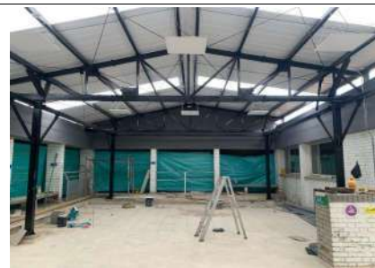
FECHA FOTO: 15/04/2025 DESCRIPCIÓN: Labores finales en Zona social
