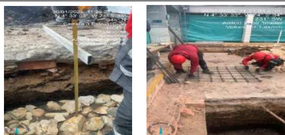
FECHA FOTO: 30/01/2025 DESCRIPCIÓN: Se realizan actividades de amarre de acero y puesta de concreto ciclopeo
