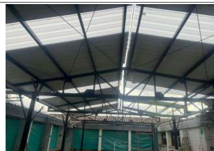
FECHA FOTO: 03/04/2025 DESCRIPCIÓN: Instalación de tejas para cubierta
