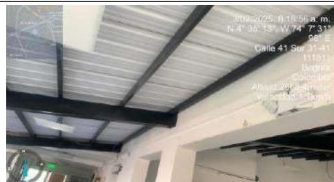
FECHA FOTO: 03/02/2025 DESCRIPCIÓN: Instalación pintura en estructura metalica
