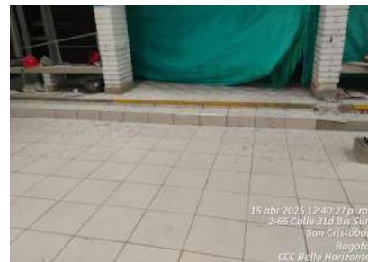
FECHA FOTO: 15/04/2025 DESCRIPCIÓN: Enchape de piso de zona social
