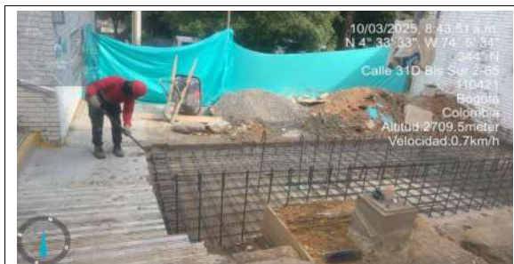
FECHA FOTO: 10/03/2025 DESCRIPCIÓN: Instalacion de acero para rampa de acceso a comedor
