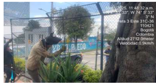
FECHA FOTO: 10/03/2025 DESCRIPCIÓN: Inatallación de nuevo cerramiento de fachada
