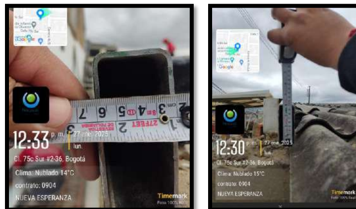
Imagen 3, Correas Instaladas.
