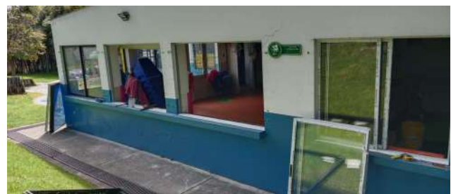
FECHA FOTO: 03/04/2025 DESCRIPCIÓN: desmonte de ventanas e instalacion de ventanas nuevas
