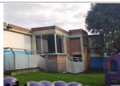
FECHA FOTO: 09/04/2025 DESCRIPCIÓN: instalacion de ventanas
