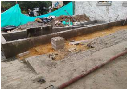
FECHA FOTO: 21/03/2025 DESCRIPCIÓN: extendida de recebo y compactacion, malla electrosoldada
