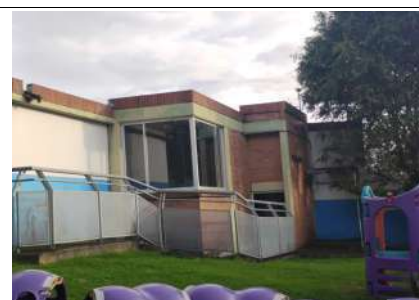
FECHA FOTO: 09/04/2025 DESCRIPCIÓN: instalacion de ventanas
