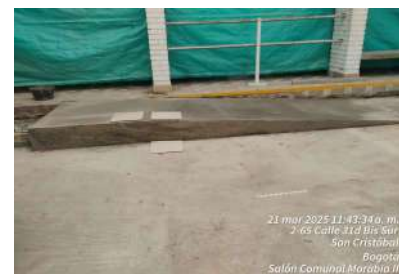
FECHA FOTO: 21/03/2025 DESCRIPCIÓN: fundida de rampa
