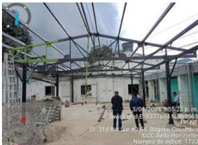
FECHA FOTO: 03/04/2025 DESCRIPCIÓN: Instalación de perfileria metalica para cubierta
