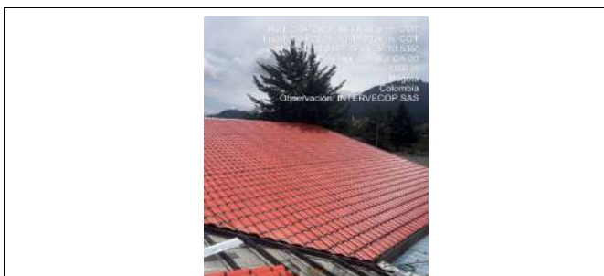
FECHA FOTO: 06/04/2025 DESCRIPCIÓN: Instalacion de perfiles tejas sobre los perfiles metalicos
