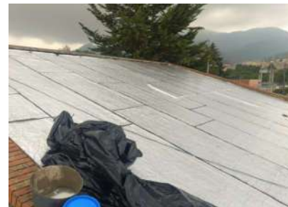
FECHA FOTO: 27/03/2025 DESCRIPCIÓN: Instalacion de manto impermeabilizante en cubierta y canal
