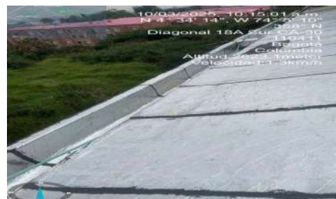
FECHA FOTO: 10/03/2025 DESCRIPCIÓN: Instalacion de manto impermeabilizante en cubierta y canal
