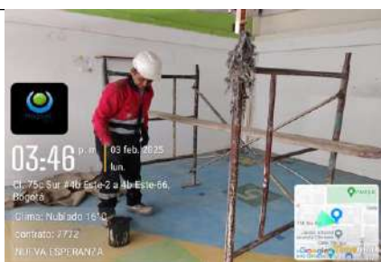
FECHA FOTO: 03/02/2025 DESCRIPCIÓN: Pintura para estructura en cubierta.
