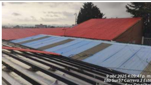
FECHA FOTO: 09/04/2025 DESCRIPCIÓN: Instalacion de cubierta y flanches
