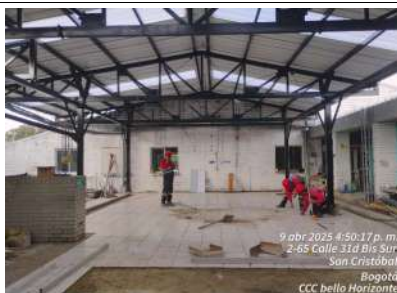
FECHA FOTO: 09/04/2025 DESCRIPCIÓN: Enchape de piso de zona social
