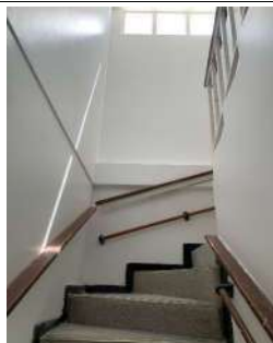
FECHA FOTO: 15/04/2025 DESCRIPCIÓN: aplicación de pintura en muros
