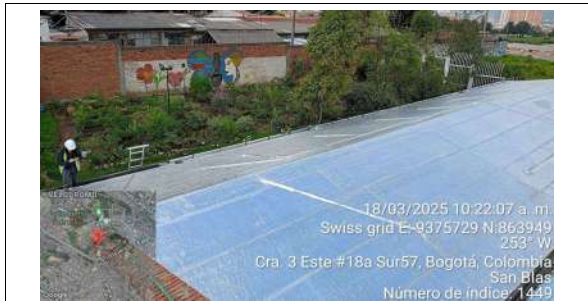
FECHA FOTO: 18/03/2025 DESCRIPCIÓN: Instalacion de manto impermeabilizante en cubierta y canal
