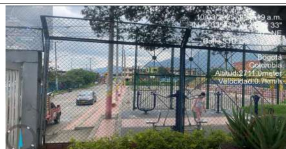
FECHA FOTO: 10/03/2025 DESCRIPCIÓN: Labores de mantenimiento de reja existente o reposicion con malla nueva.
