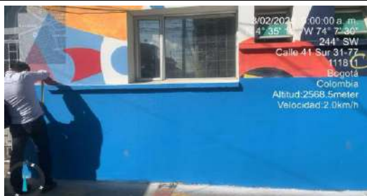
FECHA FOTO: 03/02/2025 DESCRIPCIÓN: Instalación pintura fachada
