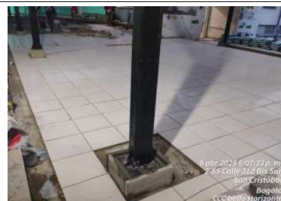
FECHA FOTO: 09/04/2025 DESCRIPCIÓN: Enchape de piso de zona social
