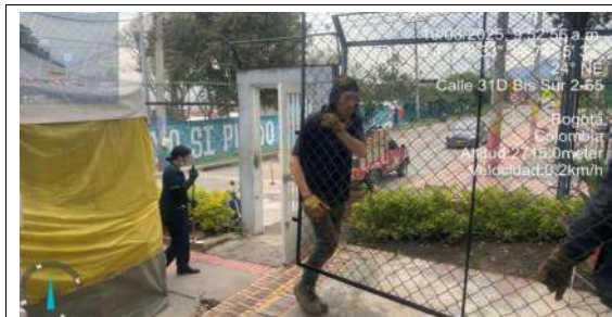
FECHA FOTO: 10/03/2025 DESCRIPCIÓN: Labores de mantenimiento de reja existente o reposición con malla nueva.
