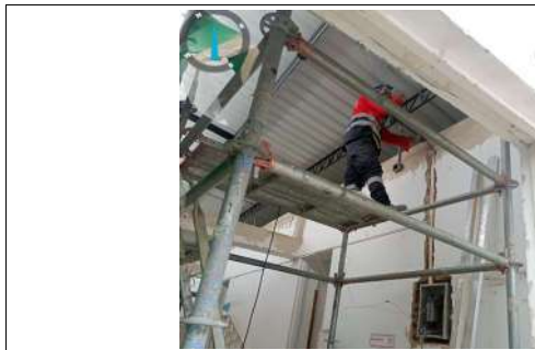
FECHA FOTO: DESCRIPCIÓN: demolicion de pañete existente para instalacion de redes electricas
