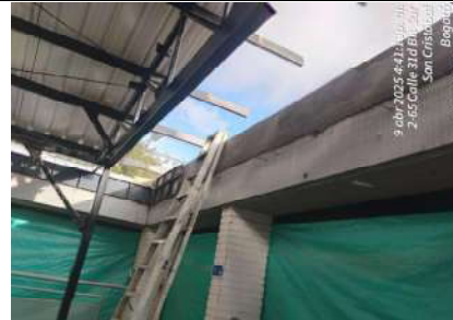
FECHA FOTO: 09/04/2025 DESCRIPCIÓN: fundida de viga perimetral para evitar ingreso de agua
