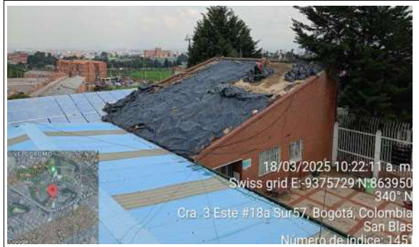
FECHA FOTO: 18/03/2025 DESCRIPCIÓN: Demolición de cubierta y embalaje de residuos de construcción
