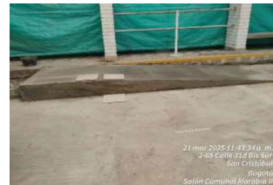
FECHA FOTO: 21/03/2025 DESCRIPCIÓN: fundida de rampa
