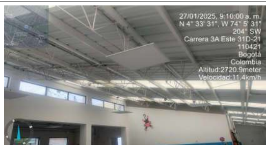
FECHA FOTO: 27/01/2025 DESCRIPCIÓN: Instalación de puntos electricos y luminarias panel led 60x60 en comedor
