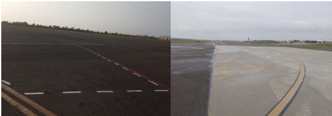
Ilustración 7 Estado actual de la Plataforma del Aeropuerto
