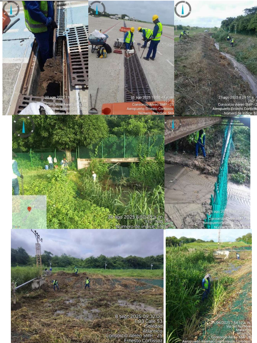
Limpieza de canales
