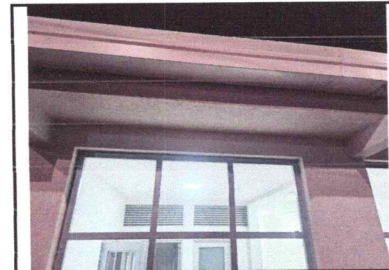
Descripción: Instalacion de Superboard
