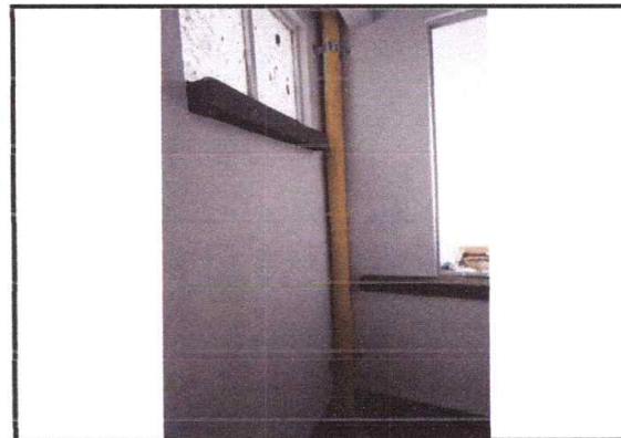
Descripción: Instalacion de Bajantes
