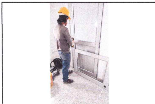
Descripción: Instalacion Puertas
