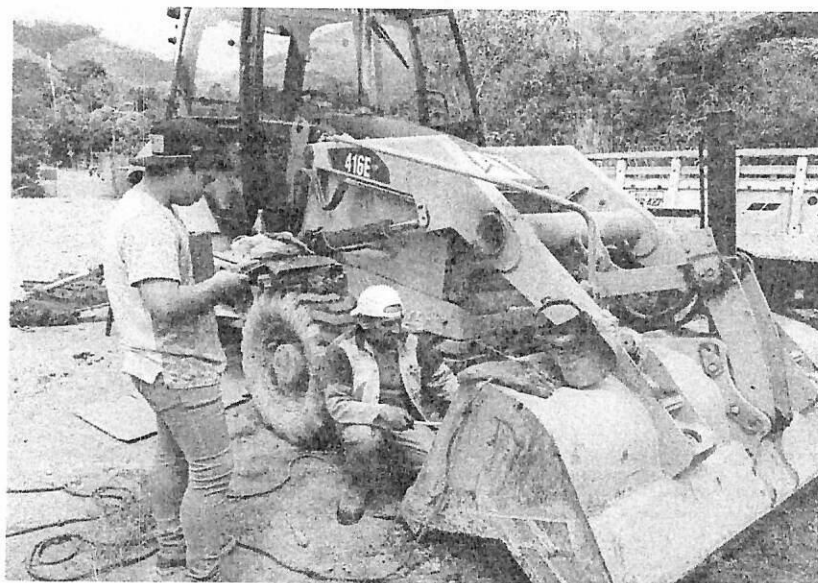
Relleno en soldadura a rotulas de retrocargador 416E
