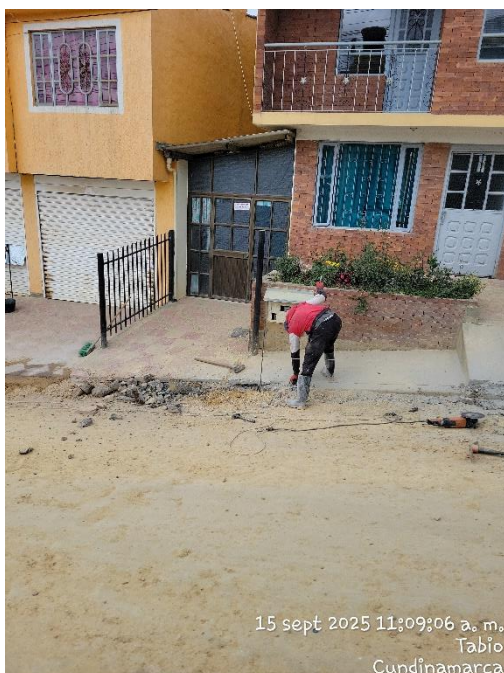
FOTO NO. 3 EXCAVACION MANUAL
