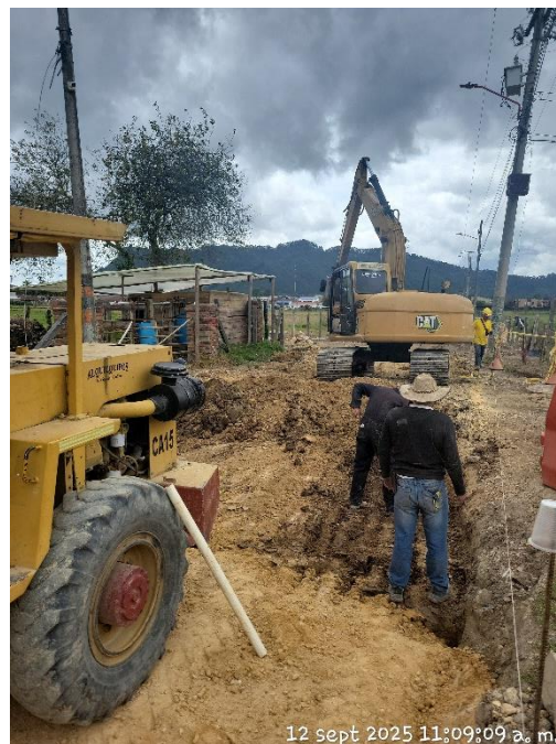
FOTO NO. 2 EXCAVACION A MAQUINA
