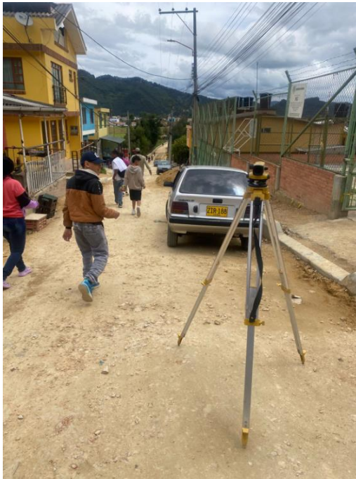
FOTO NO. 15 EQUIPO TOPOGRAFICO
