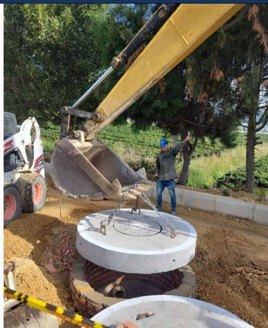
FOTO NO. 20 CARGUE Y TAPA PARA POZO
