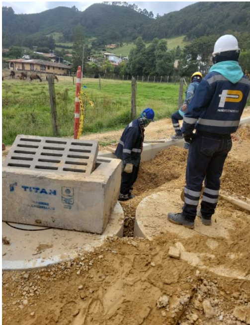
FOTO NO. 13 SUMIDERO PREFABRICADO
