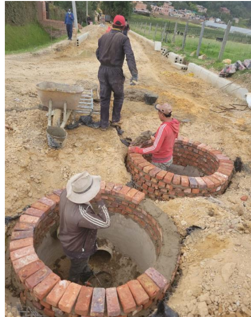
FOTO NO. 14 NIVELACION DE POZOS
