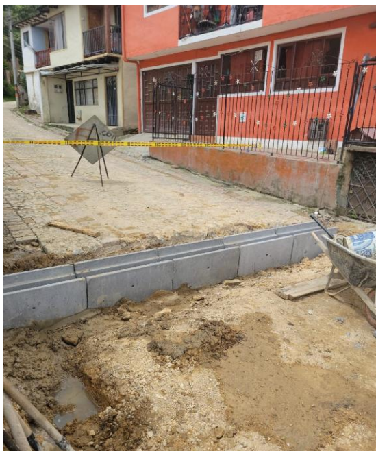
FOTO NO. 17 INSTALACION DE CARCAMO
