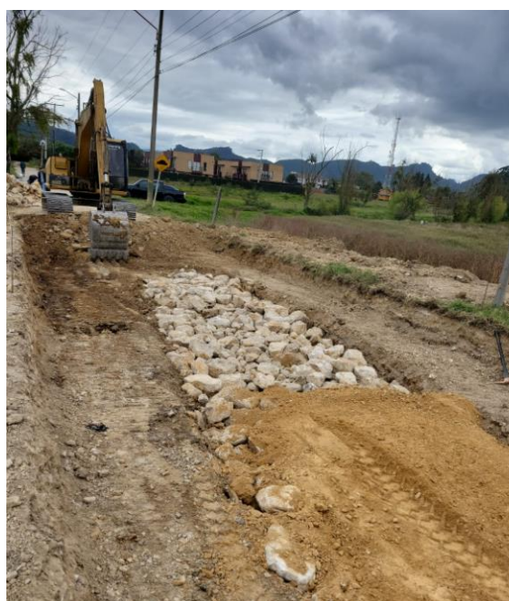
FOTO NO. 18 INSTALACION DE RAJON
