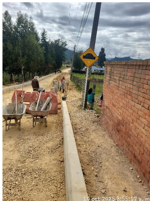
FOTO NO. 10 INSTALACION DE SARDINEL
