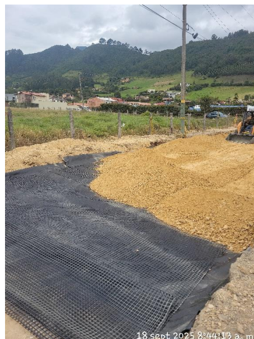
FOTO NO. 4 INSTALACION GEOTEXTIL
