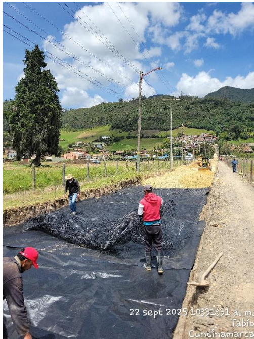
FOTO NO. 5 INSTALACION GEOMALLA
