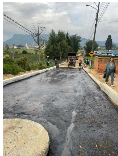
FOTO NO. 8 RIEGO DE IMPRIMACION
