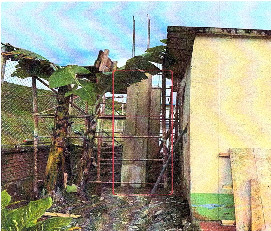
Foto 39. Retiro y demolición de viga aérea en concreto, garantizando la disposición adecuada del material demolido.
