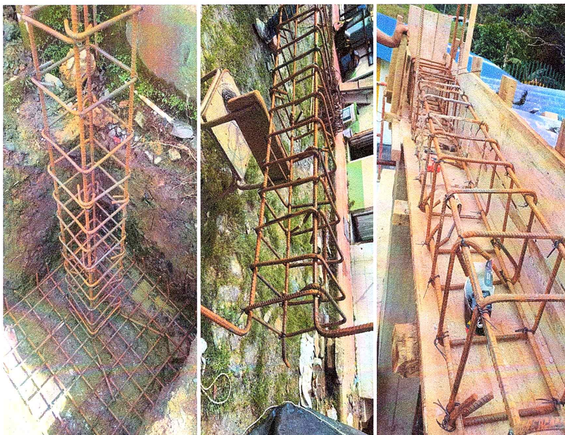
Foto 36, 37 y foto 38. suministro, figurado y amarre de acero para las zapatas, columnas y vigas del tanque de reserva.
