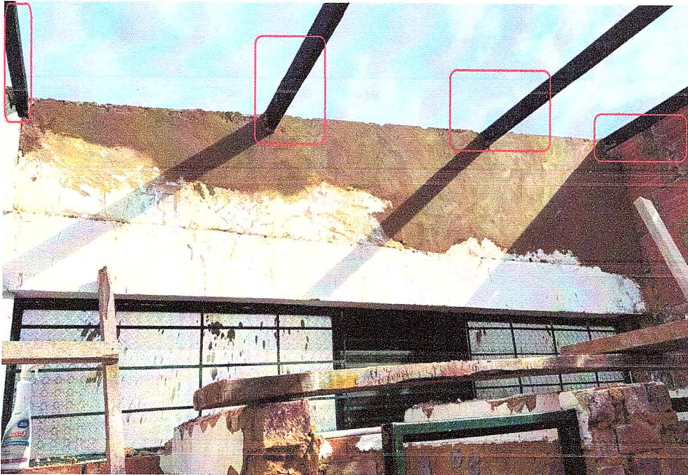
Foto 15. suministro y aplicación de esmalte en lámina lineal con tres manos, con el fin de garantizar protección, durabilidad y acabado uniforme.
