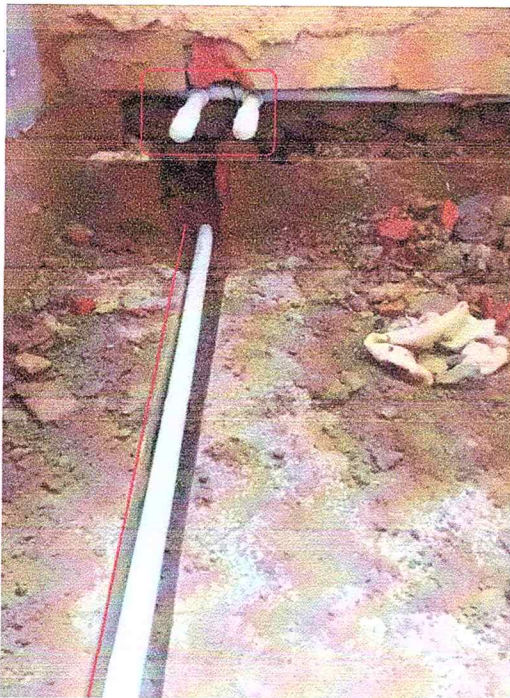
Foto 11. Instalación y suministro de puntos hidráulicos.
