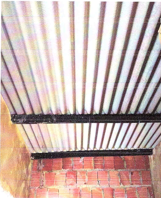
Foto 19. Pintura de alta resistencia al desgaste y antideslizante en tres manos, con el fin de proporcionar una superficie duradera, segura y con acabado uniforme.
