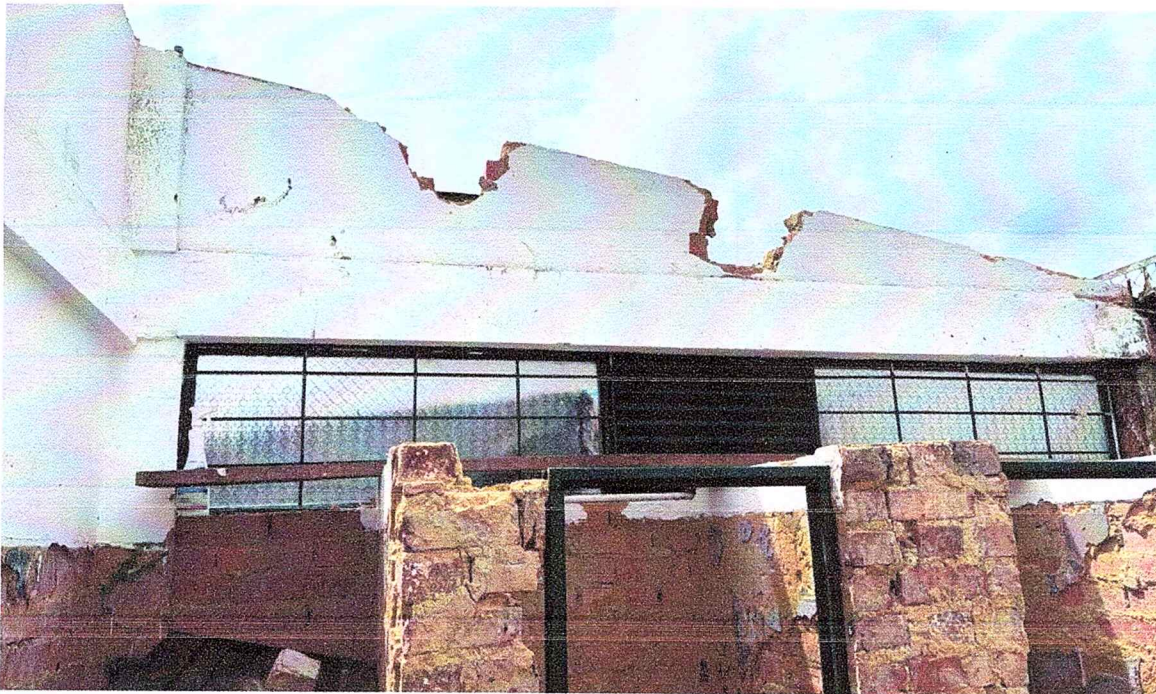
Foto 8. retiro controlado de las tejas de asbesto de la cubierta existente, Incluyendo acarreo.
