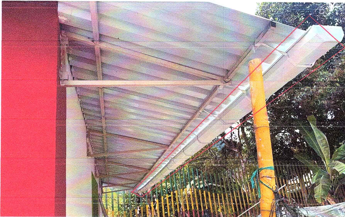
Foto 26. Instalación de canal para recolección de aguas lluvias en lámina galvanizada.
