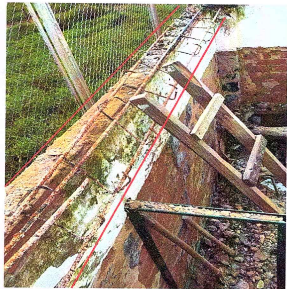
Foto 7. Retiro y demolición de viga aérea en concreto, garantizando la disposición adecuada del material demolido.
