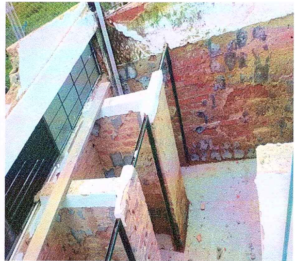
Foto 4. Demolición enchapes muro y mesones.
