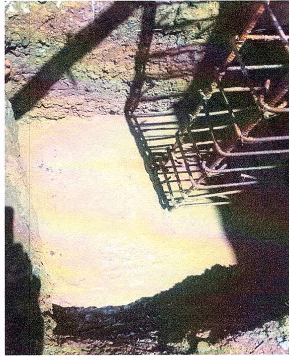
Foto 35. Construcción de 2 Zapatas; para Construcción de Placa para Tanques de Reserva.
