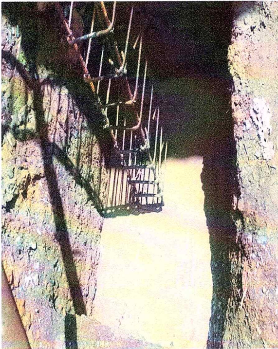
Foto 34. Construcción de 2 Zapatas; para Construcción de Placa para Tanques de Reserva.
