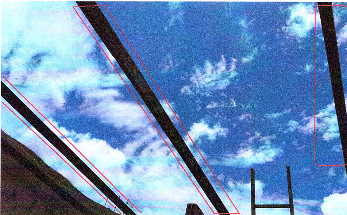
Foto 28 Instalación de perflería metálica estructural.
