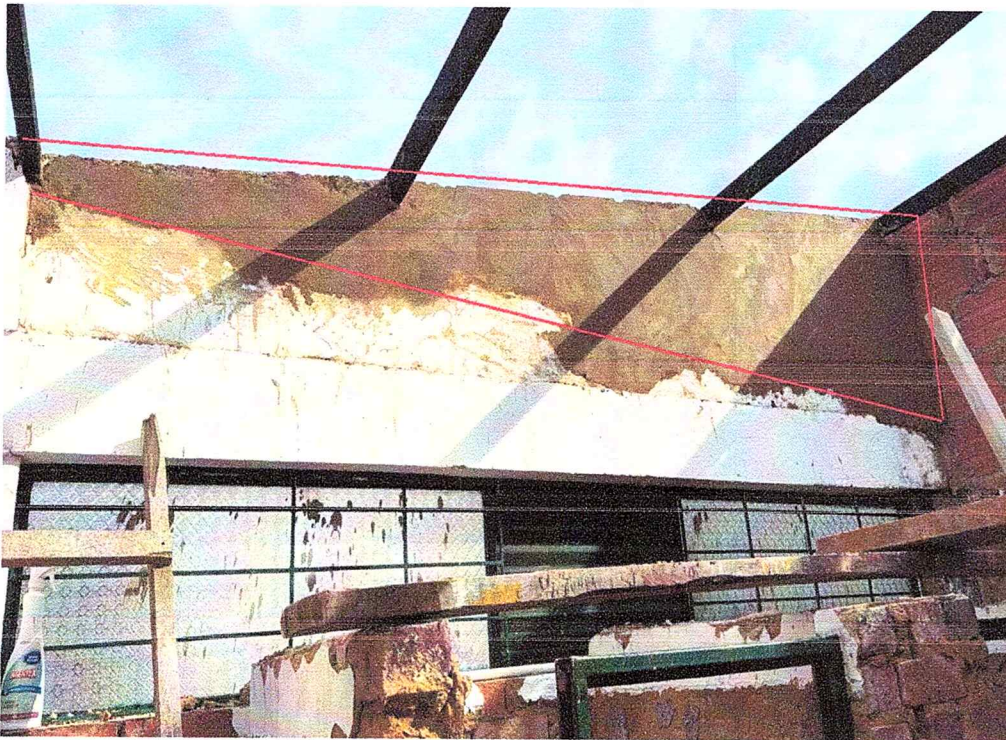
Foto 10. pañete liso en las tres culatas, cubriendo todas sus caras para uniformar y proteger los muros.
