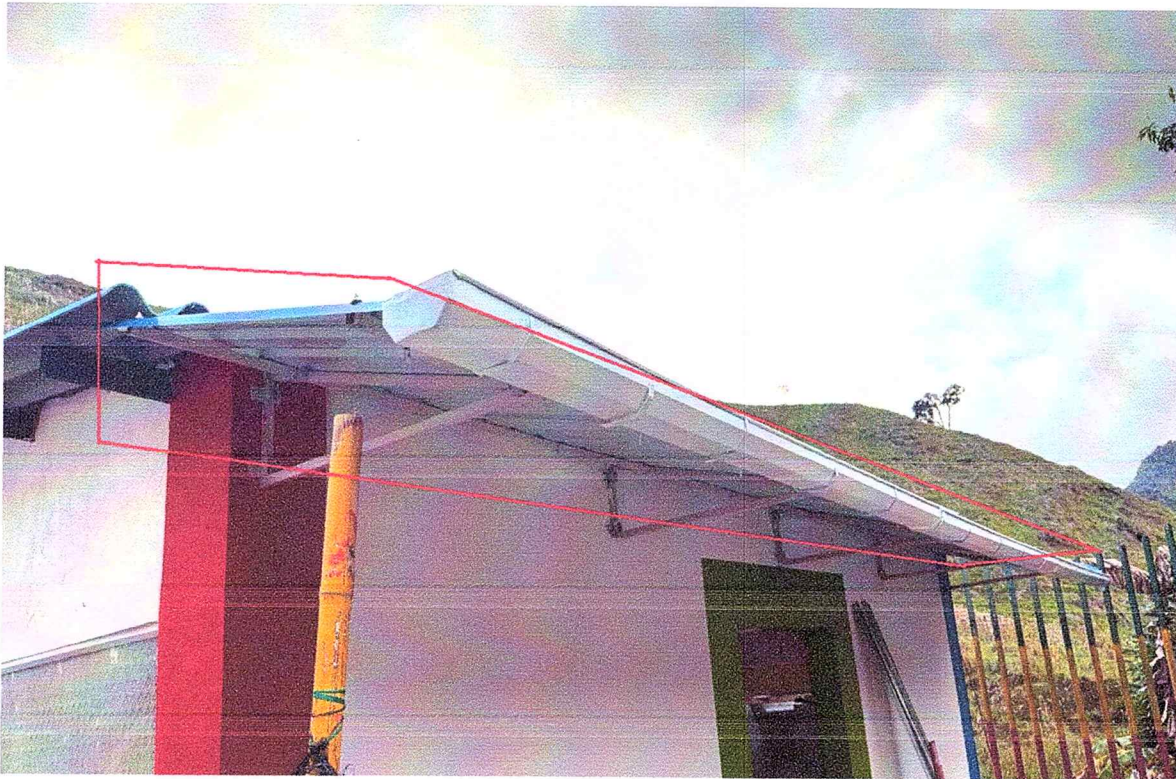
Foto 25 suministro e instalación de cubierta galvanizada tipo trapezoidal para el voladizo de la fachada frontal.
