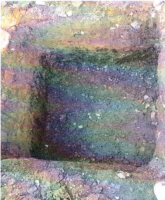
Foto 32. Realizó la excavación para construcción de 2 Zapatas para Tanques de Reserva
