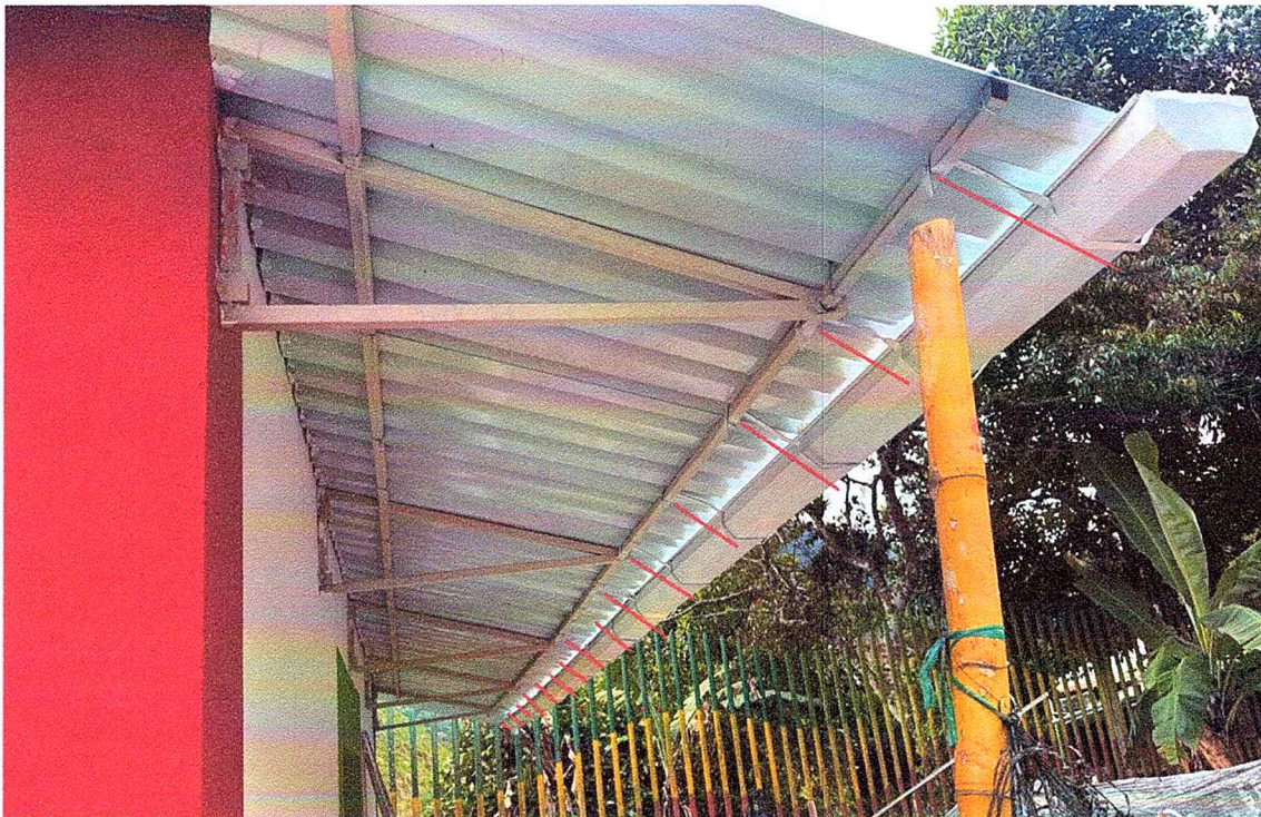
Foto 40 Instalación de soportes metálicos para el sistema de canal de aguas lluvias, incorporando labores de soldadura y aplicación de pintura protectora.
