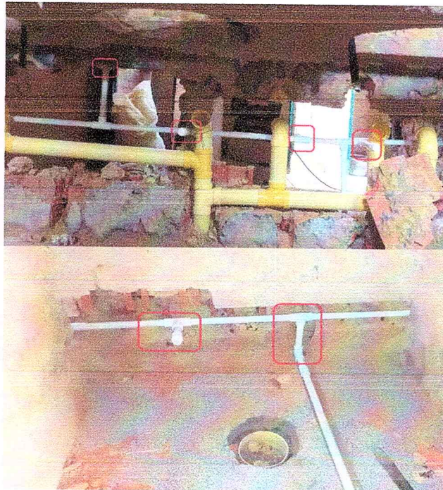
Foto 12. Instalación y suministro de puntos hidráulicos.
