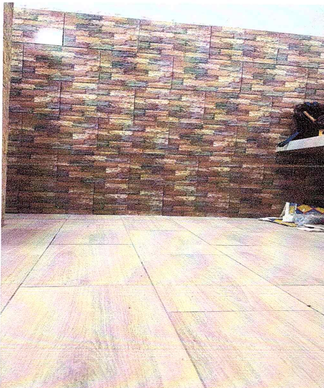
Foto 21 Suministro e instalación de cerámica en pisos y muros, garantizando nivelación, adherencia y acabado uniforme.
