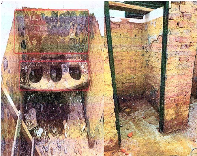
Foto 3. Demolición enchapes muro y mesones.
