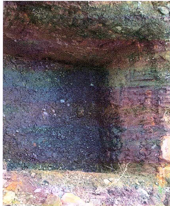
Foto 33. Realizó la excavación para construcción de 2 Zapatas para Tanques de Reserva
