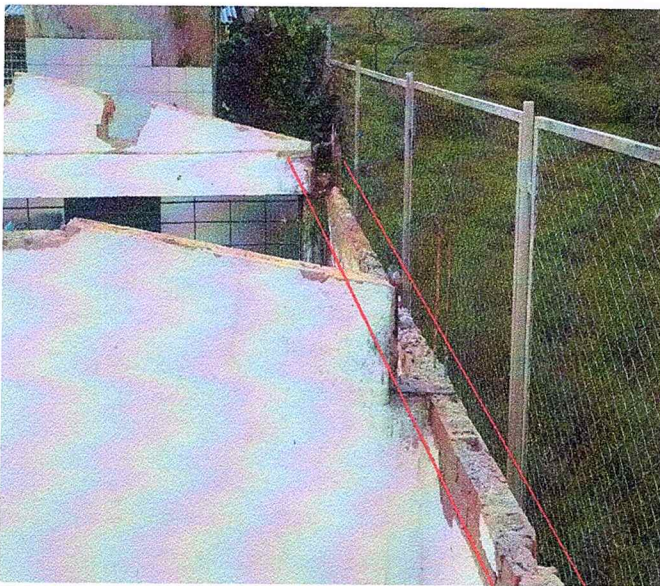
Foto 6. Retiro y demolición de viga aérea en concreto, garantizando la disposición adecuada del material demolido.
