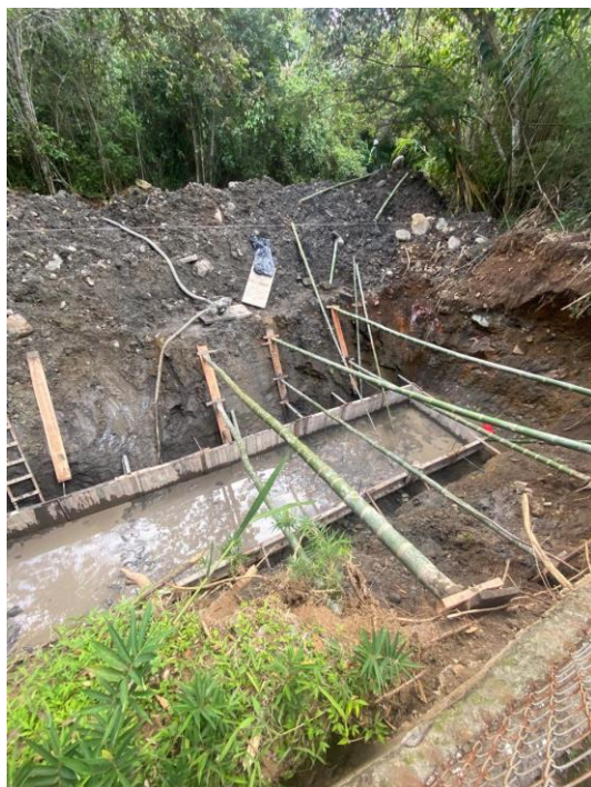
Ilustración 8 Estructura de contención
