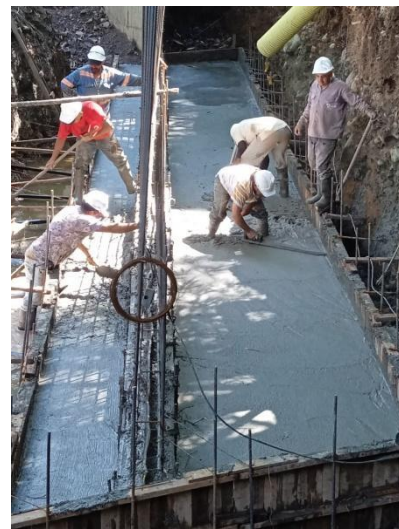
Ilustración 17 Suministro concreto para zapata.
