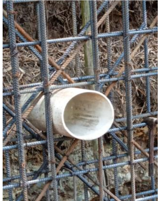
Ilustración 13 Pase de tubería.
