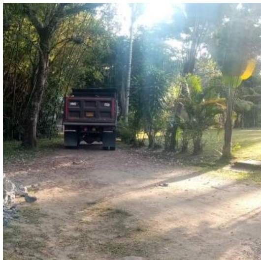
Ilustración 16 Retiro de escombros
