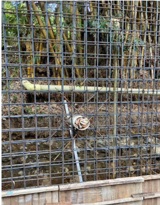
Ilustración 12 Pase de tubería.
