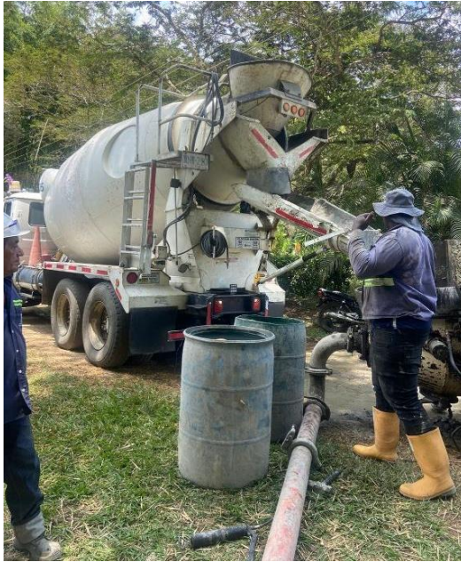
Ilustración 18 Suministro concreto para muro
