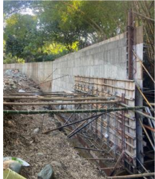
Ilustración 19 Suministro concreto para muro
