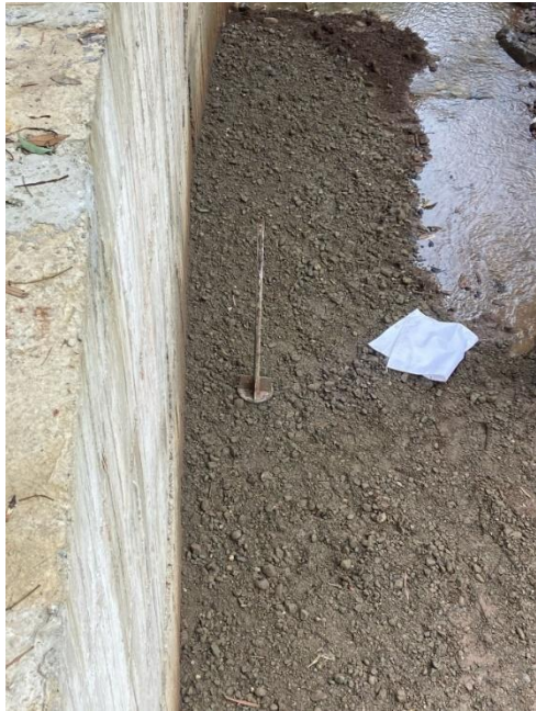
Ilustración 14 Compactación base Bolsacreto.
