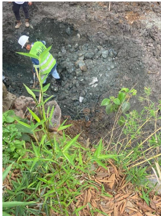
Ilustración 7 Demolición de roca.
