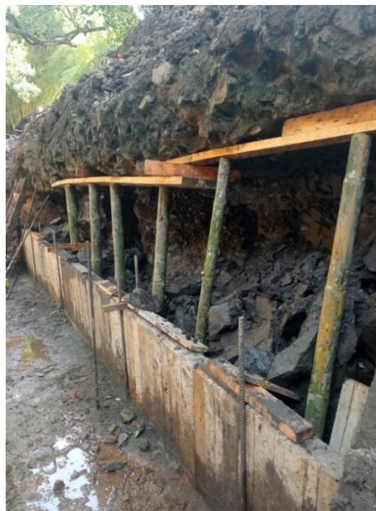
Ilustración 9 Estructura de contención
