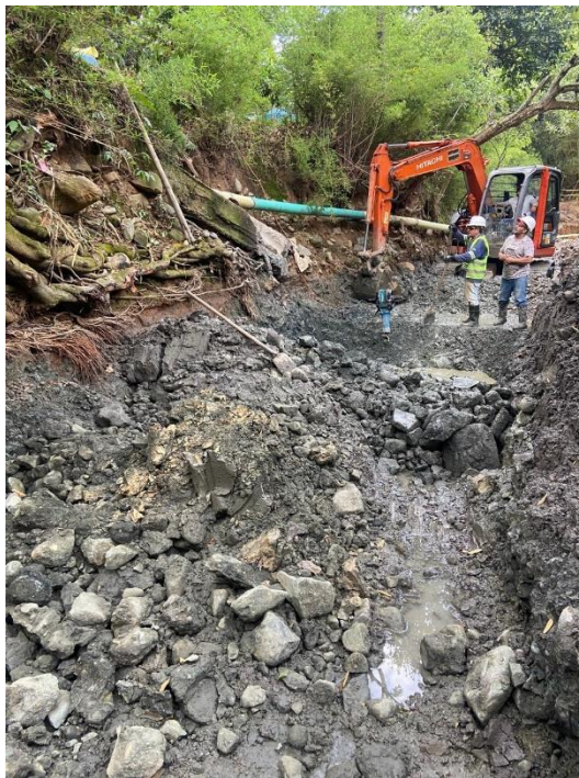
Ilustración 6 Perforación y fragmentación lecho rocoso.
