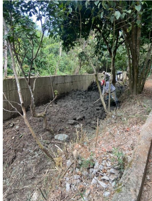
Ilustración 15 Relleno y compactación cara interna muro.
