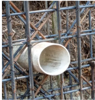
Fotografía 6 . pase de tubería novafort 8" para desagüe de ptar
