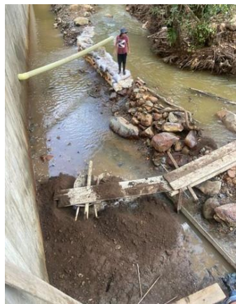
Fotografía 8. COMPACTACION DE RELLENO/BASE DE BOLSA CRETO
