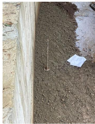
Fotografía 8. COMPACTACION DE RELLENO/BASE DE BOLSA CRETO
