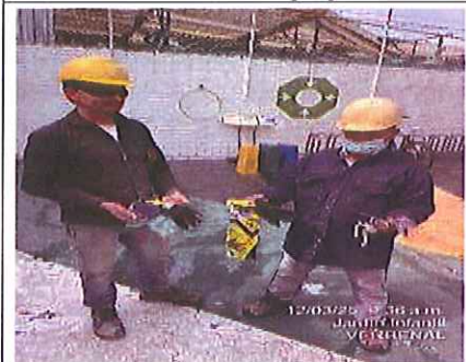
Foto 133. Entrega de EPP en frente de obra Verbenal.
