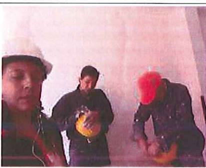
Foto 41. Charla de seguridad y pausas activas al personal en frente de obra El Recreo. FUENTE: Elaboración propia
