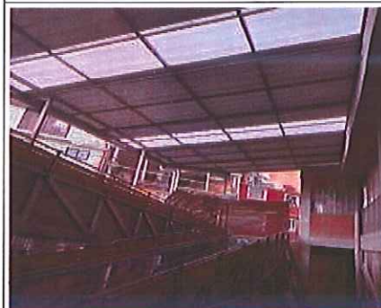
Foto 73. Actividades de instalación de teja en frente de obra Juan XXI. FUENTE: Elaboración propia
