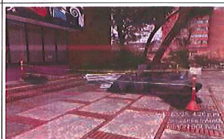
Foto 156. Instalación de señalización en frente de obra Simón Bolívar FUENTE: Elaboración propia
