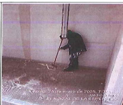
Foto 32. Jornada de orden aseo y limpieza en frente de obra Nogal de la esperanza. FUENTE: Elaboración propia
