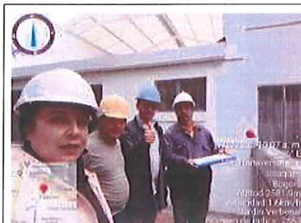
Foto 121. Charla de seguridad y pausas activas al personal en frente de obra Verbenal. FUENTE: Elaboración propia
