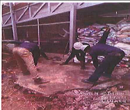
Foto 106. Charla de seguridad pausas activas en frente de obra Juan XXIII. FUENTE: Elaboración propia
