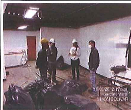
Foto 115. Charla de seguridad en frente de obra Simón Bolívar FUENTE: Elaboración propia
