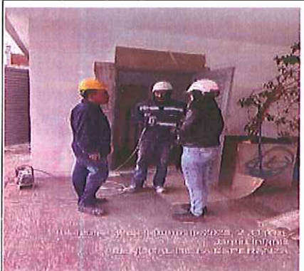
Foto 10. Charla de seguridad en frente de obra Nogal de la esperanza. FUENTE: Elaboración propia
