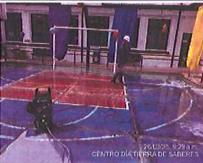
Foto 191. Manatienimiento de cancha frente de obra Centro de tierra de saberes. FUENTE: Elaboración propia
