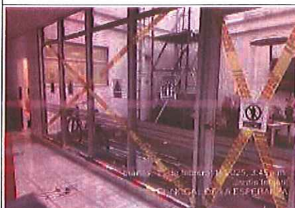
Foto 163. Señalización en frente de obra Nogal. FUENTE: Elaboración propia
