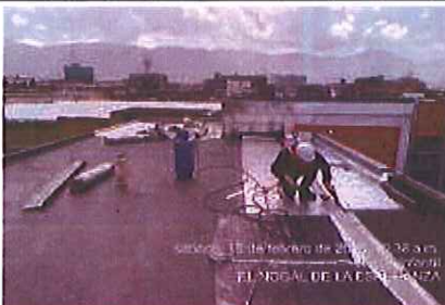
Foto 170. Instalación de manto en frente de obra Nogal. FUENTE: Elaboración propia
