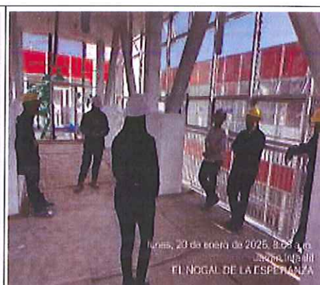
Foto 9. Charla de seguridad en frente de obra Nogal de la esperanza. FUENTE: Elaboración propia
