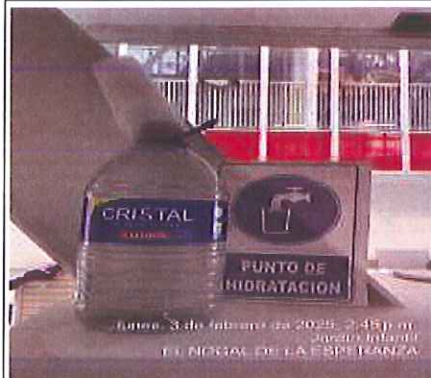
Foto 25. Instalación de punto de hidratación en frente de obra Nogal de la esperanza. FUENTE: Elaboración propia
