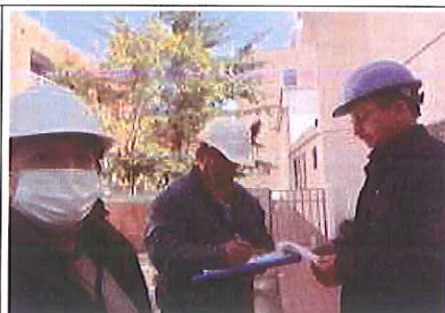
Foto 54. Charla de seguridad y pausas activas al personal en frente de obra Verbenal.
