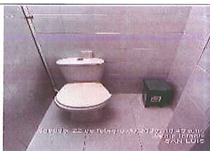
Foto 158. Inspección de unidad de baño el frente de obra San Luis. FUENTE: Elaboración propia
