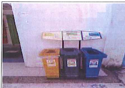
Foto 61. Inspección de punto ecológico en frente de obra El Verbenal. FUENTE: Elaboración propia
