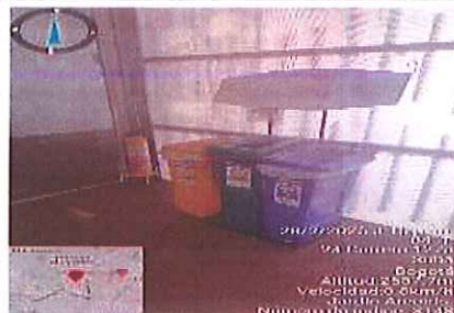
Foto 184. Inspección de punto ecológico sanitaria en frente de obra Arcoiris. FUENTE: Elaboración propia
