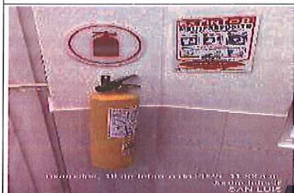
Foto 160. Inspección de Kit de emergencias en frente de obra San Luis. FUENTE: Elaboración propia
