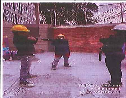
Foto 127. Charla de seguridad y pausas activas al personal en frente de obra Verbenal. FUENTE: Elaboración propia
