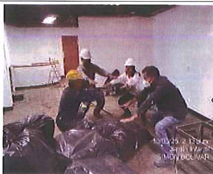
Foto 116. Charla de seguridad y pausas activas en frente de obra Simón Bolívar. FUENTE: Elaboración propia
