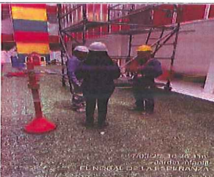
Foto 201. Charla de seguridad y pausas activas al personal en frente de obra Nogal.
