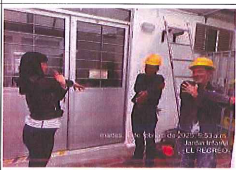
Foto 42. Charla de seguridad y pausas activas al personal en frente de obra El Recreo. FUENTE: Elaboración propia
