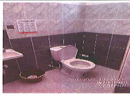
Foto 144. Inspección de unidad de baño sanitaria en frente de obra el Verbenal. FUENTE: Elaboración propia
