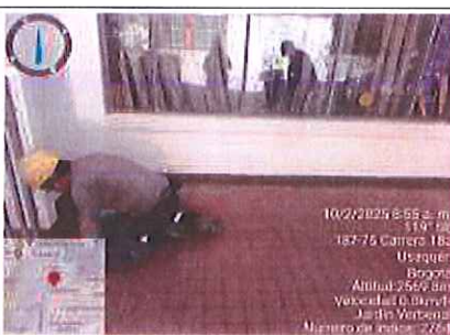
Foto 62. Actividades de remates en frente de obra El Verbenal. FUENTE: Elaboración propia
