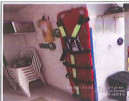
Foto 148. Inspección de Kit de emergencias en frente de obra Tibabita. FUENTE: Elaboración propia
