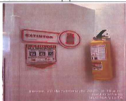
Foto 178. Inspección de Kit de emergencias en frente de obra Buena vista FUENTE: Elaboración propia
