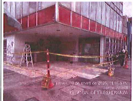
Foto 30. Señalización en los frentes de trabajo obra Nogal de la esperanza. FUENTE: Elaboración propia
