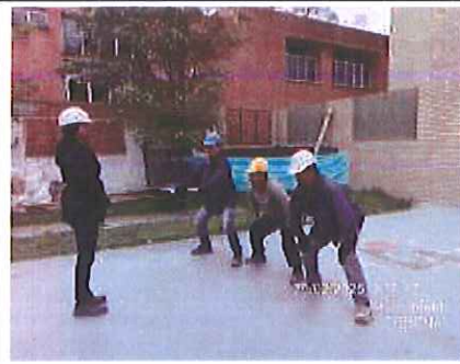
Foto 131. Charla de seguridad y pausas activas al personal en frente de obra Verbenal.
