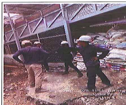
Foto 109. Charla de seguridad pausas activas en frente de obra Juan XXIII. FUENTE: Elaboración propia
