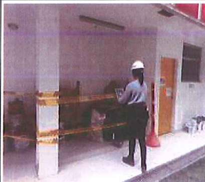
Foto 26. Instalación señalización de material en frente de obra Nogal de la esperanza. FUENTE: Elaboración n propia
