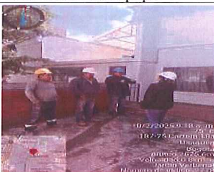
Foto 56. Charla de seguridad y pausas activas al personal en frente de obra Verbenal.
