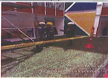
Foto 198. Señalización y cerramiento de perimetral en el frente de obra.
