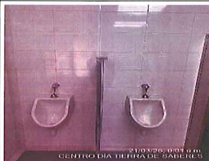
Foto 196. Inspección de unidad de baños sanitarios frente de obra Centro de tierra de saberes
