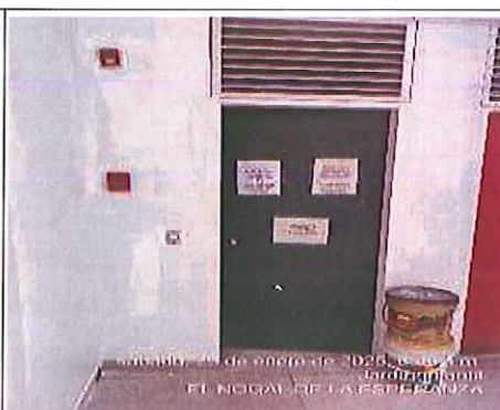
Foto 21. Instalación de señalización preventiva informativa en frente de obra Nogal de la esperanza. FUENTE: E elaboración propia
