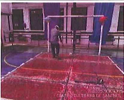
Foto 190. Manatienimiento de cancha frente de obra Centro de tierra de saberes. FUENTE: Elaboración propia
