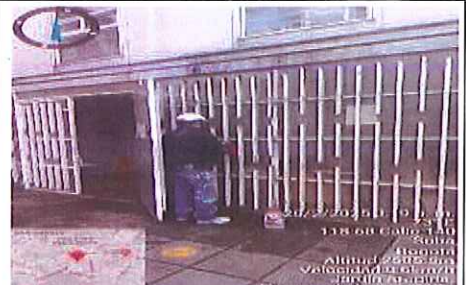
Foto 186. Jornada de orden y aseo en frente de obra Arcoiris. FUENTE: Elaboración propia
