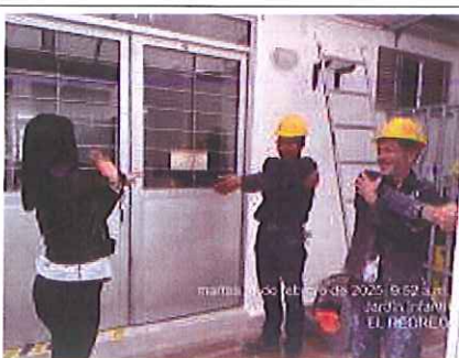
Foto 44. Charla de seguridad y pausas activas al personal en frente de obra El Recreo. FUENTE: Elaboración propia
