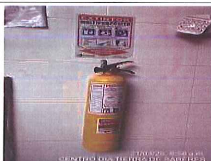
Foto 194. Inspección de Kit de emergencias en frente de obra Centro de tierra de saberes.
