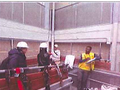
Foto 65. Charla de seguridad y diligenciamiento de ATS activas al personal en frente de obra Juan XXI. FUENTE: Elaboración propia
