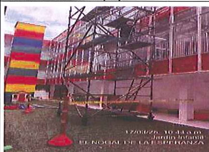
Foto 197. Instalación de señalización preventiva informativa y de obligatoriedad los frentes de obra.
