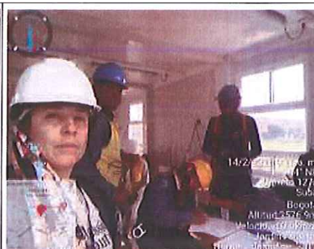
Foto 93. Diligenciamiento de permisos y charla de seguridad de obra Arcoíris. FUENTE: Elaboración propia
