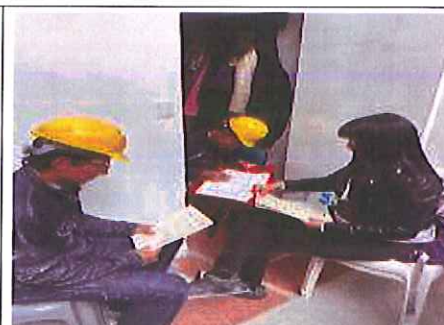
Foto 45. Charla de seguridad y pausas activas al personal en frente de obra El Recreo. FUENTE: Elaboración propia
