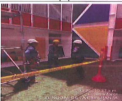
Foto 200. Charla de seguridad y pausas activas al personal en frente de obra Nogal.
