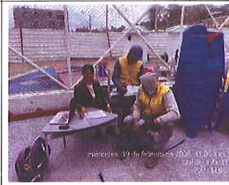
Foto 114. Charla de seguridad y diligenciamiento de ATS en frente de obra San Luis. FUENTE: Elaboración propia
