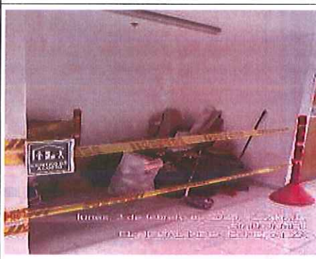
Foto 24. Señalización de material en frente de obra Nogal de la esperanza. FUENTE: Elaboración propia
