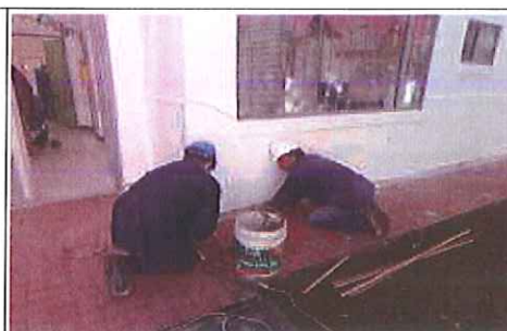
Foto 63. Actividades de pintura en frente de obra El Verbenal. FUENTE: Elaboración propia
