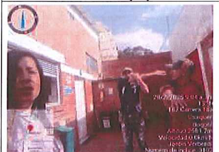
Foto 124. Charla de seguridad y pausas activas al personal en frente de obra Verbenal. FUENTE: Elaboración propia
