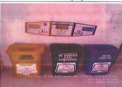
Foto 50. Inspección de punto ecológico en frente de obra El Recreo. FUENTE: Elaboración propia
