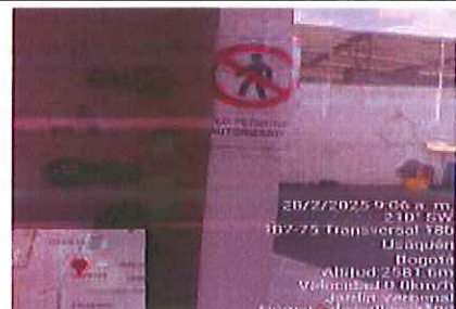
Foto 137. Instalación de señalización en frente de obra Verbenal.
