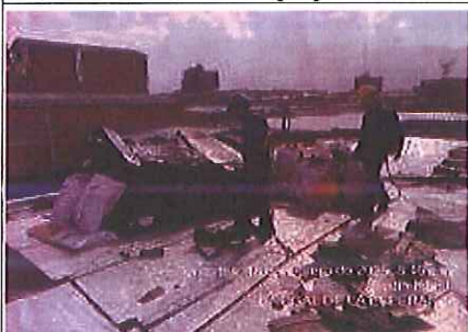
Foto 172. Jornada de orden aseo y limpieza en frente de obra Nogal. FUENTE: Elaboración propia
