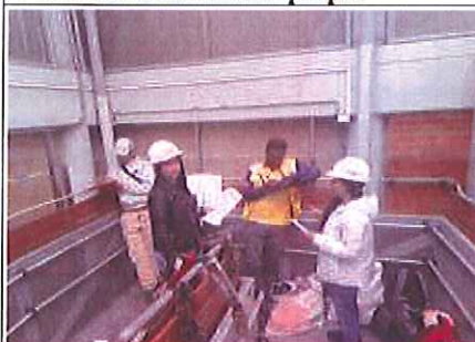
Foto 64. Charla de seguridad y diligenciamiento de ATS activas al personal en frente de obra Juan XXI. FUENTE: Elaboración propia
