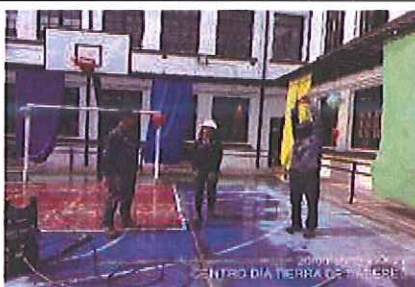
Foto 188. Charla de seguridad y pausas activas al personal en frente de obra Centro tierra de saberes. FUENTE: Elaboración propia
