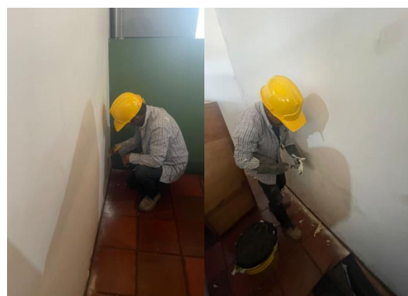
PINTURA MUROS INTERIORES - CHOCONTA
