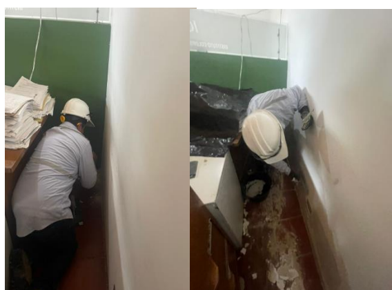
RESANE EN MUROS INTERIORES - CHOCONTA
