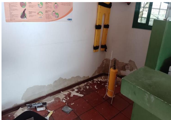
ESCARIFICACIÓN DE MUROS - CHOCONTA
