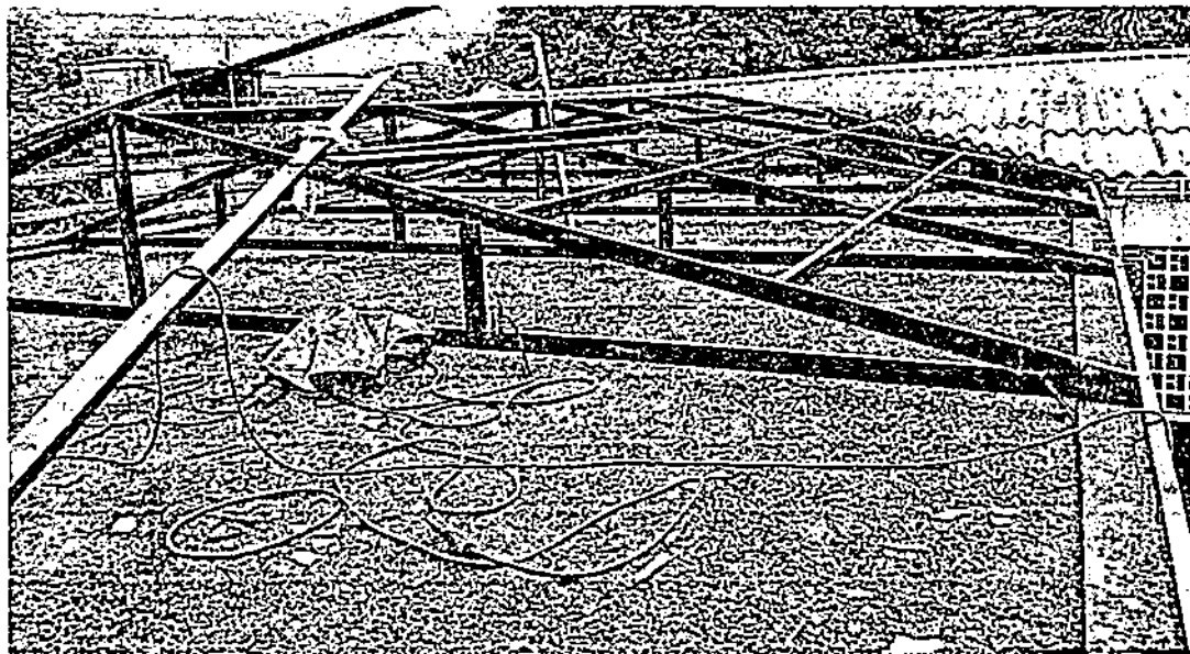
Foto 14. Cap 2. Techo – Estructura Metalica – Instalación de Estructura Metalica
