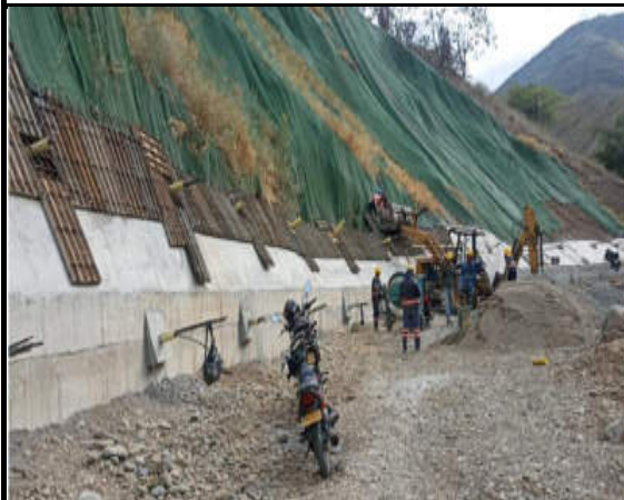
FECHA 31 / jul / 2025 N° 03 Vaciado de concreto vastagos PR55+050
