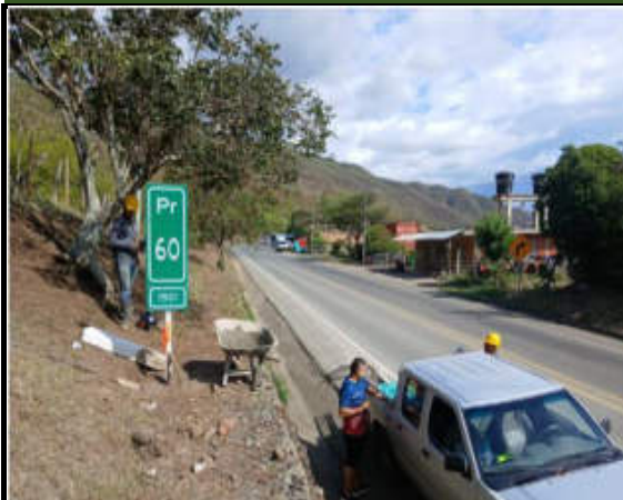
FECHA 31 / jul / 2025 N° 01 Instalacion señalizacion
