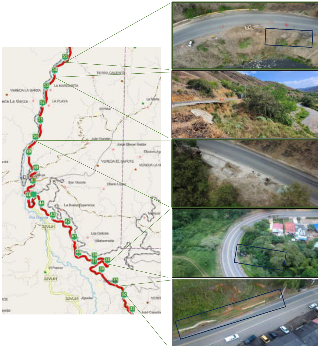
Imagen 3 Ruta 1901 sitios críticos a intervenir PRR33+900, PR37+920, PR50+600, PR53+950 Y PR55+050
