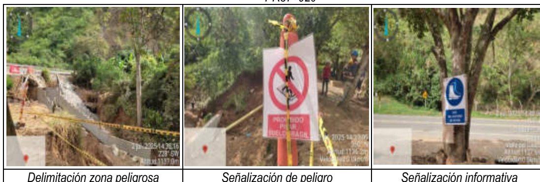
Imagen 4 Evidencia fotográfica de señalización frente de trabajo PR37+920
