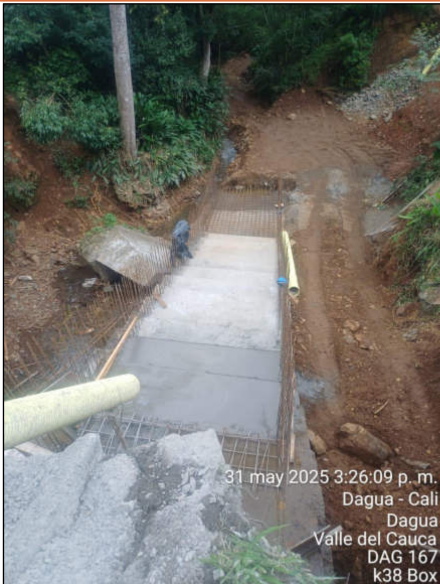
Frente de obra PR 37+920: Construcción de descole de aguas del boxculvert existente
