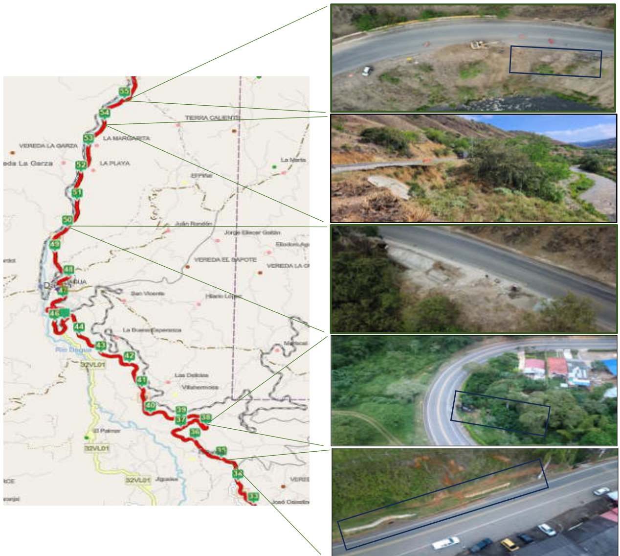
Imagen 4 Ruta 1901 sitios críticos a intervenir PRR33+900, PR37+920, PR50+600, PR53+950 Y PR55+050
