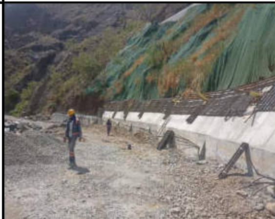
FECHA 31 / jul / 2025 N° 04 Vaciado de concreto vastagos PR55+050
