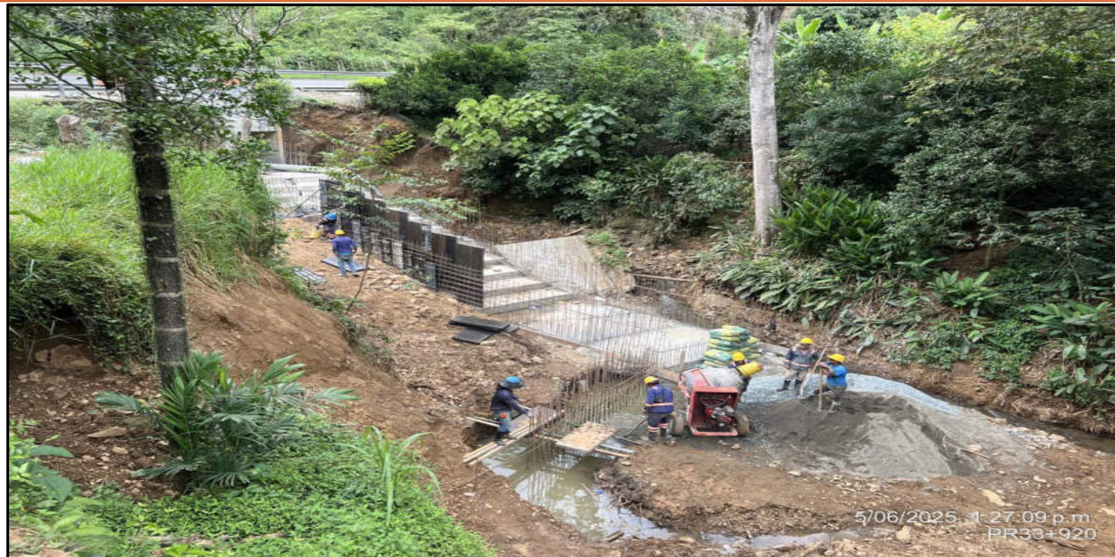
Frente de obra PR 37+920: Construcción de descole de aguas del boxculvert existente
