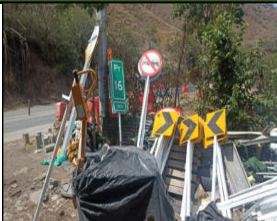
FECHA 31 / jul / 2025 N° 02 Instalacion señalizacion
