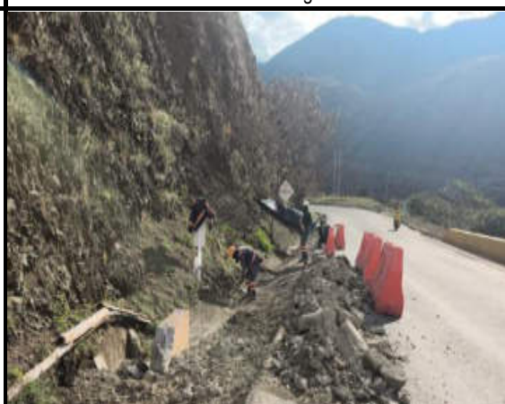
FECHA 31 / jul / 2025 N° 06 Construcción de cunetas PR55+050
