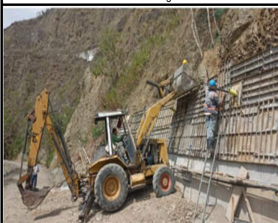
FECHA 31 / jul / 2025 N° 05 Vaciado de concreto vastago PR55+050
