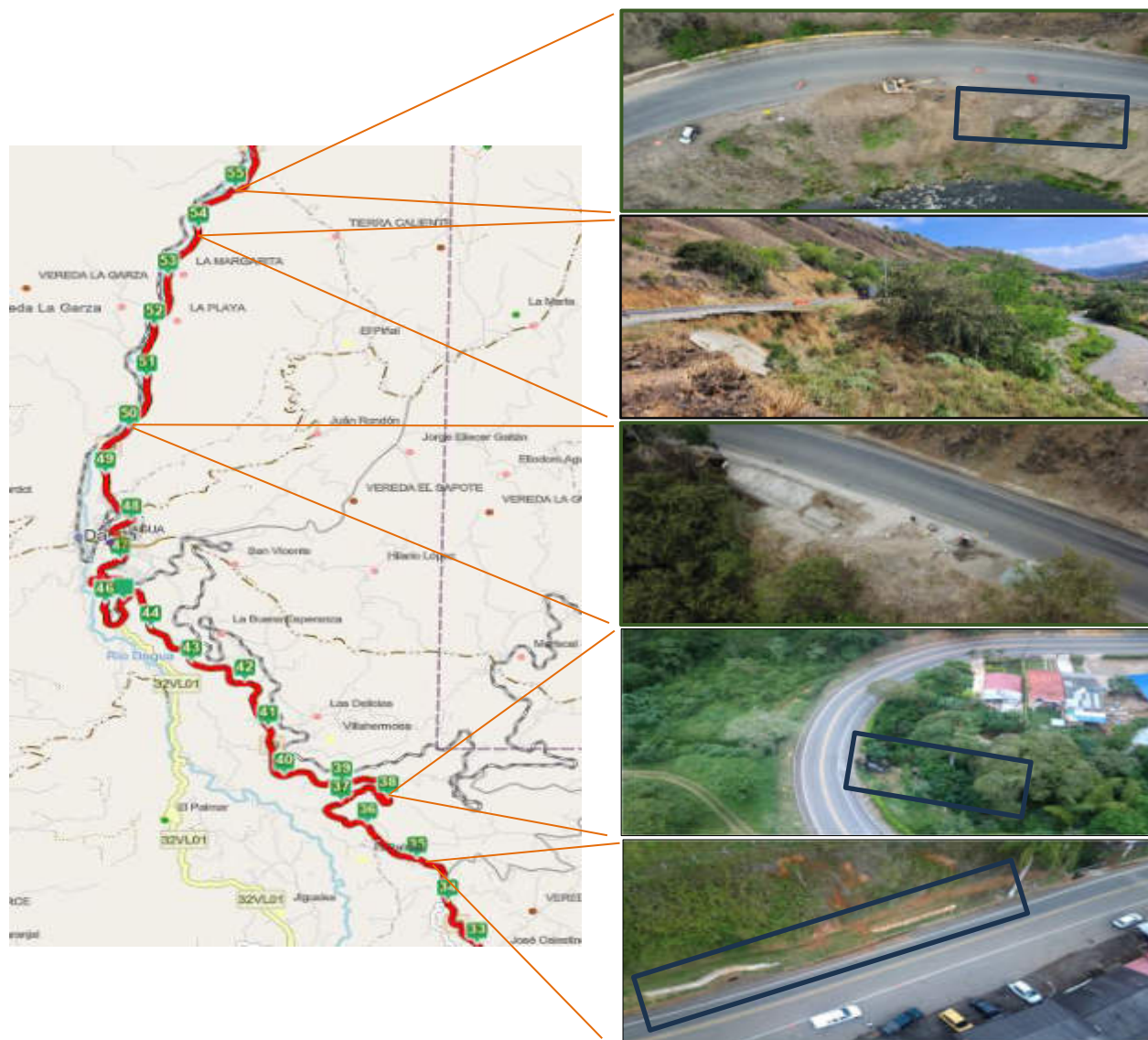
Imagen 3 Ruta 1901 sitios críticos a intervenir PR50+600, PR53+950 Y PR55+050
