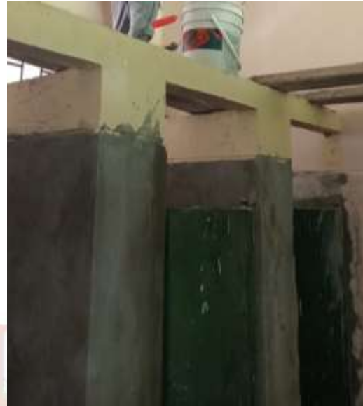
Resane de muros con mortero de pañete
