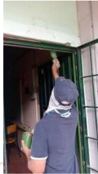
Pintura área intervenida
