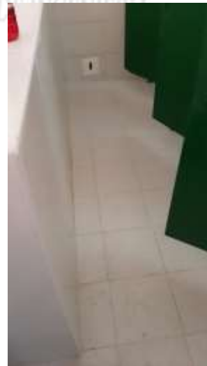
Instalacion de cerámica piso
