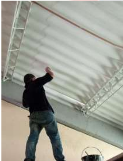
Pintura tejas bajo cubierta
