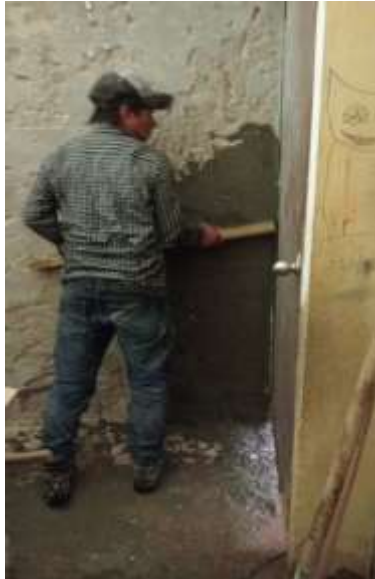
Resane de muros con mortero de pañete
