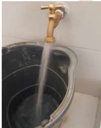
Instalación de llaves terminales
