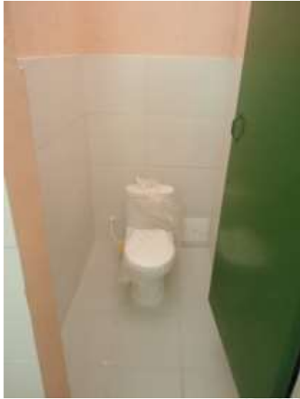
Instalacion de sanitarios linea infantil
