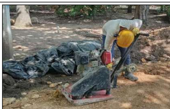
Inspecciones de obra
