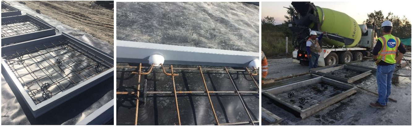
Figura 29 Armado de acero de paneles
