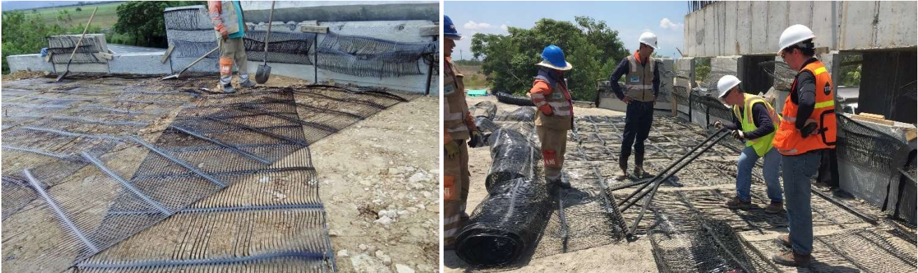
Figura 38 Colocación de geomalla y sistema de tensionamiento
