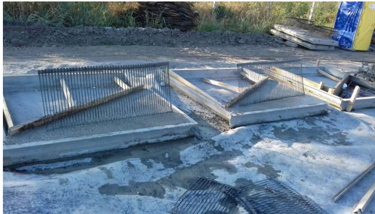
Figura 32 Construcción de paneles especiales
