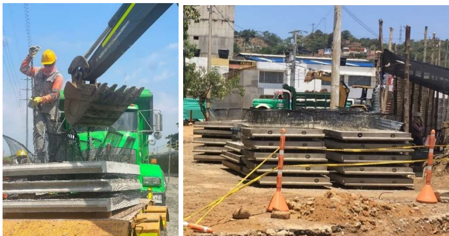
Figura 7 Paneles de concreto apilados para instalación.
