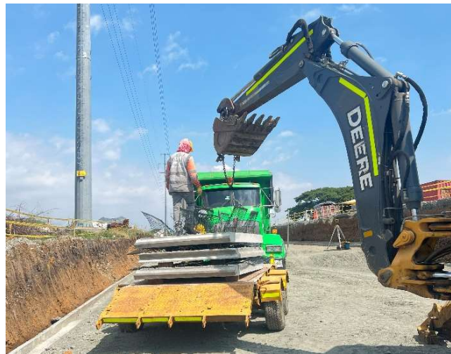
Figura 33 Izaje de paneles
