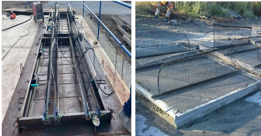
Figura 30 Fijado de Tabs y vertimiento de concreto
