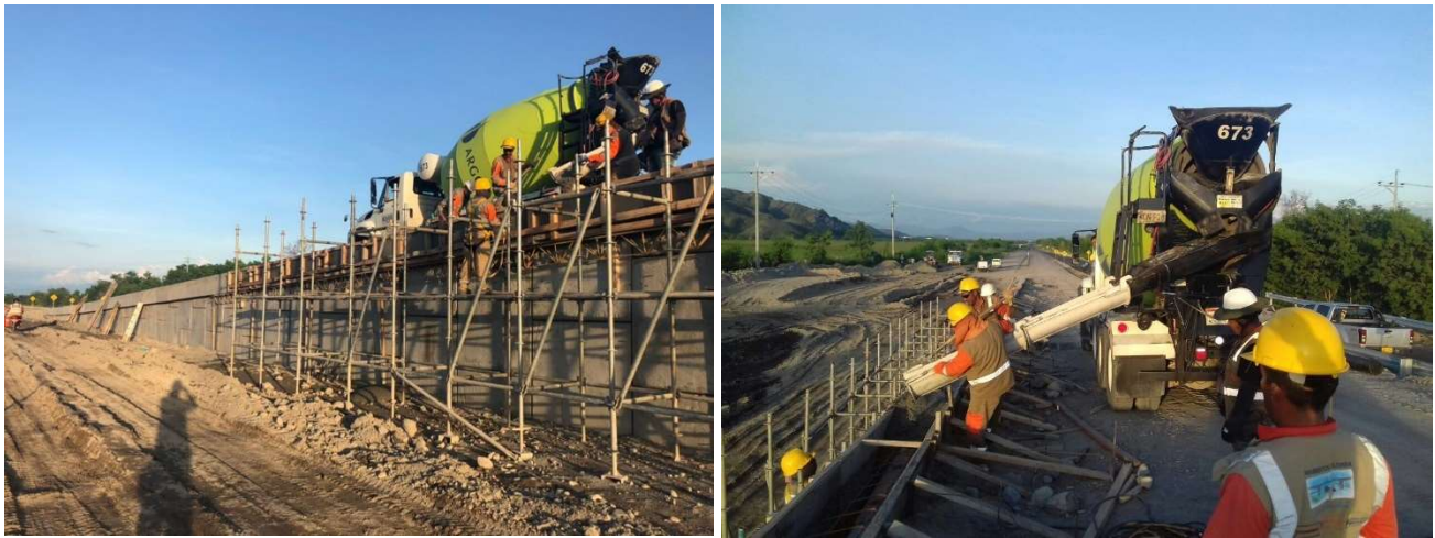
Figura 40 Viga de coronación muro
