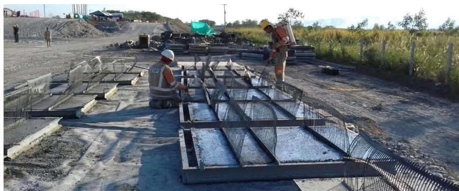
Figura 31 Curado de los paneles de concreto
