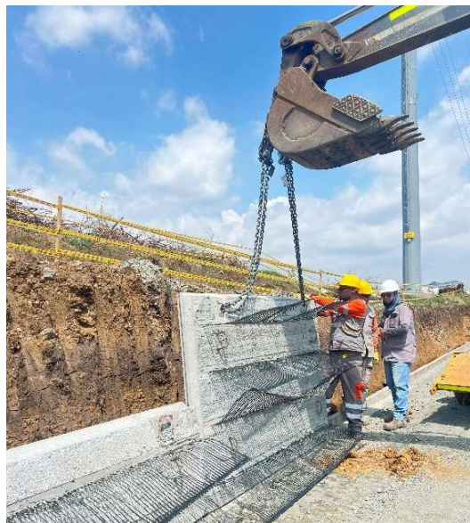
Figura 35 Izaje de paneles con retroexcavadora
