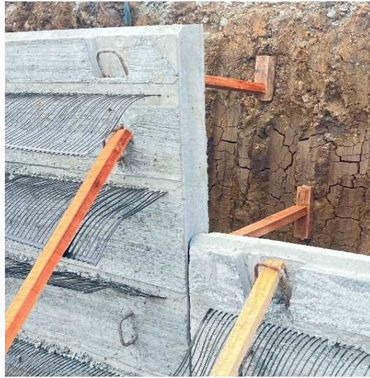
Figura 36 Parales en madera para garantizar verticalidad de los paneles
