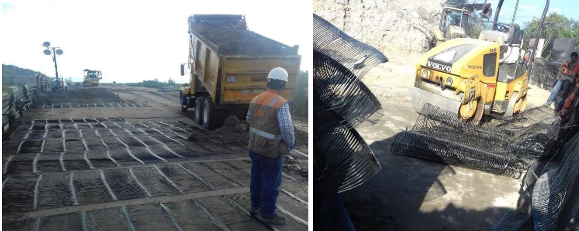
Figura 39 Extensión y compactación del relleno
