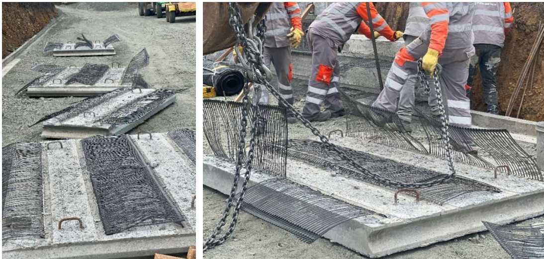
Figura 8 Paneles de concreto con geomallas embebidas.
