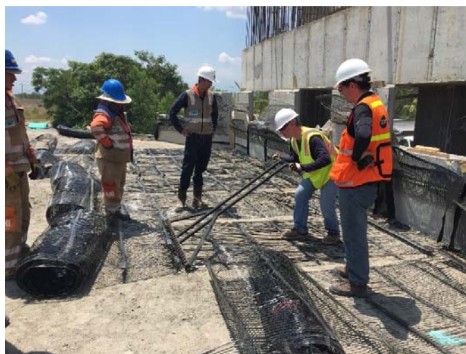
Figura 20. Uso de “cepillo” para tensionamiento de la geomalla.
