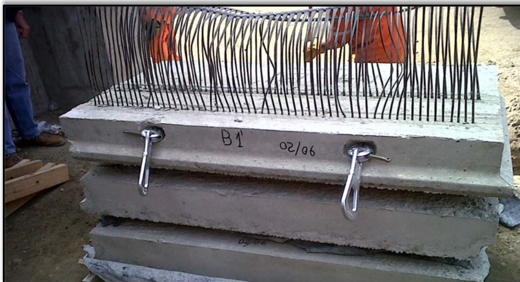
Figura 8. Paneles marcados con Tipo y fecha de fabricación
