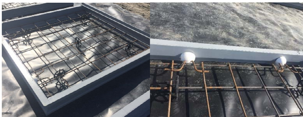
Figura 2. Colocación de aceros y ganchos de izaje.
