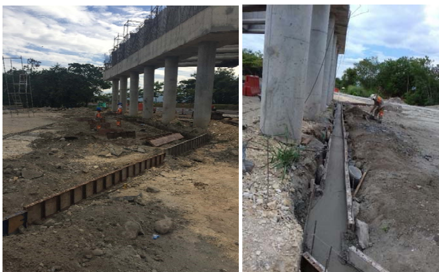
Figura 1. Losa de Nivelación.
