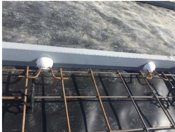
Figura 9. Gancho con varilla en forma de Omega
