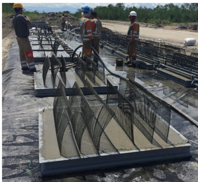
Figura 4. Vibrado.
