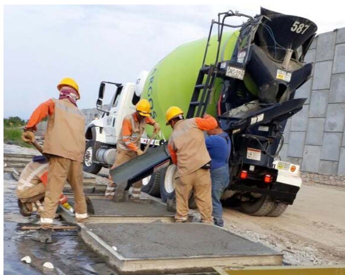
Figura 3. Vaciado Concreto.
