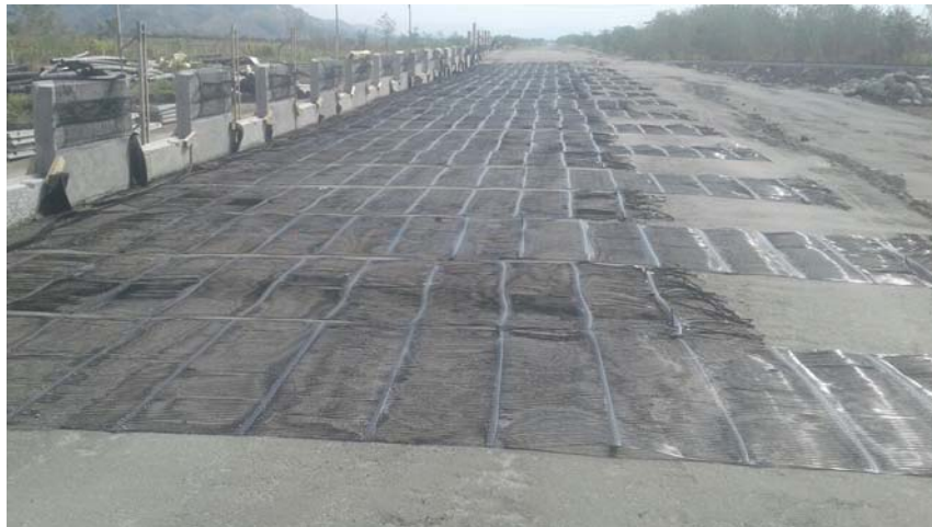
Figura 158. Instalación de geomalla uniaxial TDM HDPE
