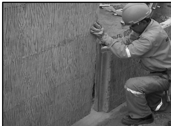
Figura 125. Verificación de alineamiento.
