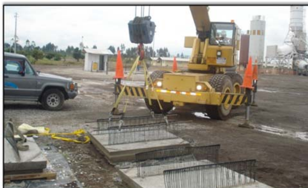
Figura 6. Izaje para acopio.
