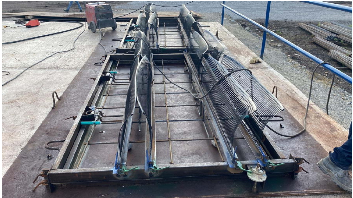
Figura 7. Gancho con varilla en forma de Omega
