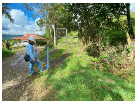
K01+117 oh alcantarilla #1
