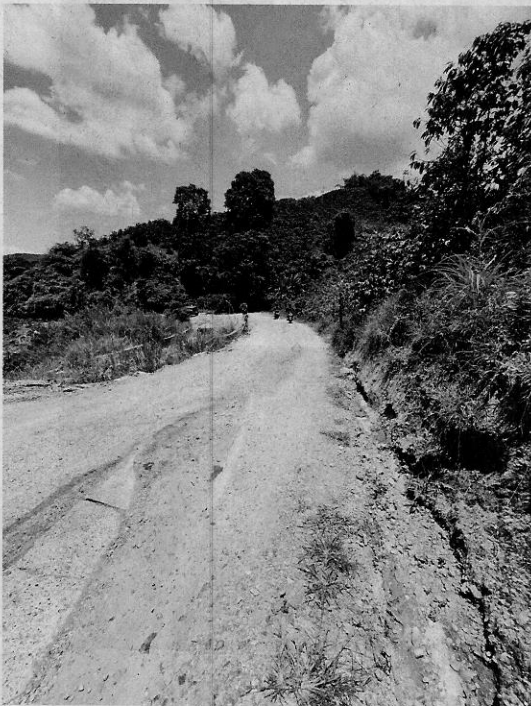
Vista general del sitio crítico.
