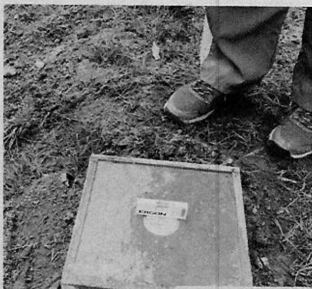
Imágenes de construcción de mojónes
