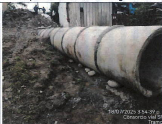
Tramo 3 PR 18+735 instalación de tubería en descole
