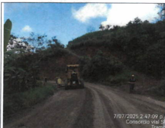
Tramo 2 PR 7+800 reconfiguración y cérico de subbase granular
