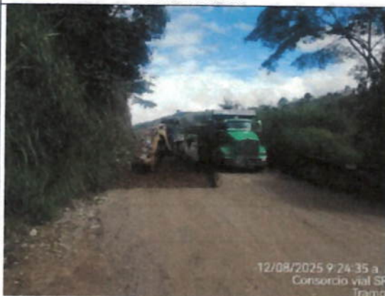
Tramo 2 PR 6+900 cajeo costado Derecho
