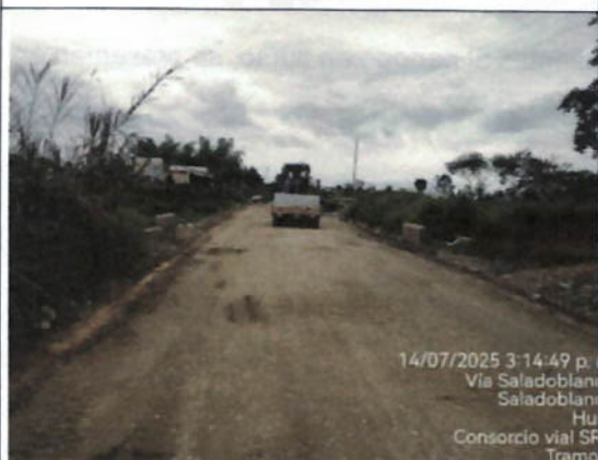
Tramo 3 PR 16+470 conformación y compactación de la subbase granular
