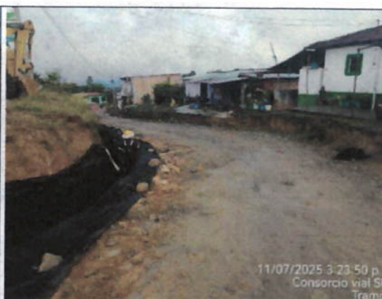
Tramo 2 PR 14+840 costado derecho construcción de filtro
