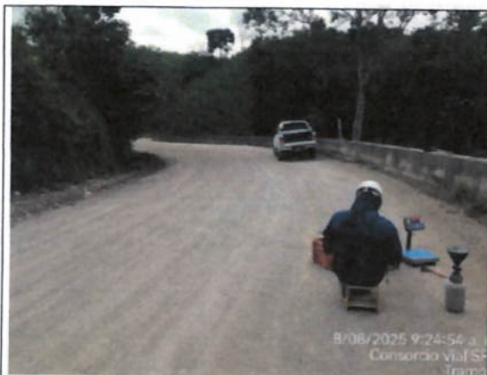
Tramo 2 PR 6+540 liberación de subrasante por densidades
