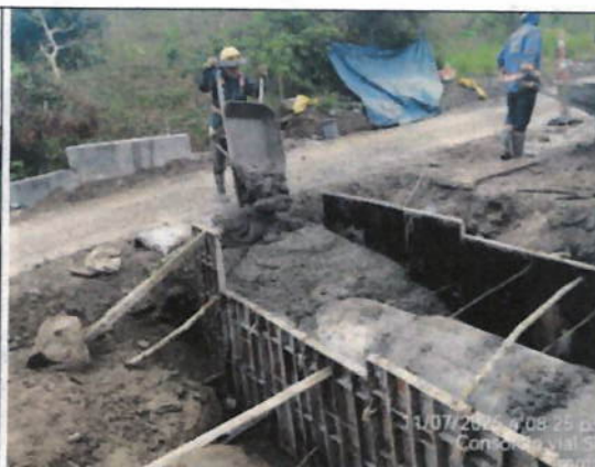
Tramo 3 PR 19+520 atraque de tubería costado izq.
