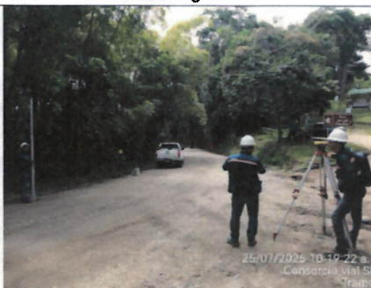
Tramo 2 liberación de SBG por topografía PR 5+800
