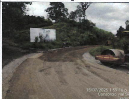
Tramo 2 PR 5+100 reconfiguración de la base granular
