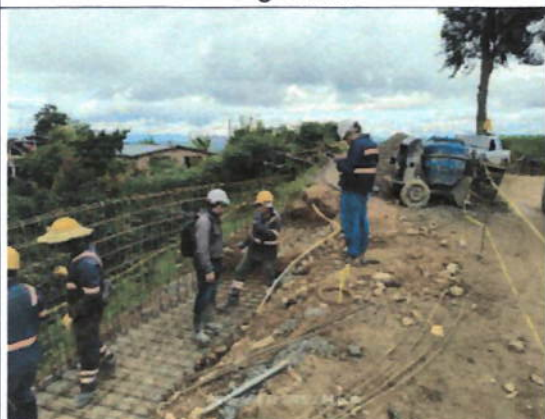
Tramo 2 PR 13+365 costado derecho nivelación y vaciado de solado
