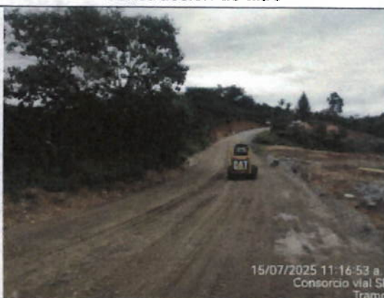
Tramo 2 PR 12+780 conformación de subbase granular
