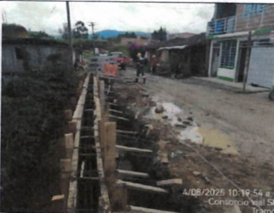
Tramo 2 PR 13+897 instalación de formaleta en vástago
