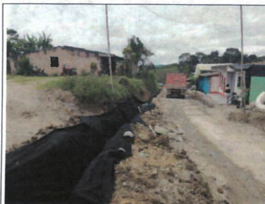
Tramo 3 PR 19+100 costado izquierdo construcción de filtro
