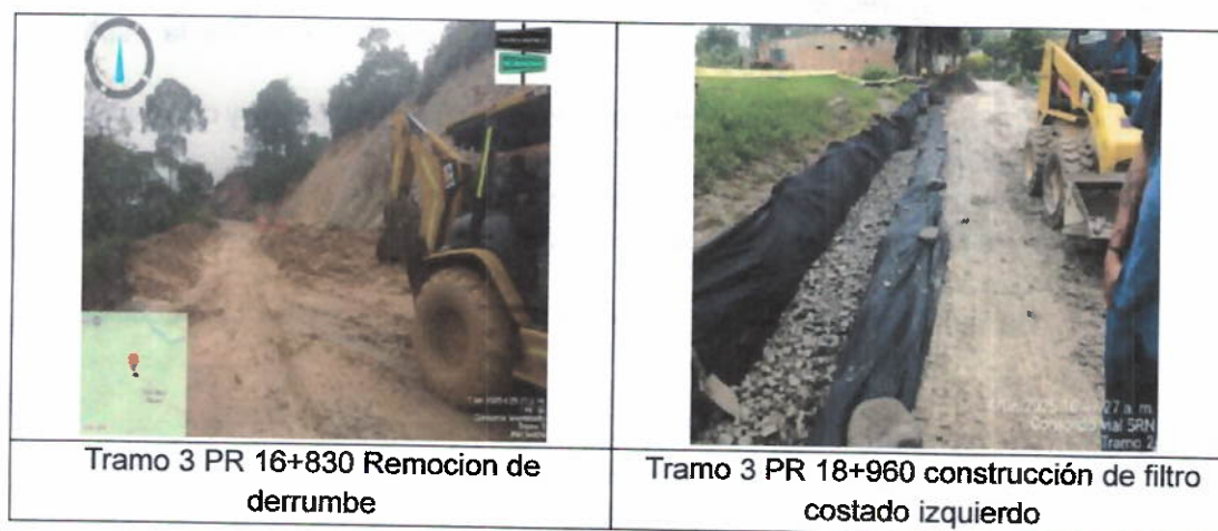
Figura 14 Registro fotográfico Tramo No. 3
