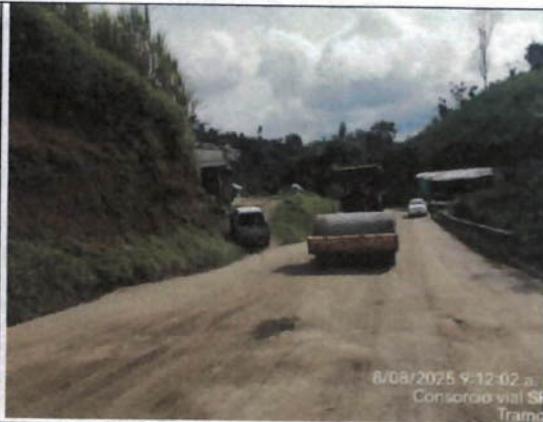
Tramo 2 PR 6+700 compactación de subrasante
