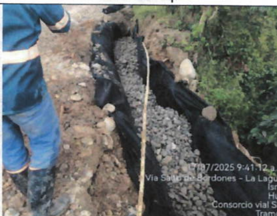
Tramo 3 PR 16+780 costado izq. construcción de filtro
