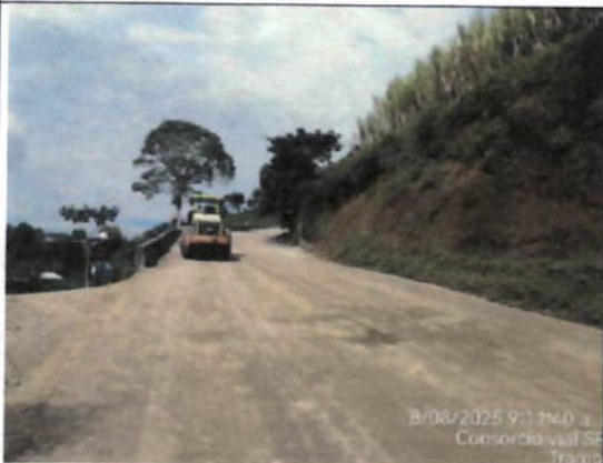
Tramo 2 PR 6+700 compactación de subrasante
