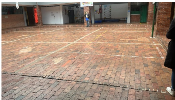
Ilustración 13 Registro fotográfico – Espacio intervención.
