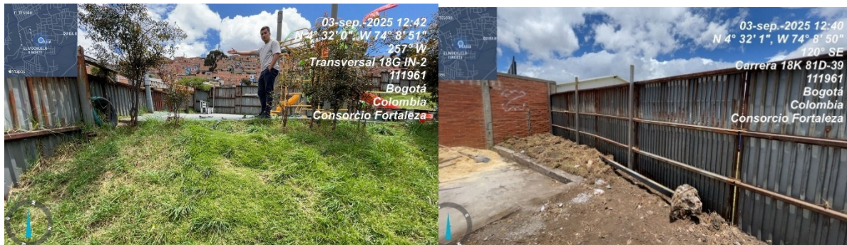
Ilustración 2 Registro fotográfico – cerramiento existente.
