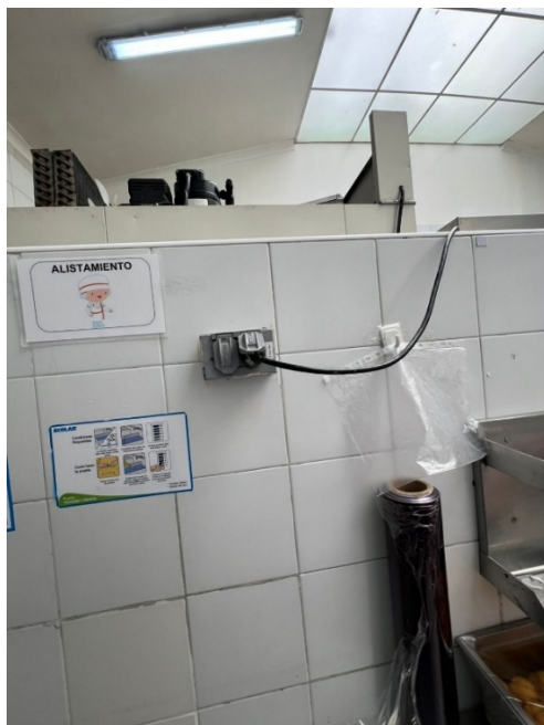
Ilustración 14 Registro fotográfico – Espacio intervención.
