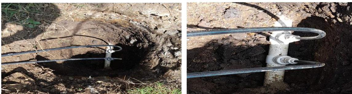
Ilustración 5 Instalación collares de derivación
