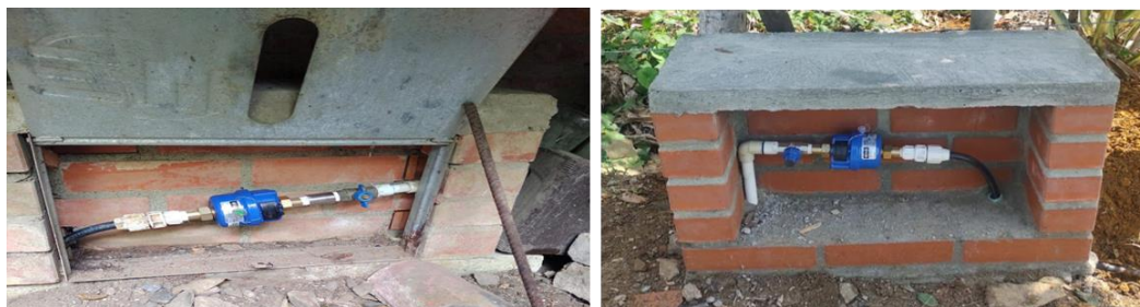
Ilustración 8 Suministro e instalación de medidor
