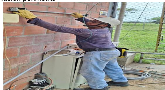
Ilustración 24 Sistema tomacorrientes
