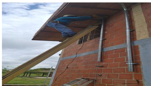
Ilustración 17 Tubo EMT Conduit Galvanizado
