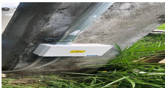
Ilustración 17 Tubo EMT Conduit Galvanizado
