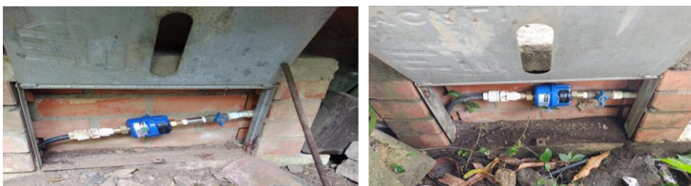
Ilustración 6 Caja para micromedidor.
