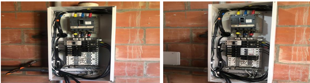
Ilustración 20 Sistema de motobomba
