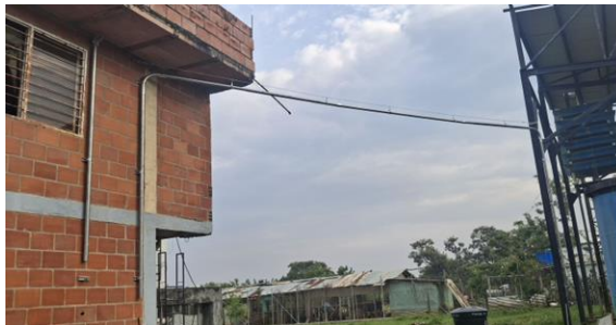
Ilustración 15 Acometidas principal
