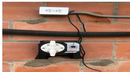
Ilustración 22 Sistema bombas dosificadoras
