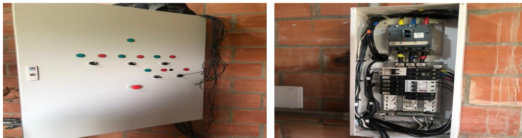
Ilustración 27 Sistema de Conmutación
