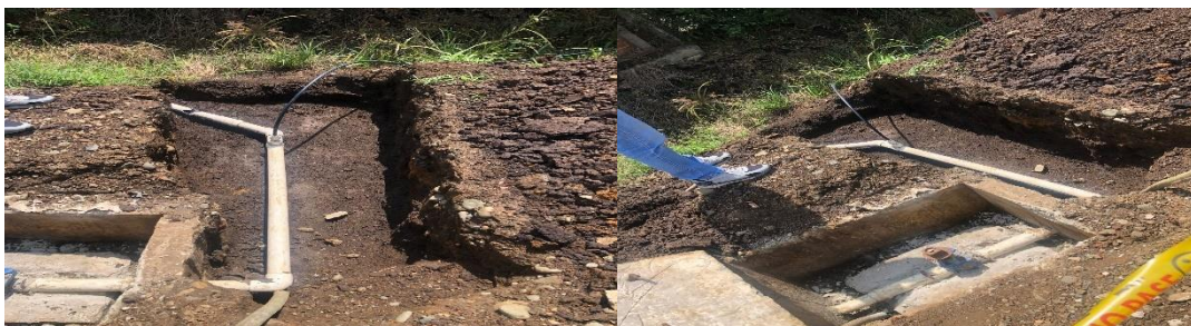
Ilustración 2 Instalación unión mecánica.
