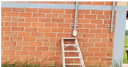
Ilustración 16 Bajante tubo galvanizado
