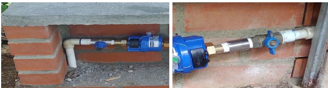
Ilustración 9 Válvula de cierre rápido
