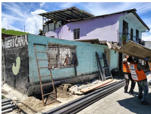
Item. 028.007 Desmonte de cubierta
