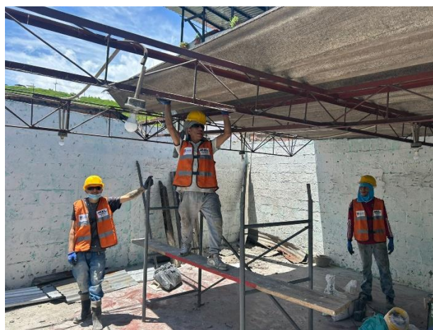
Item. 028.007 Desmonte de cubierta
