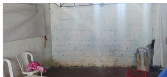
Muros, sin revoque.
