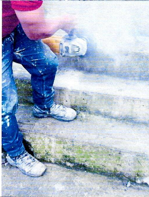
2.2 DEMOLICIÓN DE ELEMENTOS EN CONCRETO
