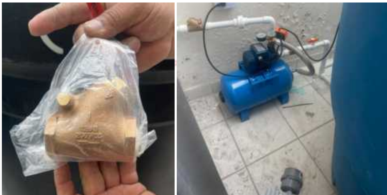
Foto 8. Suministro e instalación válvula cheque cortina bronce 1".
