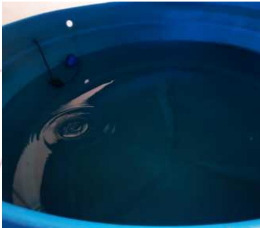
Foto 8. Suministro e instalación de electroniveles o swich flotador, para tanque de abastecimiento.
