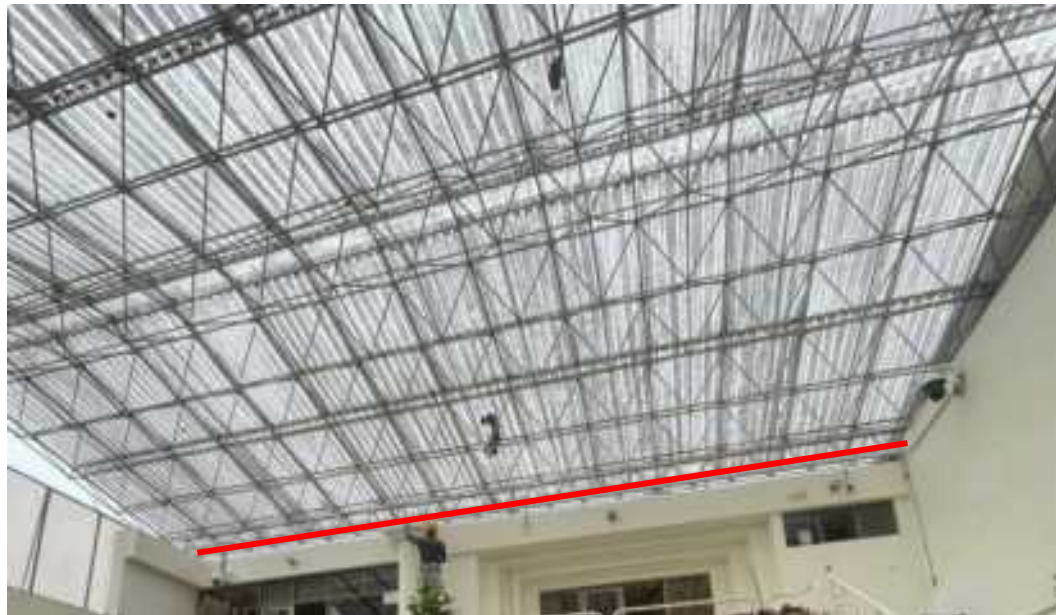
Foto 8. Limpieza e impermeabilización de canales en lámina Galvanizada LD= 0,71m
