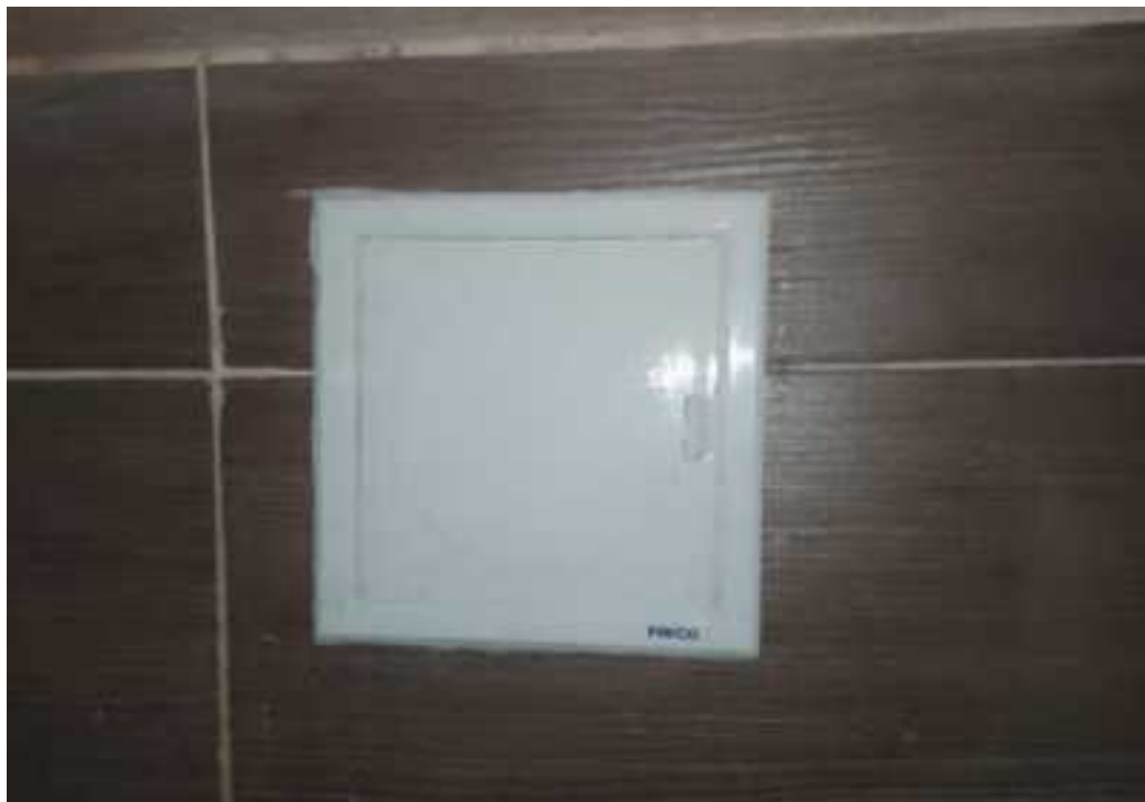
Foto 8. Suministro e instalación de tapa registro
