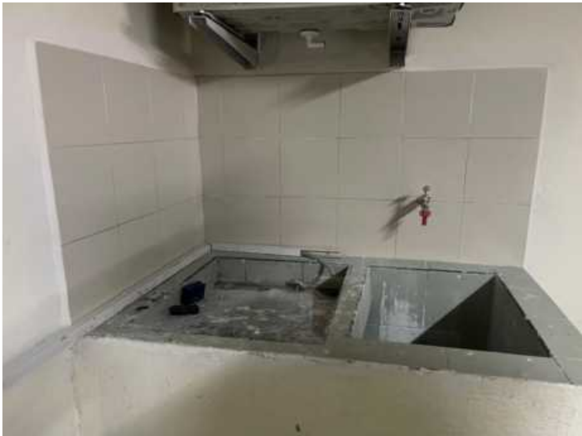
Foto 8. ENCHAPE DE PARED DE BAÑOS DEL SEGUNDO NIVEL Y PRIMER NIVEL
