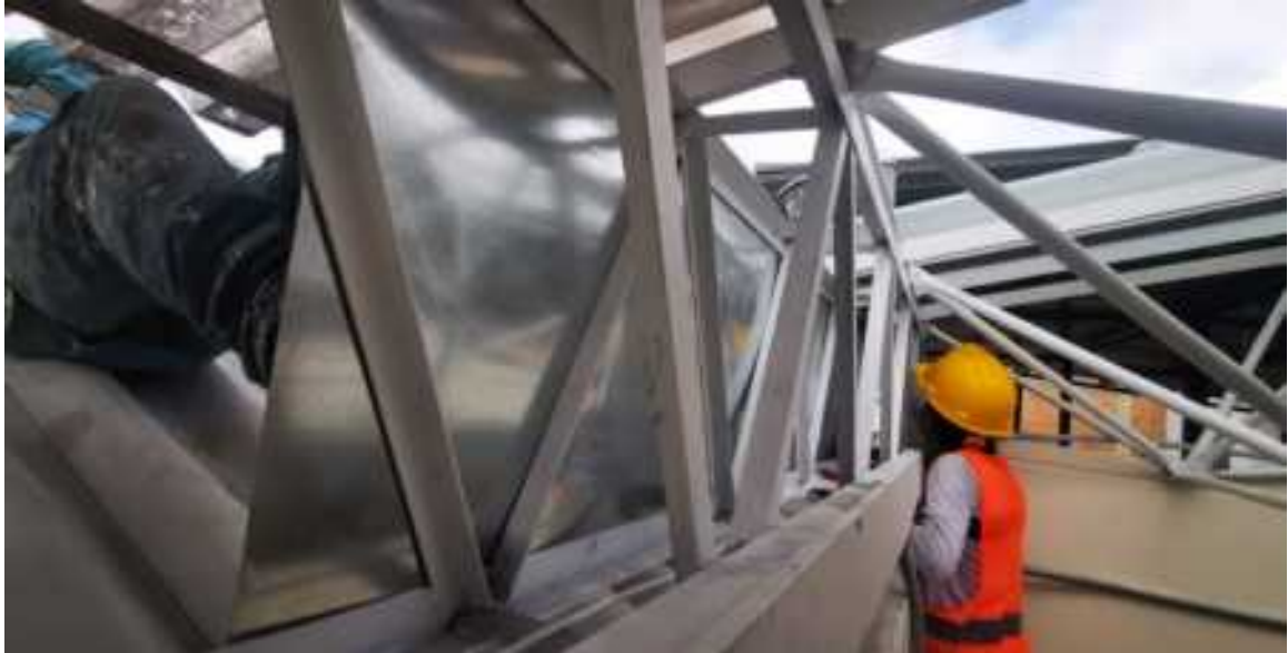
Foto 8. Suministro e instalación de flanche en lámina
