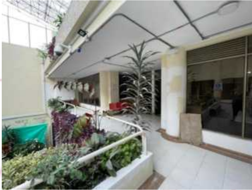
Foto 7. ESTUCO ACRILICO EN MUROS
