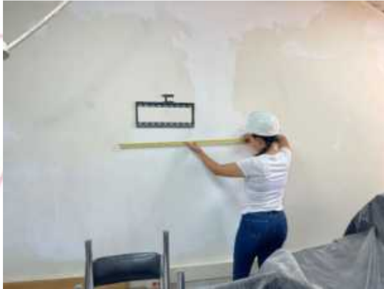
Foto. LOCALIZACION Y REPLANTEO
