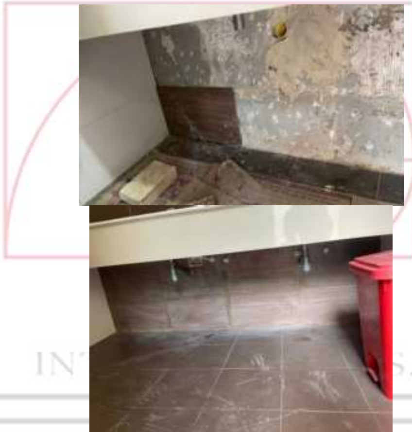
Foto 8. DESMONTE PUNTO SANITARIO EXISTENTE Y SUMINISTRO E INSTALACIÓN PUNTO SANITARIO PARA LAVAMANOS
