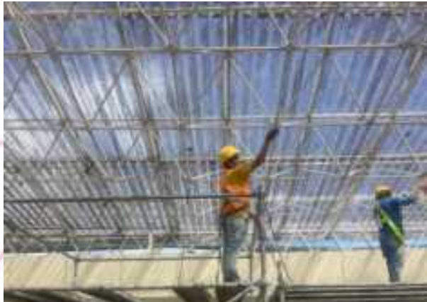
Foto 7. Limpieza y pintura esmalte color con anticorrosivo para estructura metálica de cubierta.
