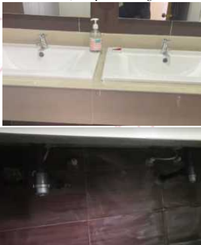
Foto 8. Suministro e instalación de grifería para lavamanos, llave individual Nogal Cromo, incluye sifon desagüe.
