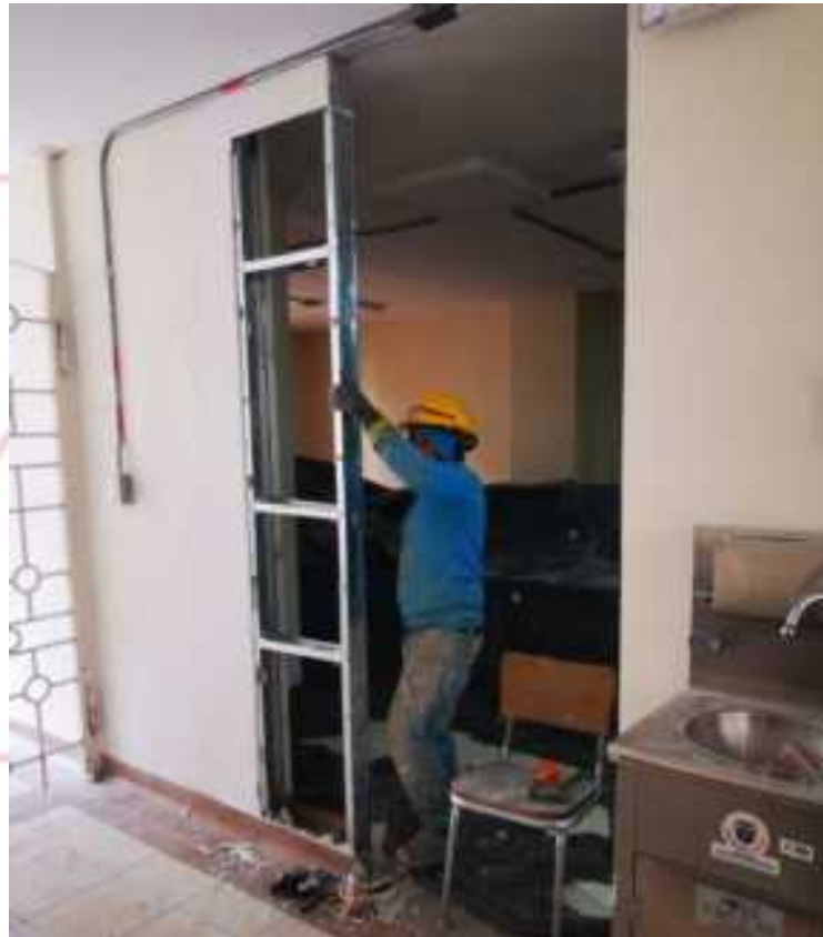
Foto. DESMONTE DE SUPERBOARD 2 CARAS INC ESTRUCTURA Y RETIRO DE ESCOMBROS
