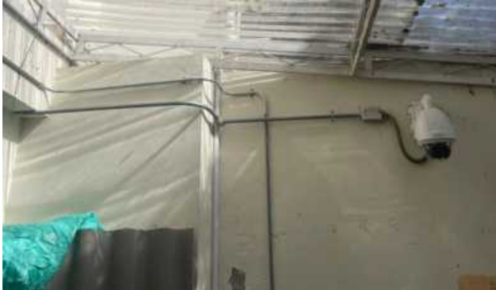
Foto 8. Conexión de tablero de control a fuente principal de energía. Incluye tubería eléctrica EMT 3/4", cable L/HALO Cu #12 y accesorios.
