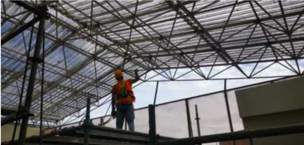
Foto 8. Limpieza de vidrios y marcos ubicados en muros altos
