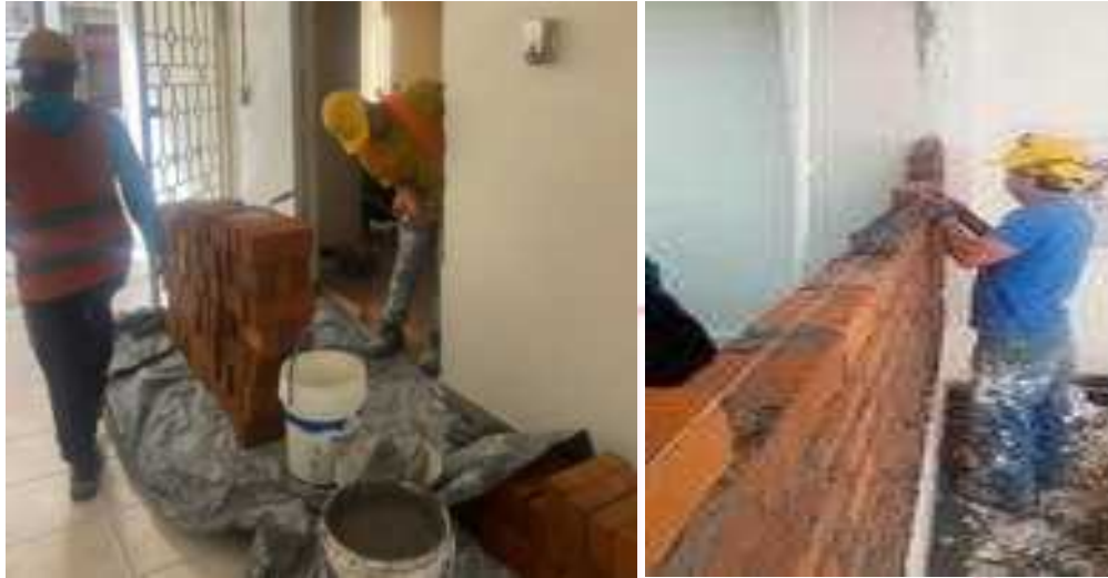
Foto. MURO EN MAMPOSTERIA LADRILLO BLOQUE
