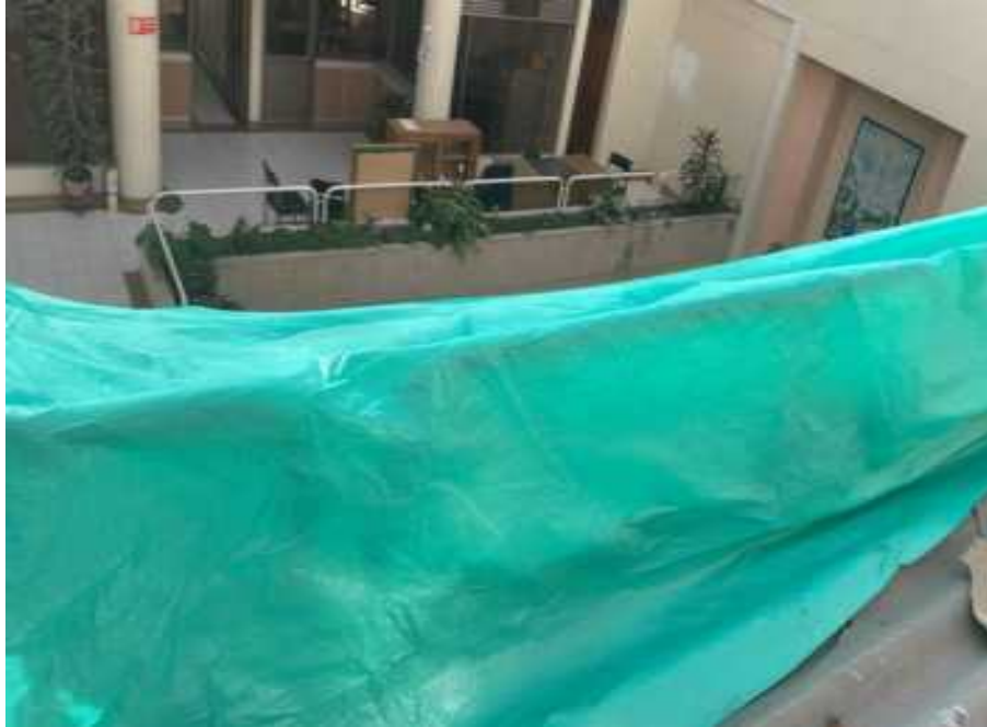
Foto. CERRAMIENTO PROVISIONAL EN MALLA VERDE O TELA
