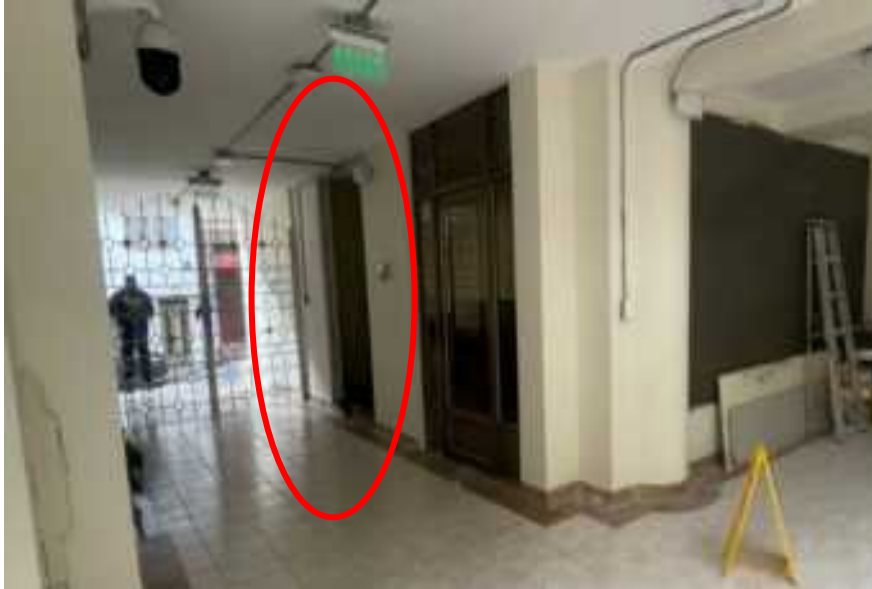
Foto. DESMONTE DE PUERTA DOBLE HOJA EN ALUMINIO DE 0,9X2,60 M INCLUYE MARCO DE PUERTA
