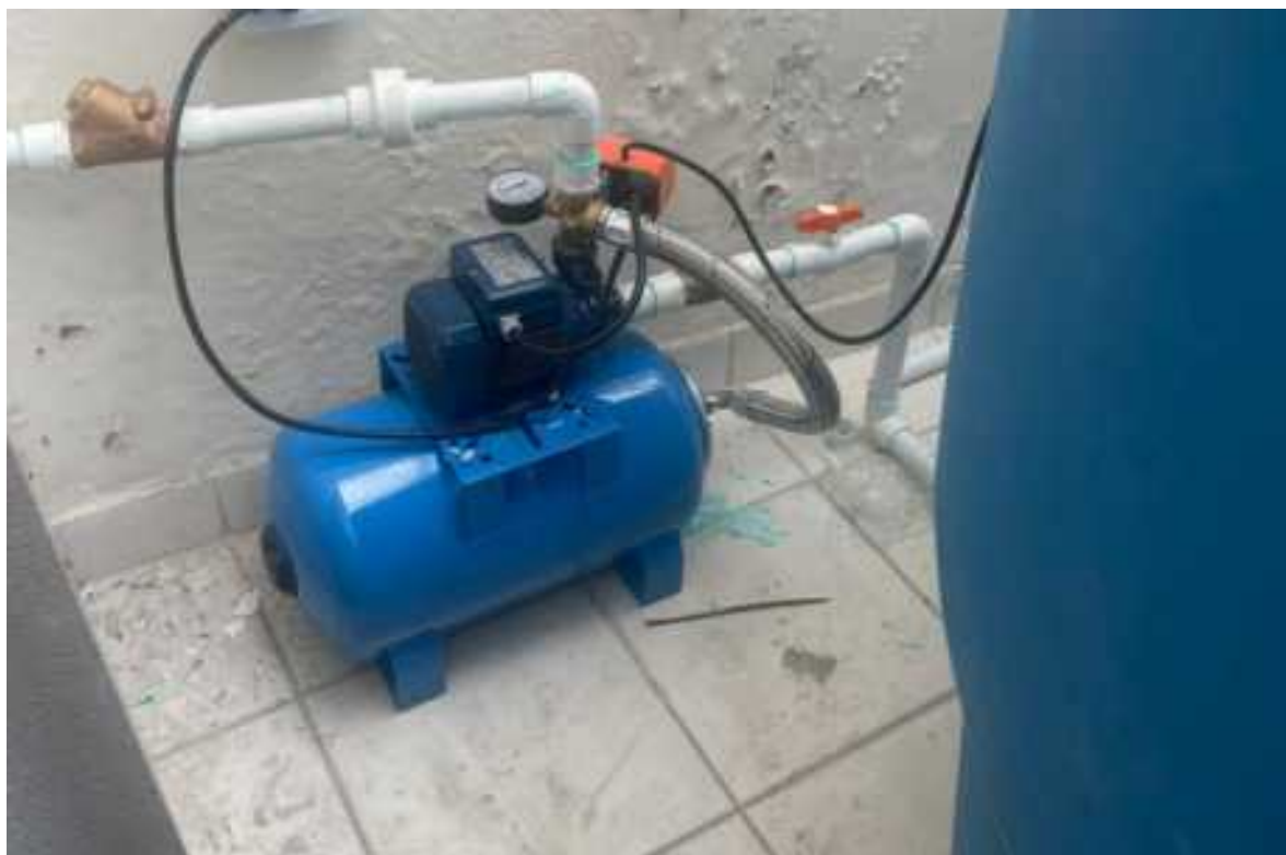
Foto 8. Suministro e instalación de llave de paso de bola 1".
