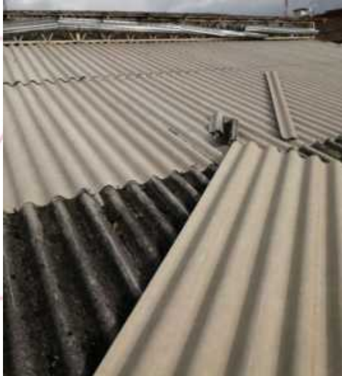
Foto. SUMINISTRO INSTALACIÓN Y MONTAJE DE TEJA DE FIBROCEMENTO
