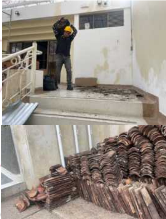
Foto. DESMONTE Y DISPOSICIÓN DE TEJA DE BARRO EXISTENTE
