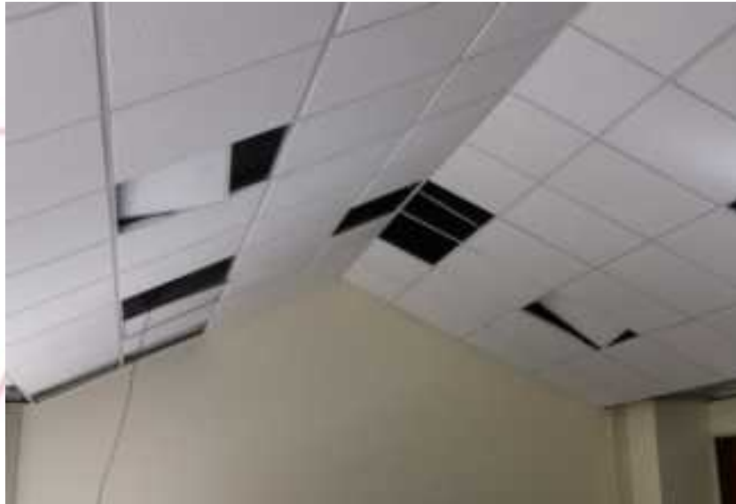
Foto 8. Suministro e instalación de cielo raso desmontable, láminas de fibra mineral 0,60m x 0,60m, incluye estructura
