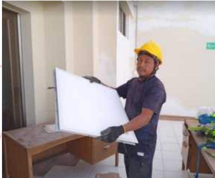
Foto 5. Retiro y reinstalación de luminarias de techo. (Incluye aislamiento)
