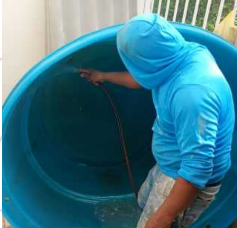
Foto 8. Lavado y desinfección de tanques PVC 1000 litros
