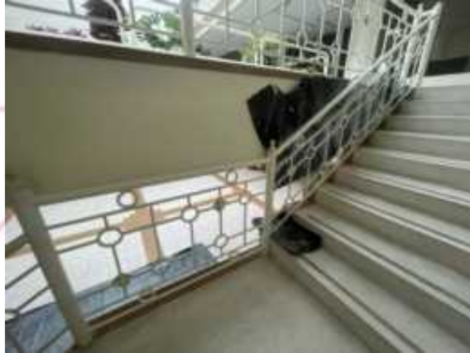
Foto. Pintura esmalte color con anticorrosivo para pasamanos y rejas
