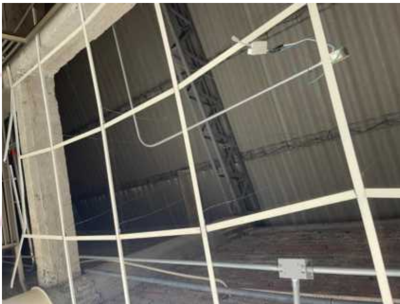
Foto 4. DESMONTE DE CIELO FALSO LÁMINA DE FIBRA MINERAL, INCLUYE ESTRUCTURA DEL SEGUNDO NIVEL
