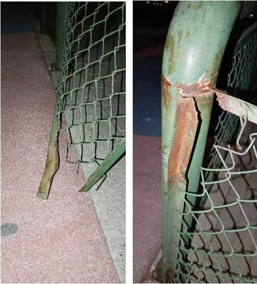
Fotos # 2, 3, 4, 5 y 6 Puertas en mal estado de las zonas infantiles y la puerta de la cancha número 1 para colocar
