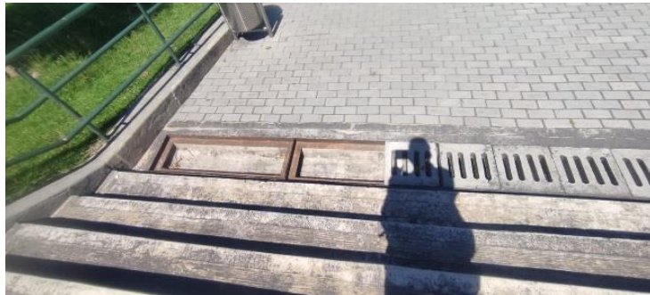
Foto # 1 mantenimiento de rejillas escaleras
