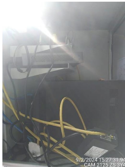
Estado gabinete inicial
