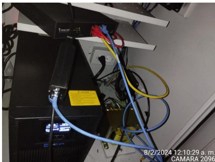
Estado Gabinete Inicial
