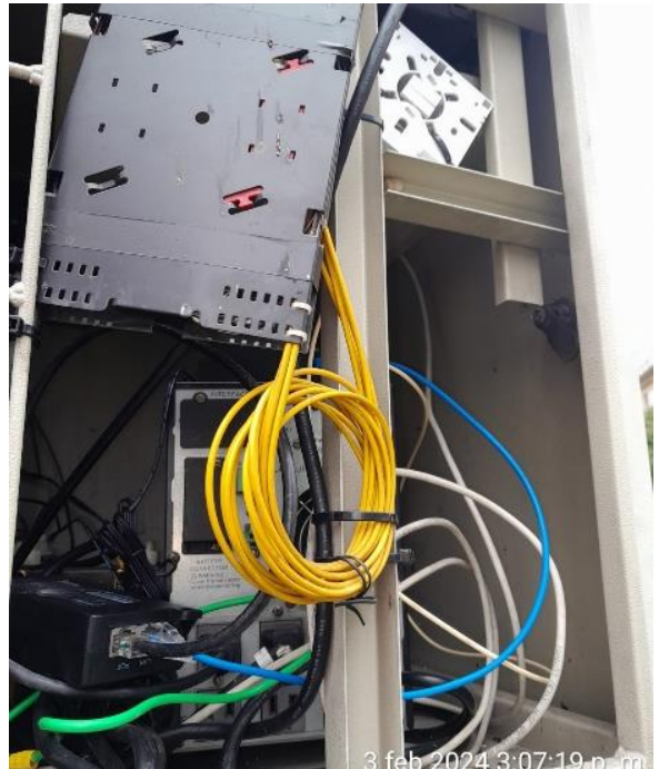
Estado Gabinete Inicial
