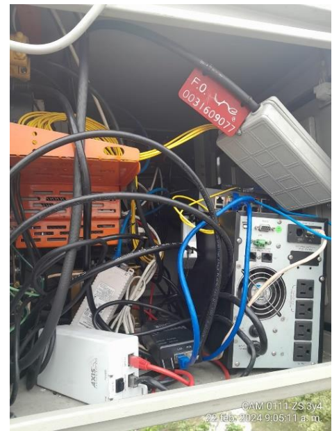
Estado Gabinete Inicial
