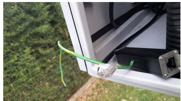
Protector ethernet estaba suelto
