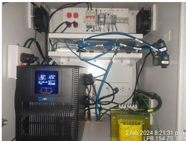
Estado Gabinete Inicial
