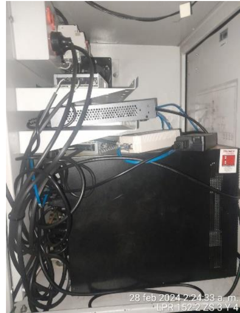
Estado Gabinete Inicial
