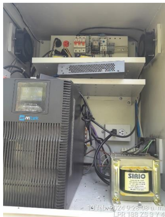
Estado gabinete inicial
