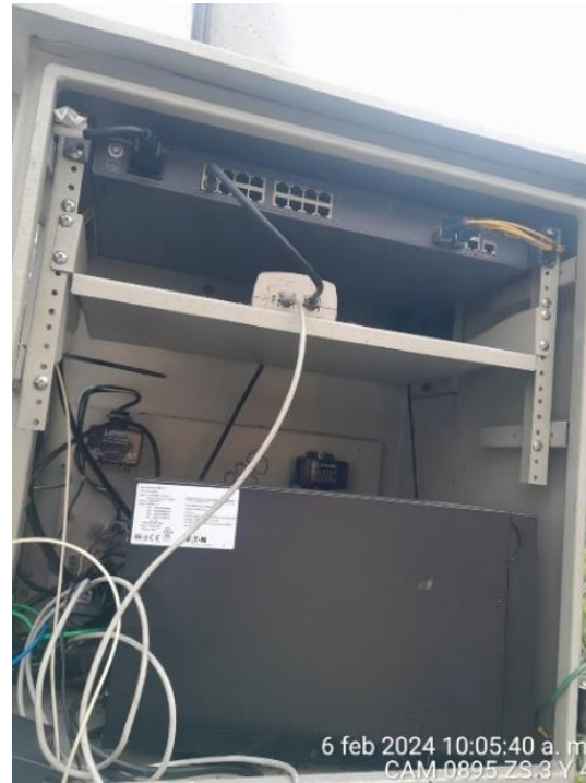
Estado Gabinete Inicial
