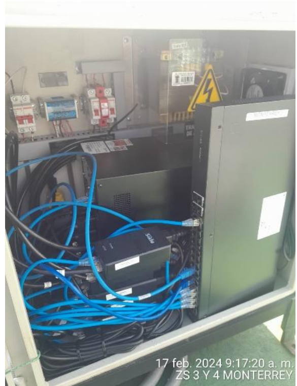
Estado Gabinete Inicial
