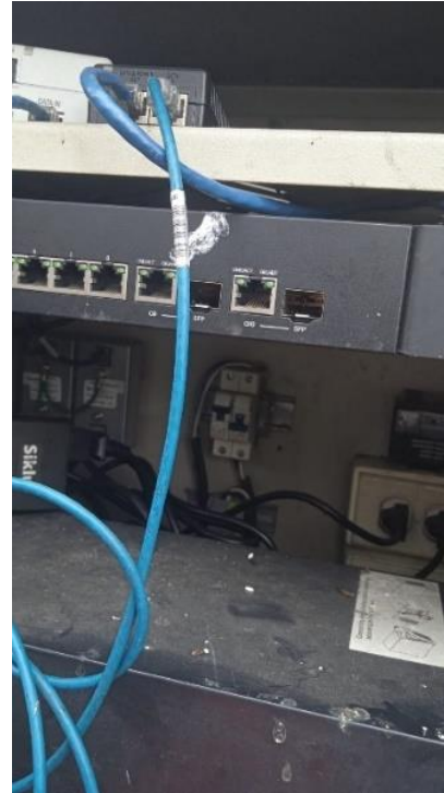
Estado Gabinete Inicial
