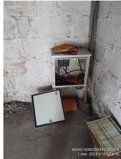
Estado Gabinete Inicial
