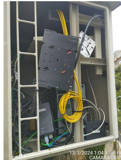
Estado Gabinete Inicial
