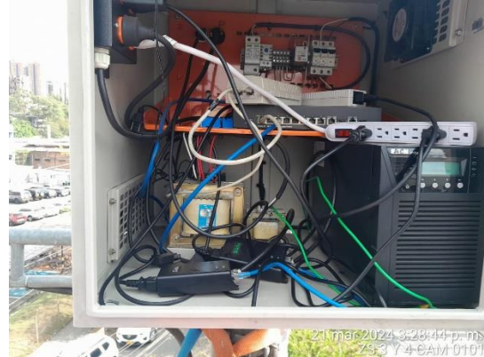
Estado Gabinete Inicial
