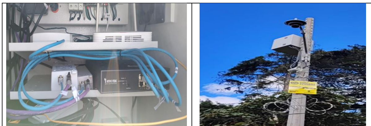
Imagen 4. ID 2171 INSTALACIÓN DE BRAZO, ALTAVOZ, SWITCH, MÓDULO DE ALARMAS, CARTEL, CONCERTINA, CÁMARA.
