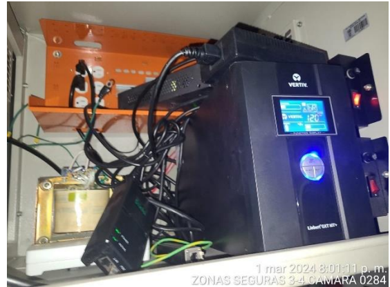
Estado Gabinete Inicial
