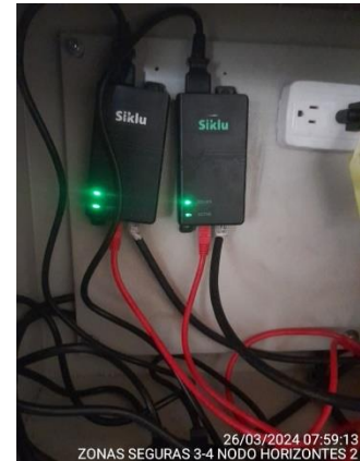
Estado Gabinete Inicial
