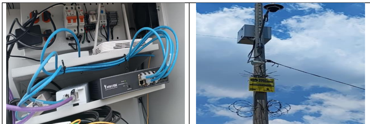
Imagen 1. ID 2168 INSTALACIÓN DE BRAZO, ALTAVOZ, SWITCH, MÓDULO DE ALARMAS, CARTEL, CONCERTINA, CÁMARA.
