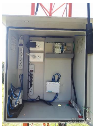
Estado Gabinete Inicial
