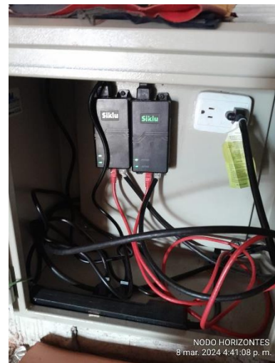
Estado Gabinete Inicial
