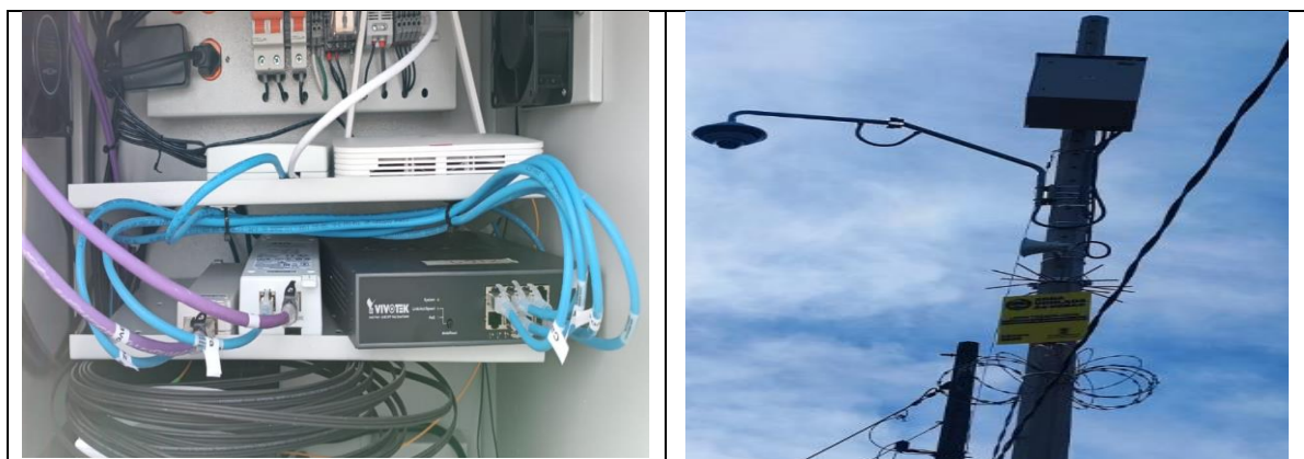
Imagen 2.ID 2169 INSTALACIÓN DE BRAZO, ALTAVOZ, SWITCH, MÓDULO DE ALARMAS, CARTEL, CONCERTINA, CÁMARA.
