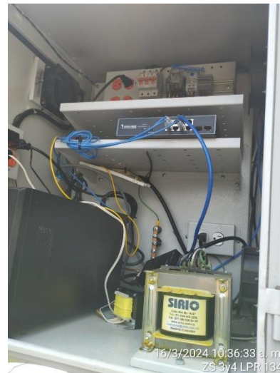
Estado Gabinete Inicial
