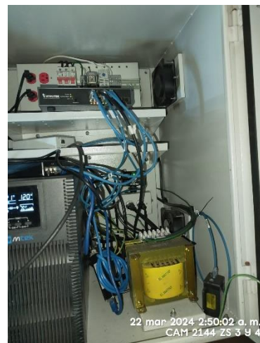
Estado Gabinete Inicial
