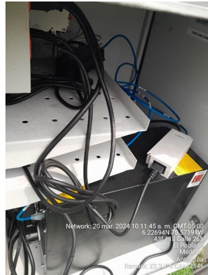
Estado Gabinete Inicial
