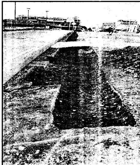
OBRA MEJORAMIENTO DE ANDENES
