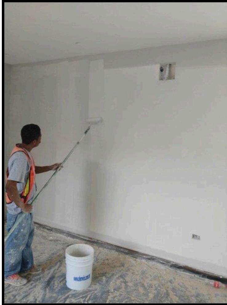
Imagen 11: Pintura Muros con Vinilo Tipo 1.
