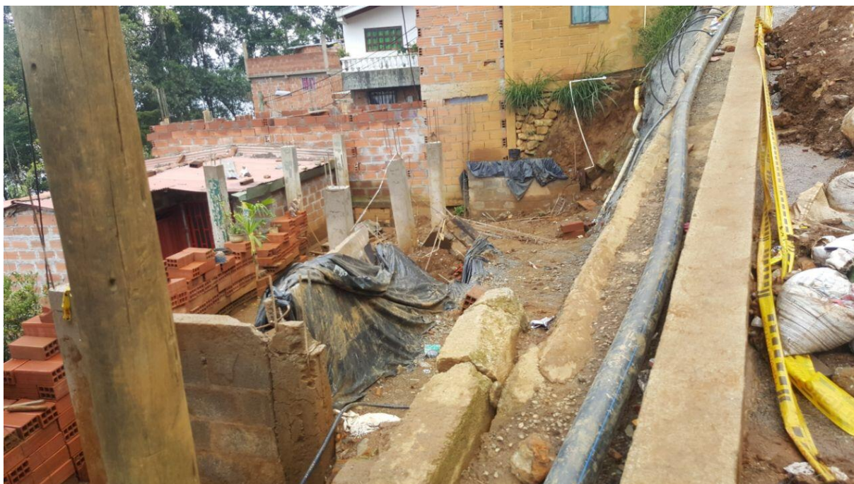
Fotografía 9. Estado actual del sitio en estudio.
