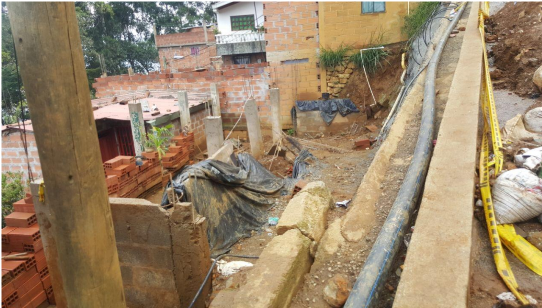
Figura 3. Estado actual del sitio de crítico.
