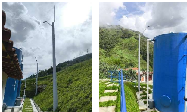
Ilustración 52 Instalación de postes en PRFV.
