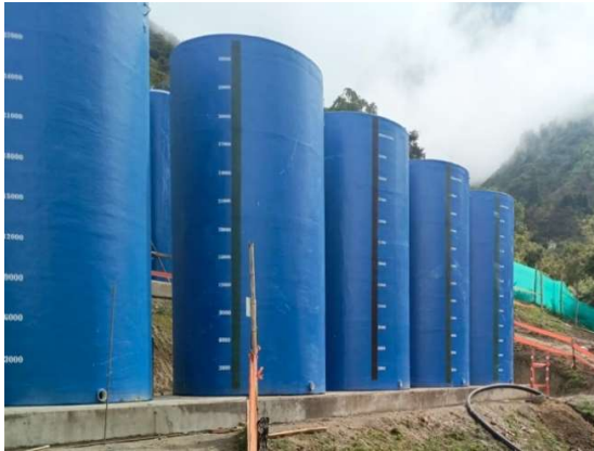
Ilustración 34 Cinco tanques de almacenamiento ubicados sobre la losa.
