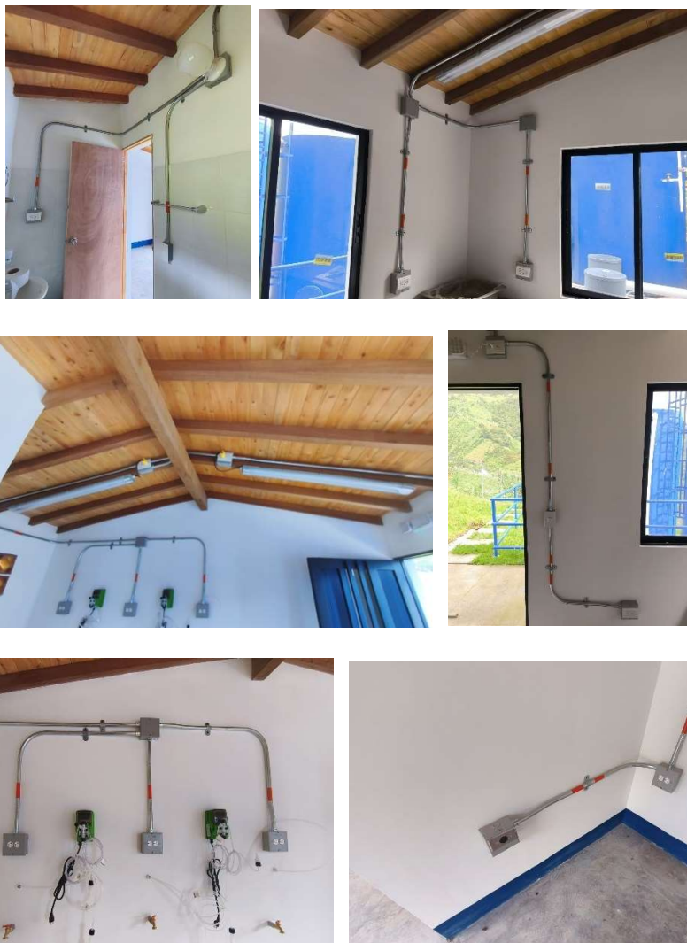
Ilustración 53 Instalación redes eléctricas caseta.
