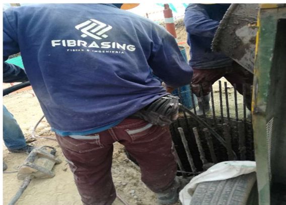
Ilustración 27 Actividad de vaciado y vibrado de las pilas.
