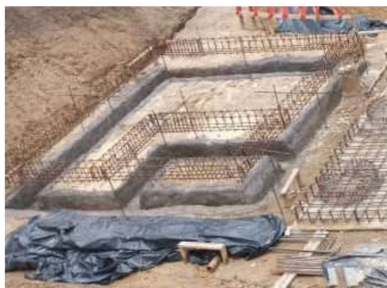
Ilustración 37 Solado de la caseta de operaciones.
