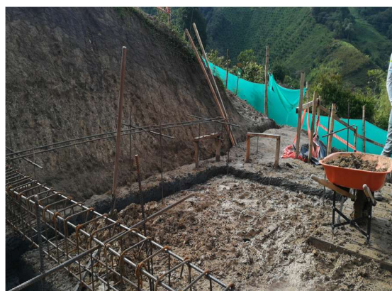
Ilustración 36 Excavación manual materia heterogéneo
