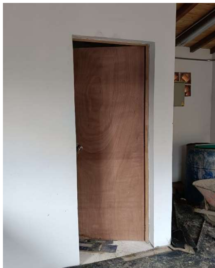
Ilustración 44 Puertas y ventanas instaladas en la caseta de operaciones
