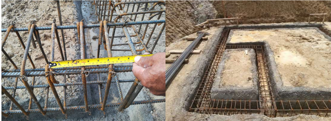
Ilustración 38 Acero figurado e instalado para las fundaciones de la caseta de operaciones
