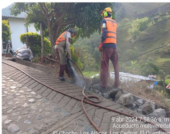
Ilustración 59 Demolición de pavimento rígido.
