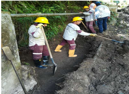
Ilustración 12 Excavación manual materia heterogeneo
