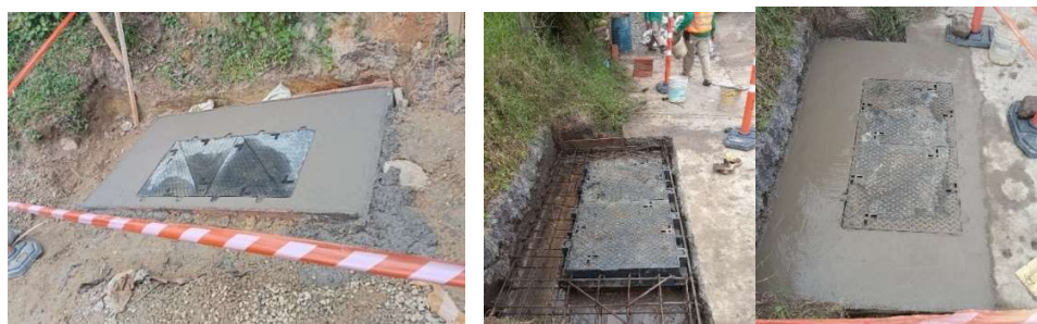
Ilustración 79 Registro de cinta colocada "precaución red de acueducto" en la zanja.
