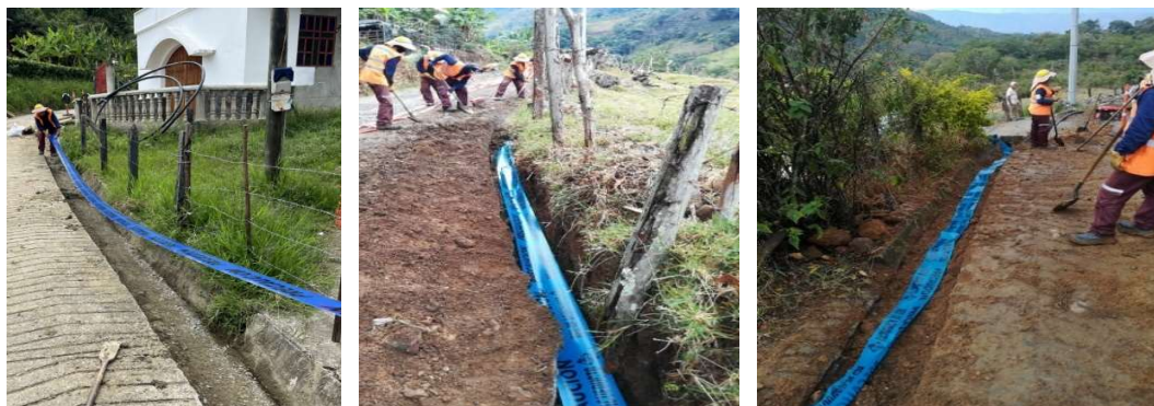
Ilustración 78 Registro de cinta colocada "precaución red de acueducto" en la zanja.
