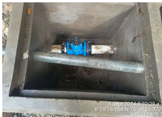
Ilustración 17 Instalación de válvulas compuerta.
