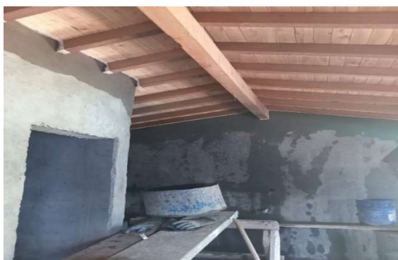
Ilustración 43 Revoque paredes internas de la caseta de operaciones
