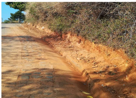
Ilustración 64 Registro de aspecto final del terreno del lleno haciendo uso del material procedente de la excavación.
