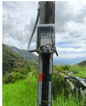
Ilustración 48 Sistema de puesta a tierra.
