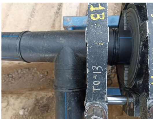
Ilustración 77 Registro de tubería instalada de 3".
