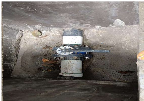
Ilustración 18 Instalación de válvulas cierre rápido.
