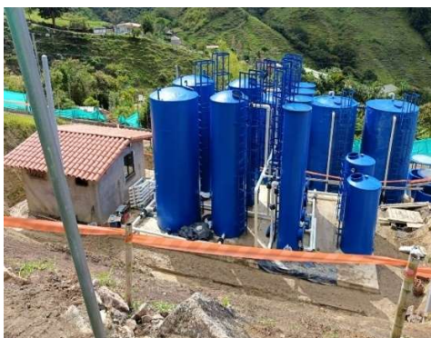
Ilustración 31 Unidades de sedimentación.
