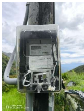
Ilustración 49 Instalación de contador de energía.
