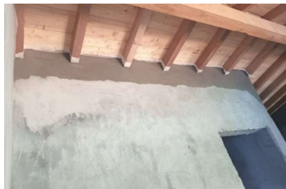
Ilustración 43 Revoque paredes internas de la caseta de operaciones
