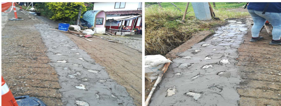
Ilustración 71 Vaciado de pavimentos.
