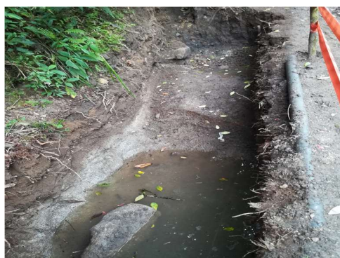
Ilustración 12 Excavación manual materia heterogeneo
