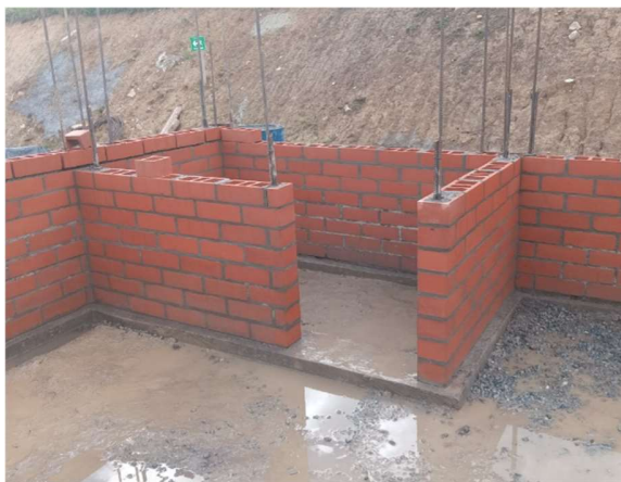
Ilustración 40 Construcción de muros de la caseta de operaciones
