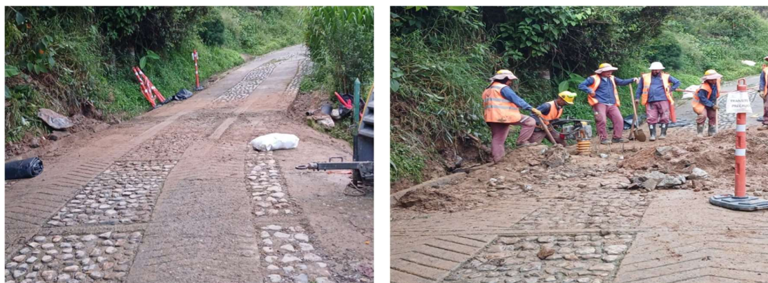
Ilustración 65 Registro de actividad de lleno con material de préstamo (base) cubriendo la tubería instalada.
