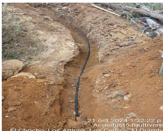
Ilustración 75 Registro de tubería instalada de 63 mm y prueba de presión en la misma
