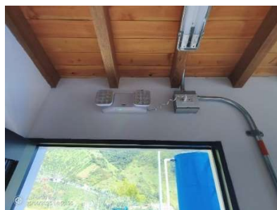
Ilustración 55 Instalación de lámpara de emergencia.
