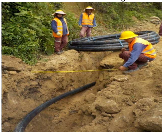
Ilustración 74 Registro de tubería instalada de 110 mm y prueba de presión en la misma
