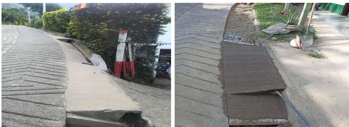
Ilustración 72 Vaciado de andenes.
