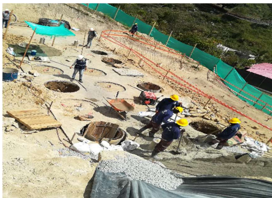
Ilustración 23 Excavación de 0 a 2 m. y construcción de anillo de protección en las pilas
