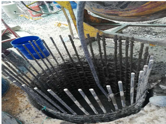
Ilustración 27 Actividad de vaciado y vibrado de las pilas.
