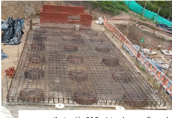
Ilustración 26 Registro de acero figurado e instalado para en la losa de la PTAP y pilas
