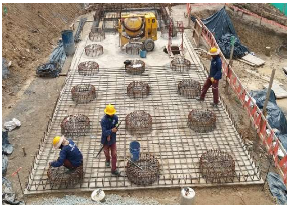
Ilustración 25 Solado para nivelación e instalación del acero de refuerzo
