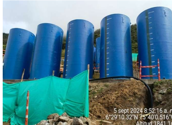
Ilustración 34 Cinco tanques de almacenamiento ubicados sobre la losa.
