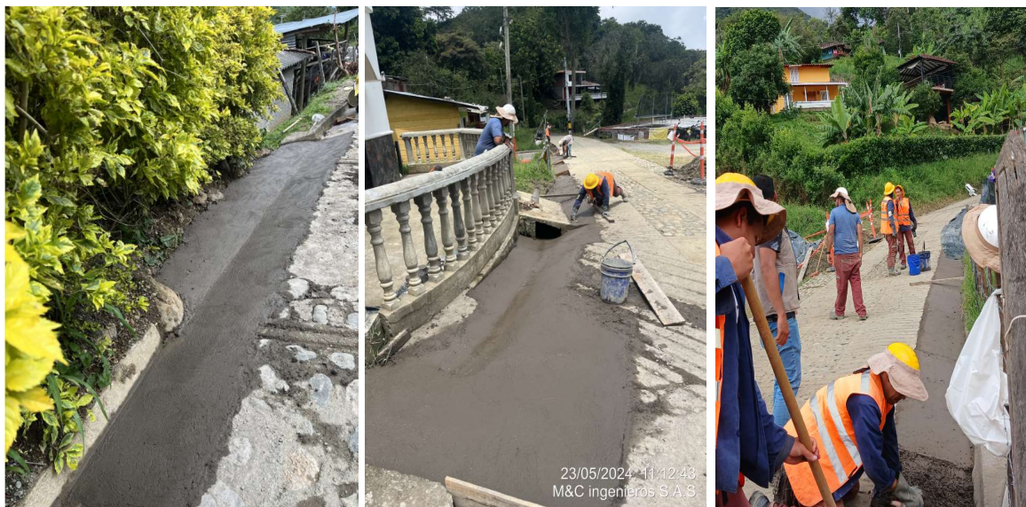
Ilustración 70 Vaciado de cunetas en V sector la Iglesia
