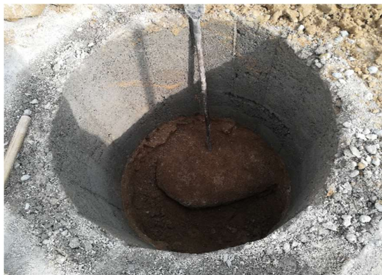
Ilustración 23 Excavación de 0 a 2 m. y construcción de anillo de protección en las pilas
