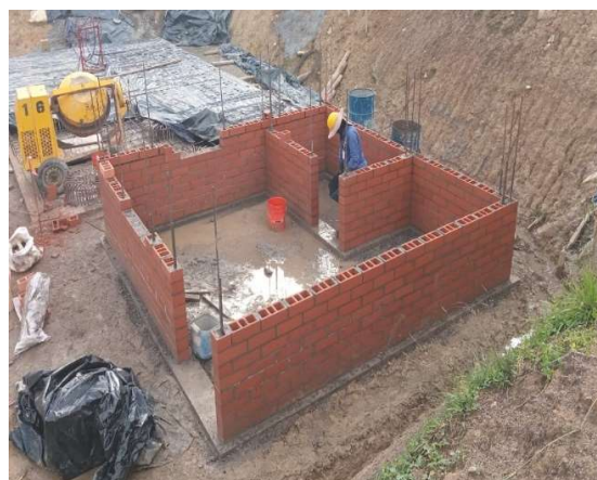
Ilustración 40 Construcción de muros de la caseta de operaciones
