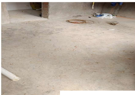
Ilustración 41 Mortero 1:4 de la caseta de operaciones
