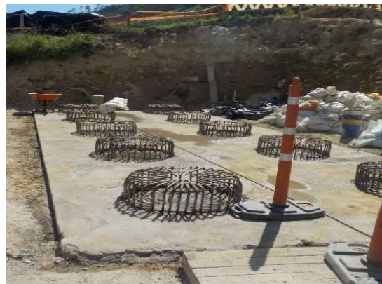
Ilustración 25 Solado para nivelación e instalación del acero de refuerzo
