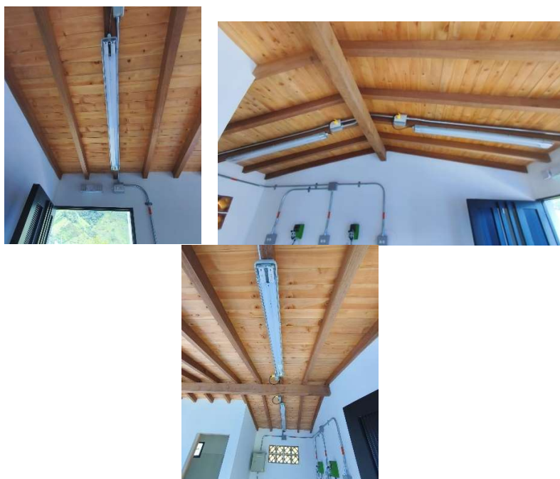
Ilustración 57 Instalación de lámparas de la caseta de operaciones.
