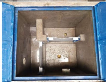
Ilustración 11. Vertederos triangular y rectangular de la caja de derivación.
