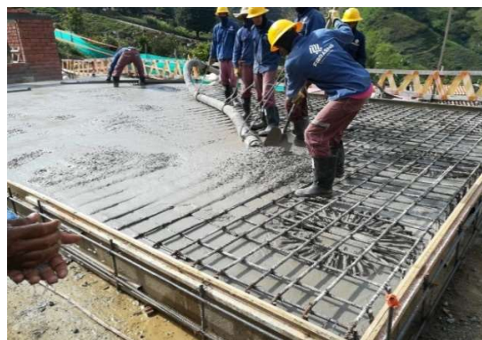
Ilustración 28 Actividad de vaciado u vibrado de las losas.
