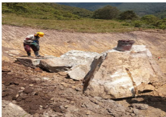
Ilustración 22 Excavación en roca
