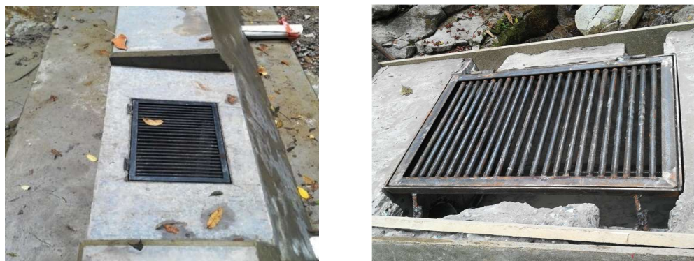
Ilustración 7 Rejilla Bocatoma
