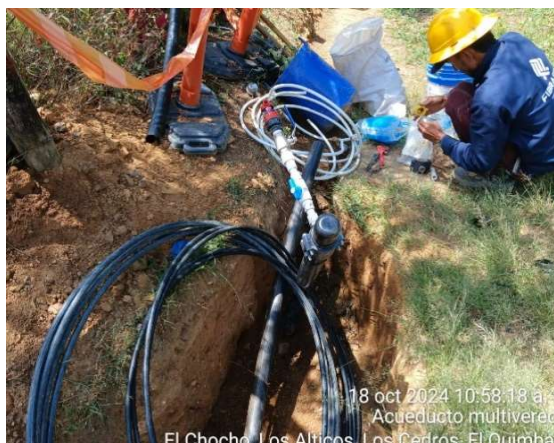
Ilustración 75 Registro de tubería instalada de 63 mm y prueba de presión en la misma
