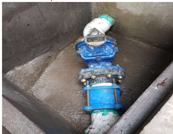
Ilustración 10. Válvula de compuerta sello elástico no ascendente
