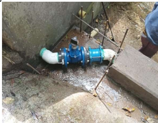
Ilustración 10. Válvula de compuerta sello elástico no ascendente
