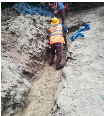
Ilustración 67 Registro de actividad de lleno con material de préstamo
