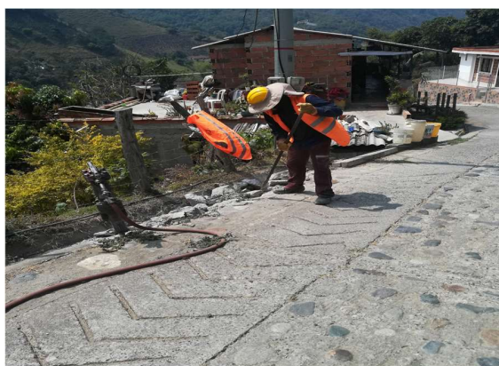
Ilustración 60 Registro de sito en el cual se requiere demoler cuneta para la instalación de la tubería.
