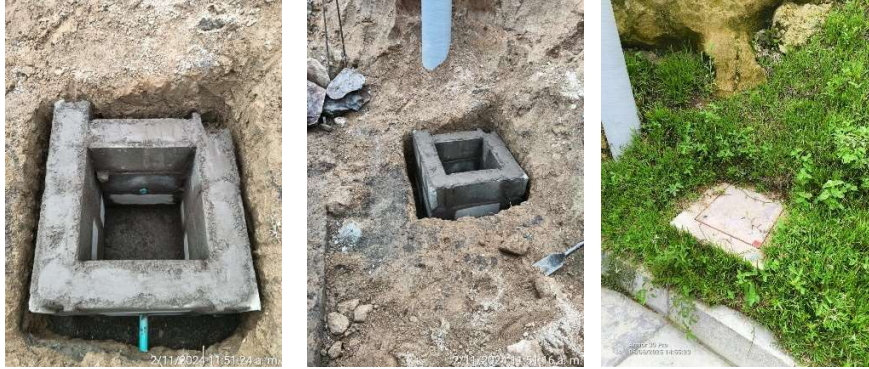
Ilustración 47 Construcción de cajas de distribución.
