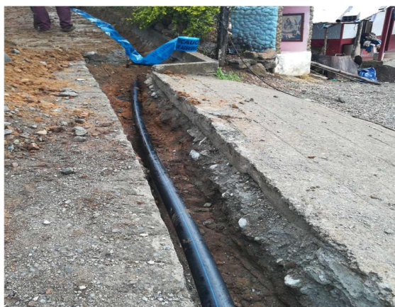
Ilustración 59 Demolición de pavimento rígido.
