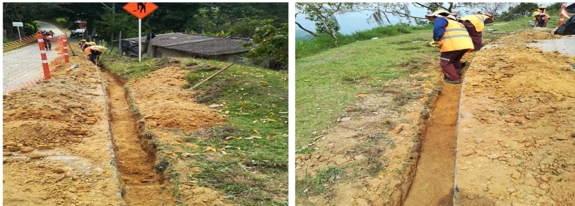
Ilustración 62 Registro zanjas de excavación
