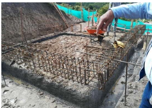
Ilustración 37 Solado de la caseta de operaciones.
