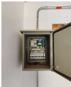
Ilustración 51 Instalación de breakers.
