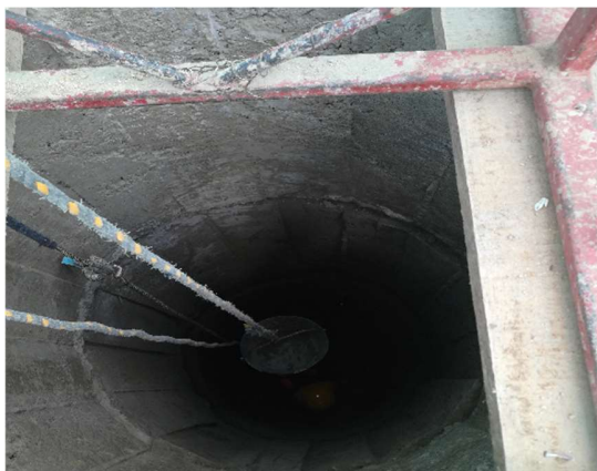
Ilustración 24 Excavación de 2 a 4 m. y construcción de anillo de protección en las pilas
