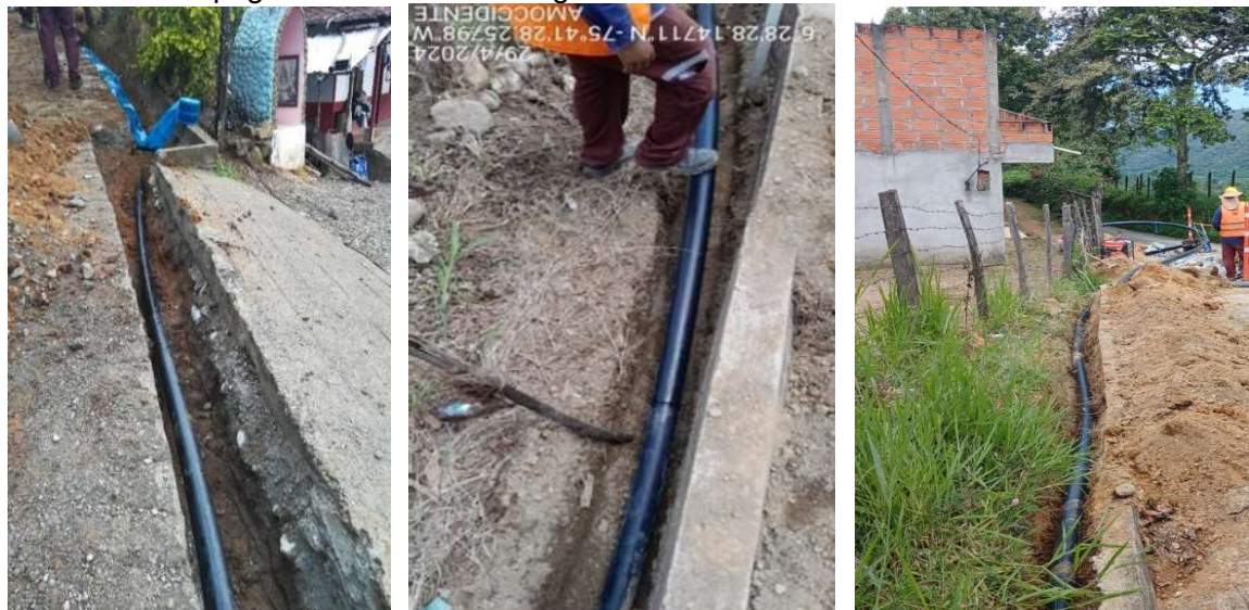
Ilustración 73 Registro de tubería instalada de 3".
