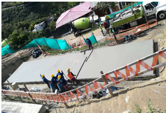
Ilustración 28 Actividad de vaciado u vibrado de las losas.
