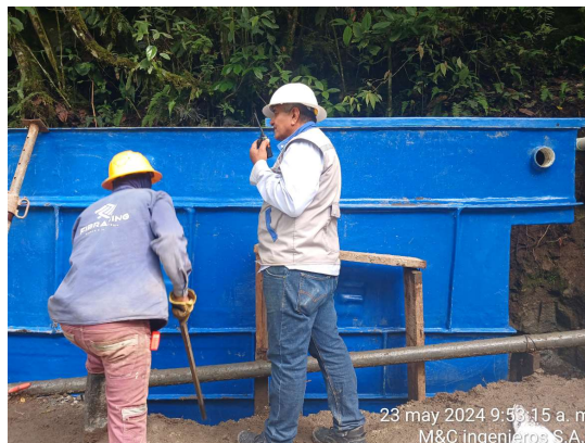
Ilustración 16 Instalación del desarenador.
