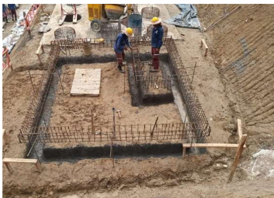
Ilustración 36 Excavación manual materia heterogéneo
