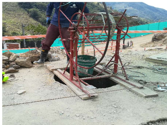
Ilustración 24 Excavación de 2 a 4 m. y construcción de anillo de protección en las pilas
