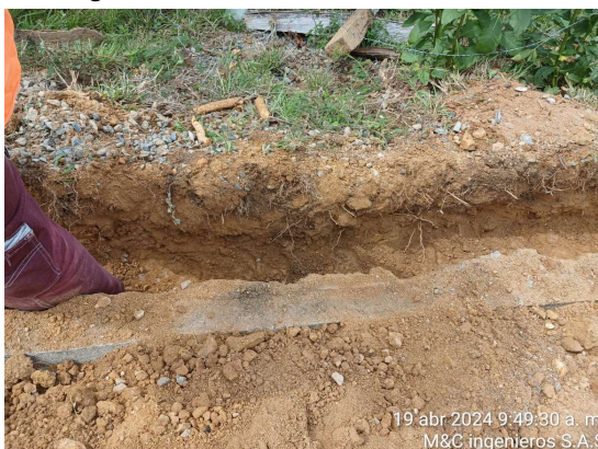
Ilustración 64 Registro de aspecto final del terreno del lleno haciendo uso del material procedente de la excavación.
