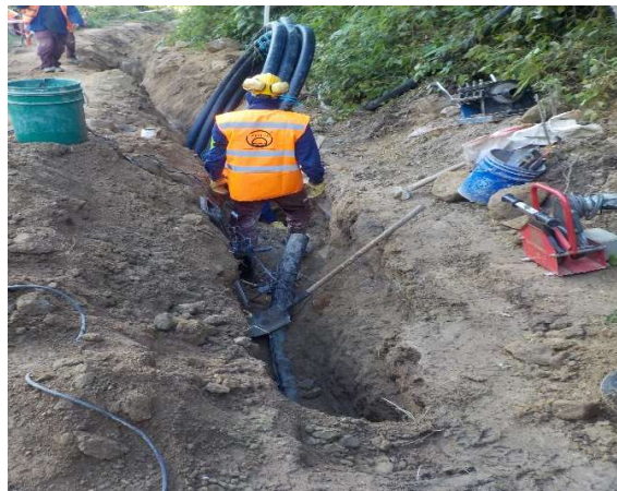
Ilustración 74 Registro de tubería instalada de 110 mm y prueba de presión en la misma
