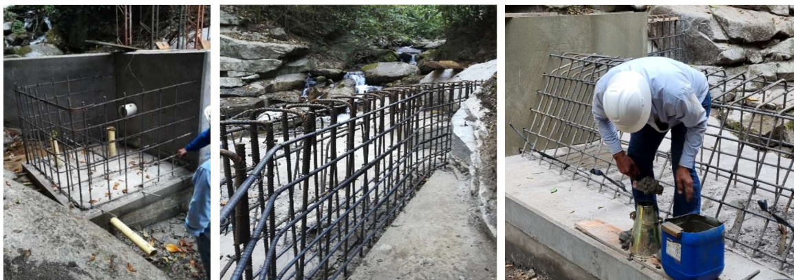
Ilustración 6 Acero figurado y anclado en la aleta derecha.
