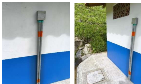
Ilustración 56 Instalación de red de ingreso a la caseta.
