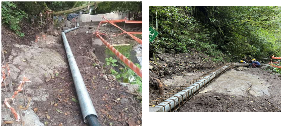
Ilustración 69 Registro de encamisado de tubería en acero en 6" en la bocatoma
