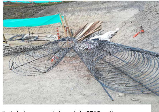
Ilustración 26 Registro de acero figurado e instalado para en la losa de la PTAP y pilas
