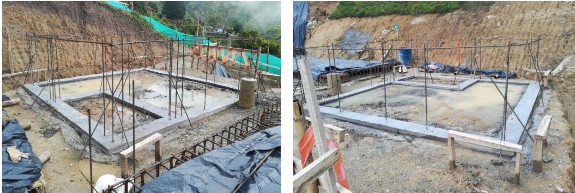
Ilustración 39 Vigas de cimentación de la caseta de operaciones
