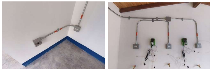
Ilustración 54 Instalación de tomas de corriente.
