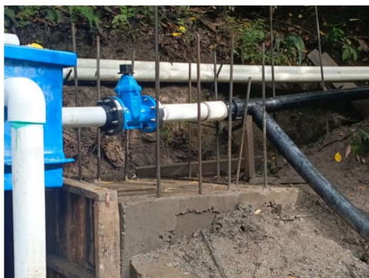
Ilustración 17 Instalación de válvulas compuerta.
