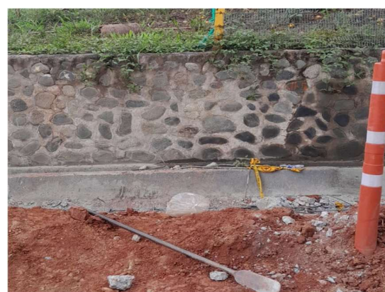
Ilustración 60 Registro de sito en el cual se requiere demoler cuneta para la instalación de la tubería.
