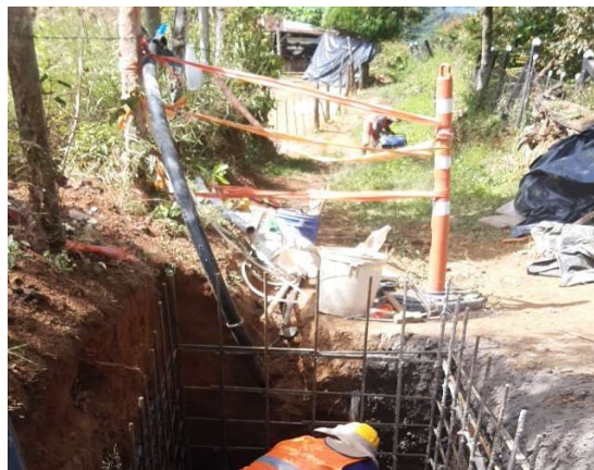
Ilustración 76 Registro de tubería instalada de 50 mm y prueba de presión en la misma
