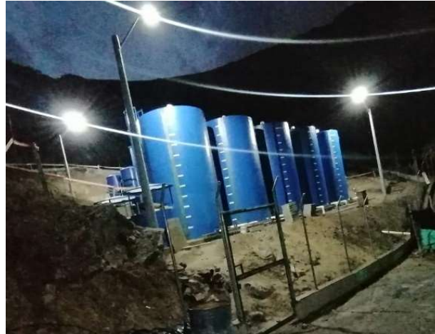
Ilustración 45 Construcción e instalación de postes en PRFV.
