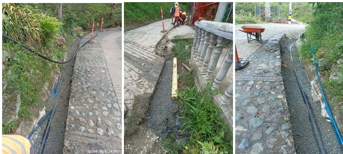
Ilustración 66 Registro de actividad de instalación de entresuelo en la zanja
