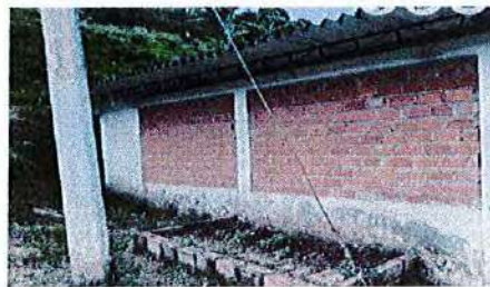
Ilustración No. 40 – Instalacion muro en ventanas desmontadas del Aula
