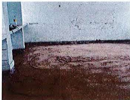
Ilustración No. 18 – Relleno con recebo compactado aulas 1 y 2.
