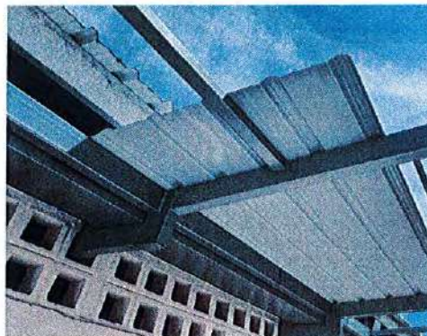
Ilustración No. 51 – Instalacion cubierta termoacústica
