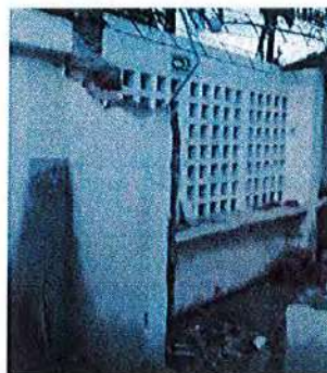
Ilustración No. 13 – Demolición muro aula 1.
