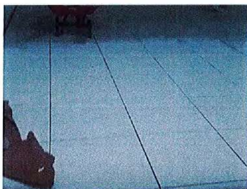
Ilustración No. 27 – Instalacion de enchape aula 1 y 2.
