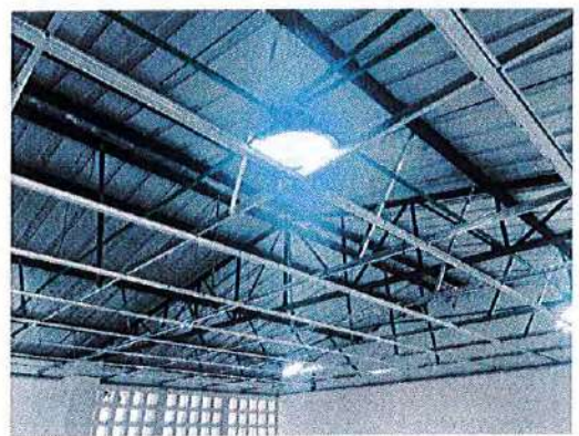
Ilustración No. 30 – Instalacion cielorraso PVC, aula 1 y 2
