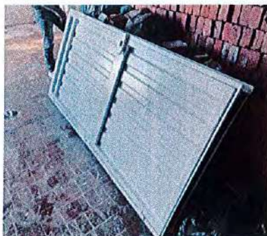
Ilustración No. 25 – Pintura en esmalte sintético en lamina llena para carpintería metálica – puertas aulas 1 y 2
