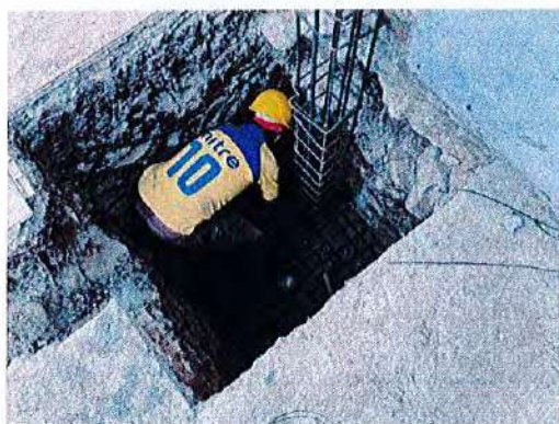
Ilustración No. 20 – Aceros de columnas, zapatas, viga de cimentación y viga área.
