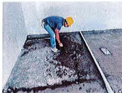
Ilustración No. 37 – Alistado de mortero aulas 2 y 3.
