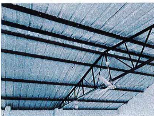
Ilustración No. 29 – Instalacion de teja termoacústica aulas y pasillo.
