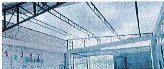
Ilustración No. 48 – desmonte de cubierta existente
