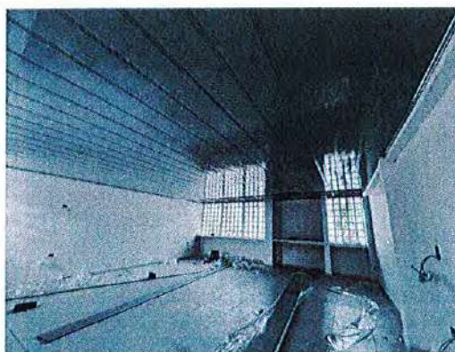
Ilustración No. 30 – Instalacion cielorraso PVC, aula 1 y 2
