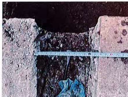
Ilustración No. 17 – Excavación de aulas vigas de cimentación.
