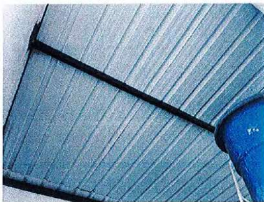
Ilustración No. 29 – Instalacion de teja termoacústica aulas y pasillo.
