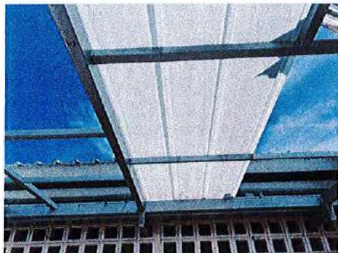
Ilustración No. 51 – Instalacion cubierta termoacústica
