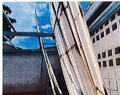
Ilustración No. 50 – Desmonte de cubierta existente
