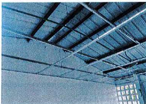
Ilustración No. 32 – Instalacion tubería Conduit 1/2" circuitos de luminarias, tomacorrientes e interruptores para aula 1 y 2
