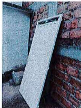
Ilustración No. 16 – Desmonte de puerta aula 1.
