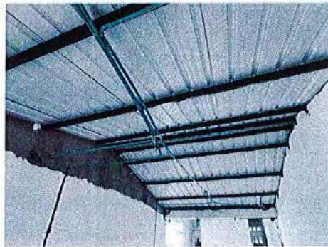
Ilustración No. 32 – Instalacion tubería Conduit 1/2" circuitos de luminarias, tomacorrientes e interruptores para aula 1 y 2
