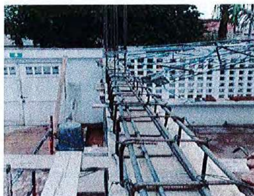
Ilustración No. 20 – Aceros de columnas, zapatas, viga de cimentación y viga área.
