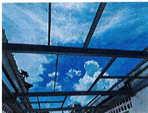
Ilustración No. 50 – Desmonte de cubierta existente
