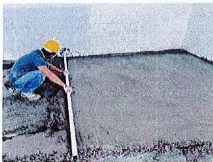
Ilustración No. 37 – Alistado de mortero aulas 2 y 3.
