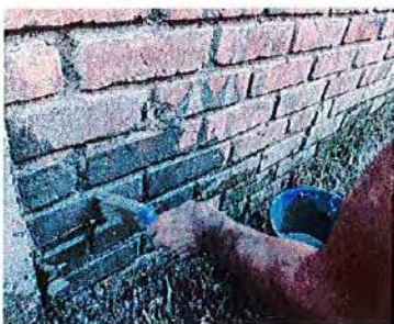
Ilustración No. 43 – aplicación producto Sika para impermeabilización de muros fachada posterior y lateral
