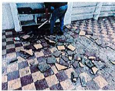
Ilustración No. 14 – Demolición placa aulas 1 y 2.
