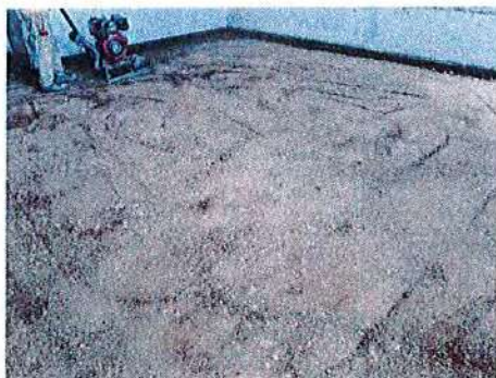
Ilustración No. 18 – Relleno con recebo compactado aulas 1 y 2.
