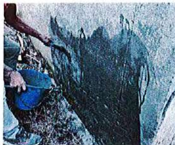
Ilustración No. 43 – aplicación producto Sika para impermeabilización de muros fachada posterior y lateral
