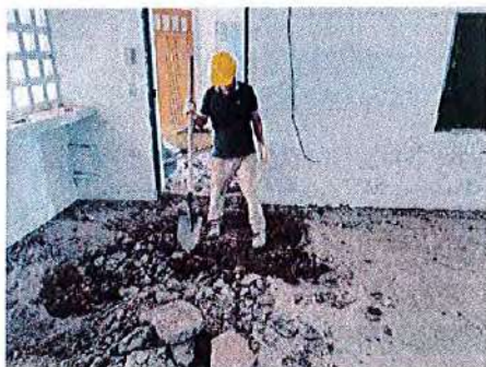
Ilustración No. 17 – Excavación de aulas vigas de cimentación.
