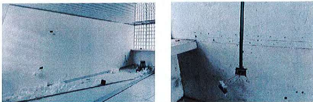
Ilustración No. 35 – Instalacion punto eléctrico para tomacorrientes doble, aula 1 y 2
