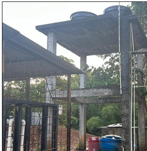
Ilustración 19. Registro de la estructura del tanque
