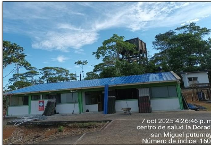
Ilustración 11. Instalación de cubierta
