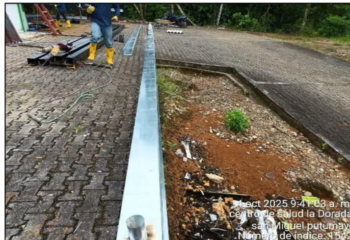
Ilustración 12. Instalación de canales galvanizados.
