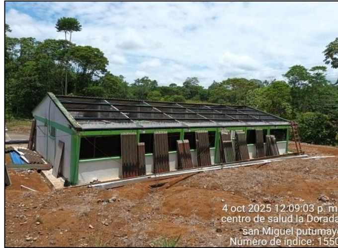
Ilustración 9. Instalación de perfiles
