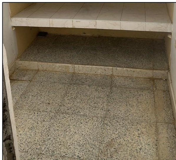
Ilustración 26. Piso con manchas y veteado
