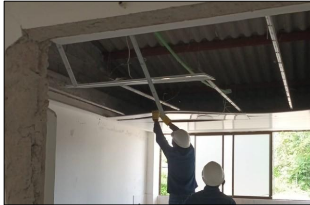
Ilustración 2. Desmonte de cielo raso
