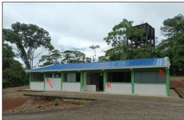
Ilustración 8. Ubicación de pintura
