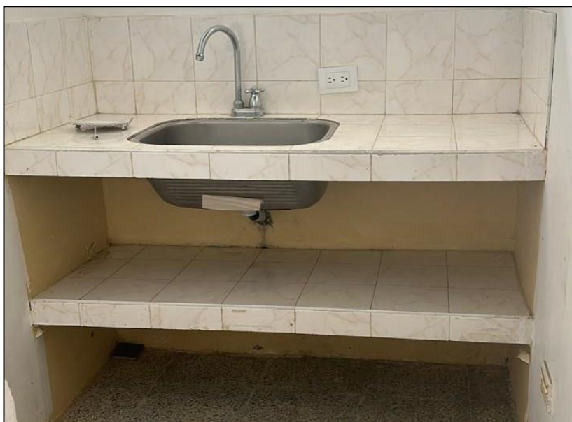
Ilustración 28. Punto eléctrico tomacorriente 110 V
