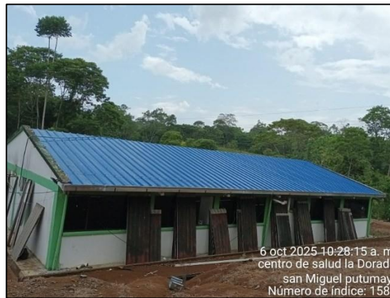
Ilustración 10. Instalación de cubierta
