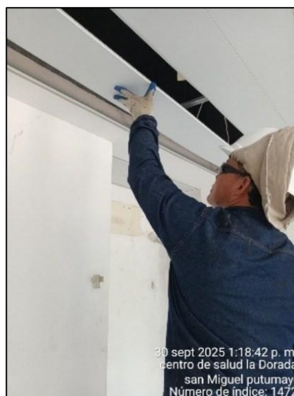
Ilustración 1. Desmonte de cielo PVC
