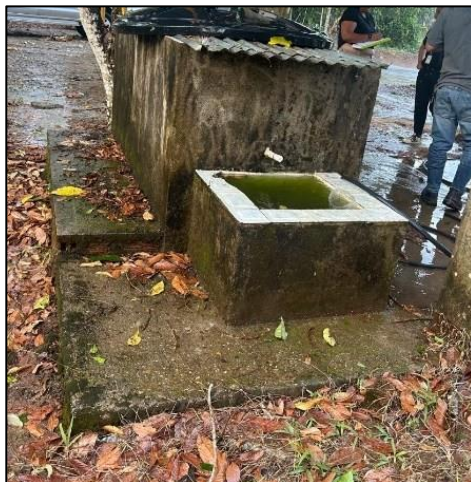
Ilustración 20. Registro del lavadero
