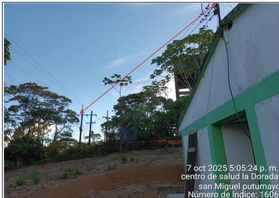
Ilustración 23. Conexión Acometida
