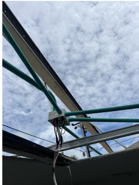
1.7 Retiro de cielo falso
