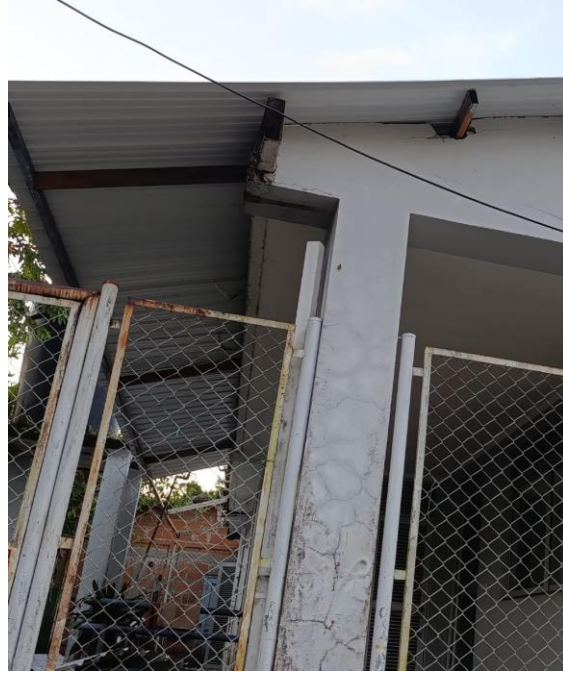
1.5 Retiro de canal pvc
