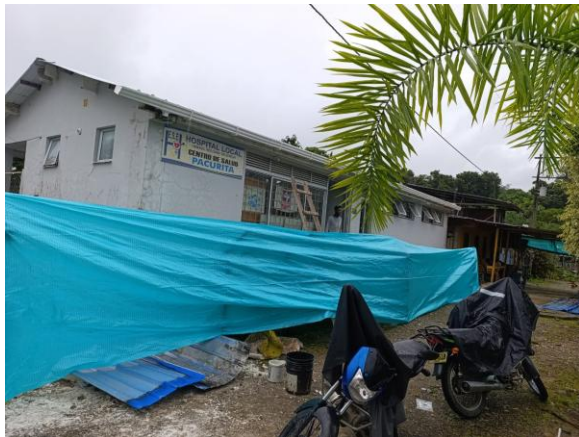
1.1. Instalación de cerramiento en lona verde
