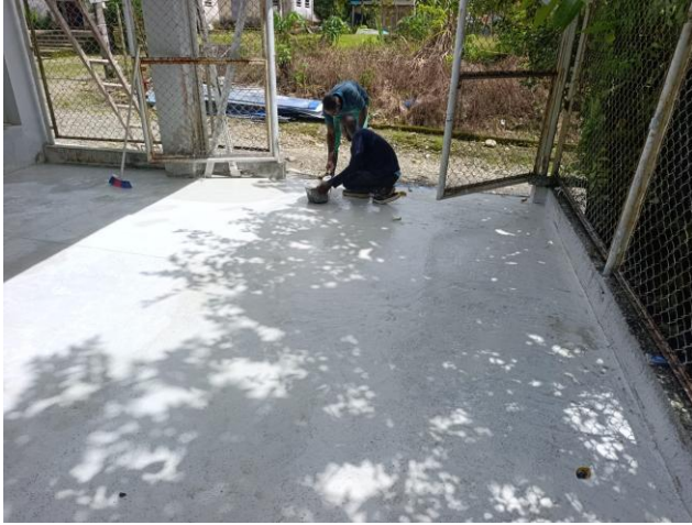
1.8. Aplicación de granito
