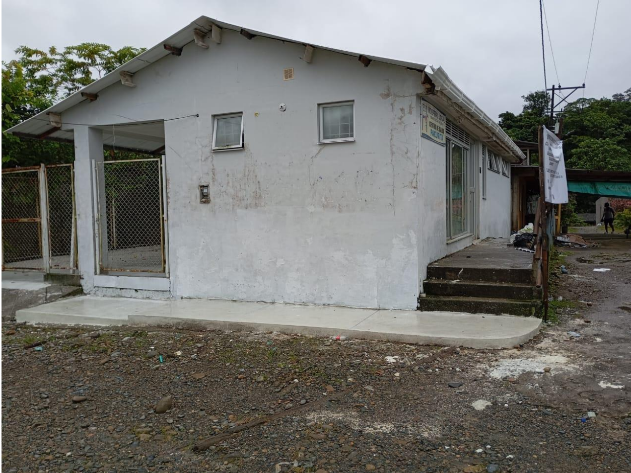
Fotografía de la fachada principal
