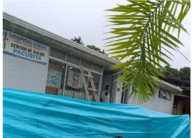
4.1. Instalación canal pvc
