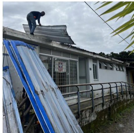
1.2. Retiro de Cubierta
