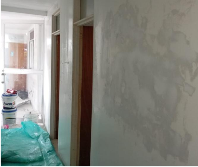
4.2 Aplicación de estuco
