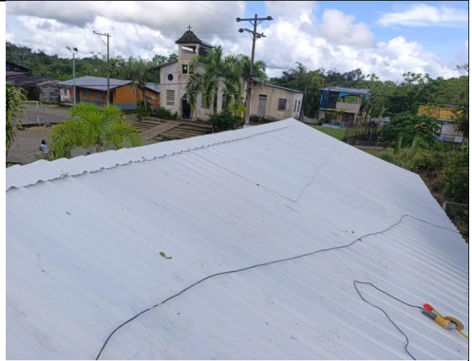
2.1. Instalación de cubierta termo acústica
