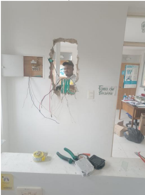
1.6.Retiro de aparatos electricos
