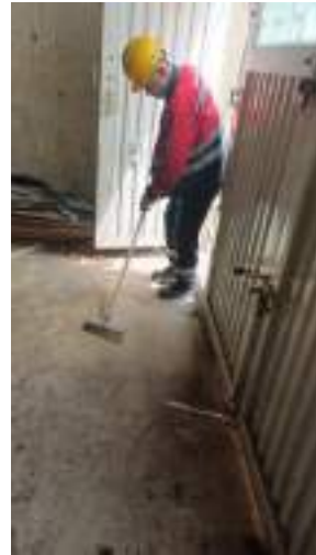
Implementación del cepillo en obra
