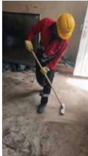
Implementación del cepillo en obra
