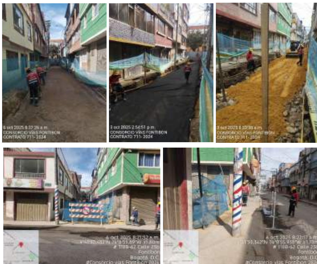
Fotografías 13 a 17 subsanación de observación
