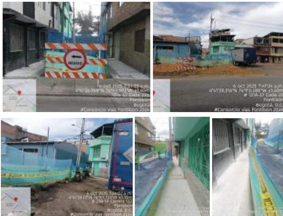
Fotografías 18 a 22 subsanación de observaciones
