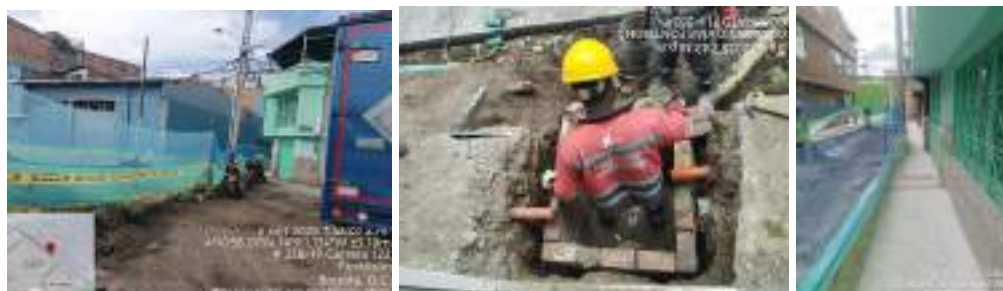
Fotografías 8 a 12 subsanación de observaciones
