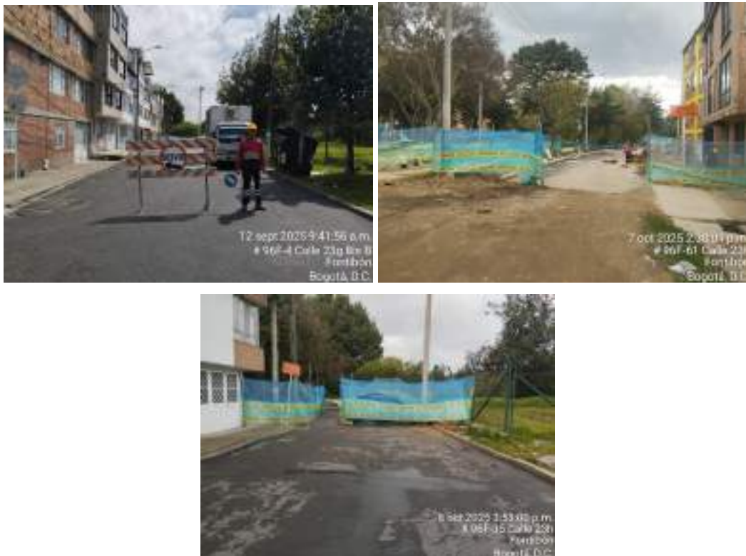
Fotografías 1 a 3 subsanación de observaciones
