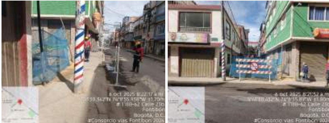
Fotografías 6 a 7 subsanación de observación
