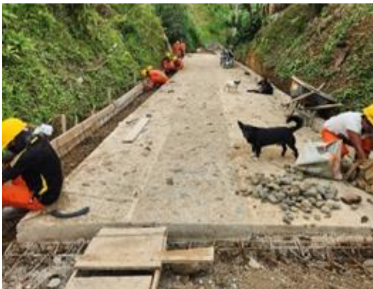
Imagen. Construcción placa huellas vía de acceso a caseta comunal – vereda Corinto.
