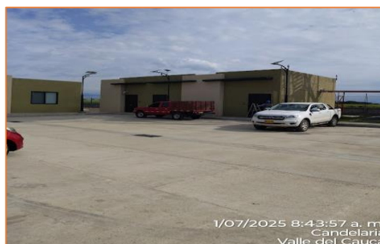
Ilustración 3 Nueva sala de comunicaciones
