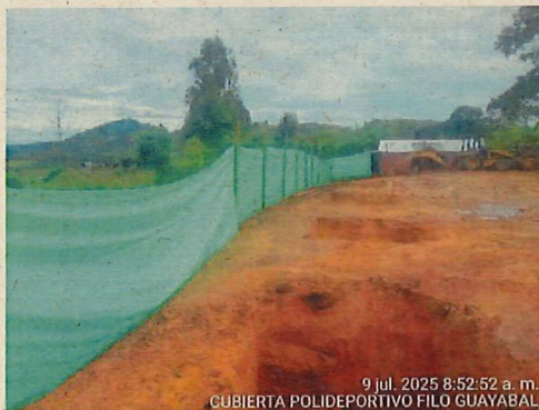
Excavacion para Zapatas – Eje B
