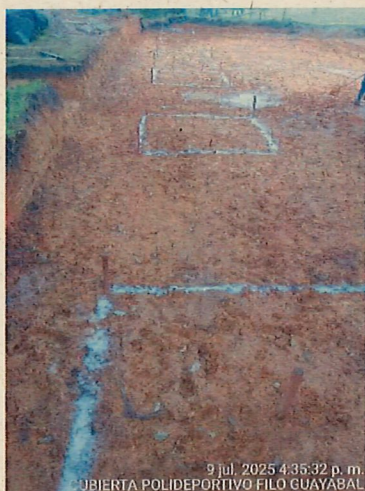
Localizacion de zapatas eje A
