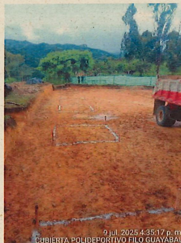
Localizacion de zapatas eje A
