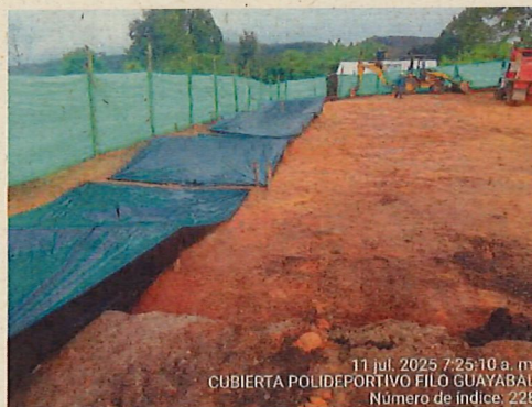
Excavacion para Zapatas – Eje B
