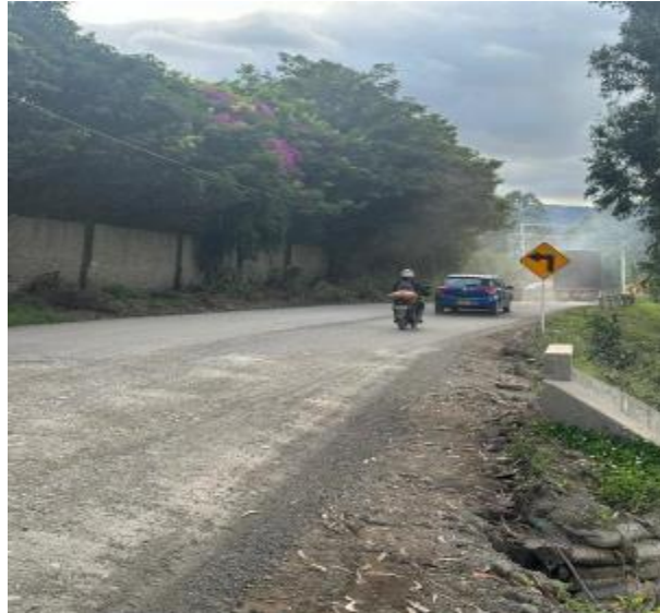
Ilustración 6. Registro fotográfico Tramo 2
