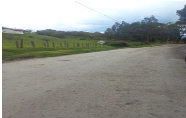
Ilustración 5. Registro fotográfico Tramo 1
