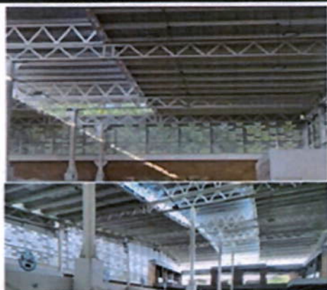
Imagen. Cubierta del techo
