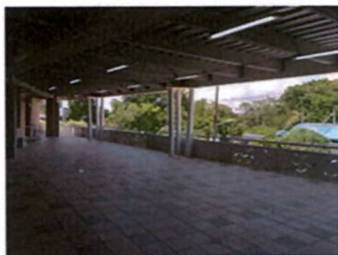
Imagen. Fachada principal 2do piso
