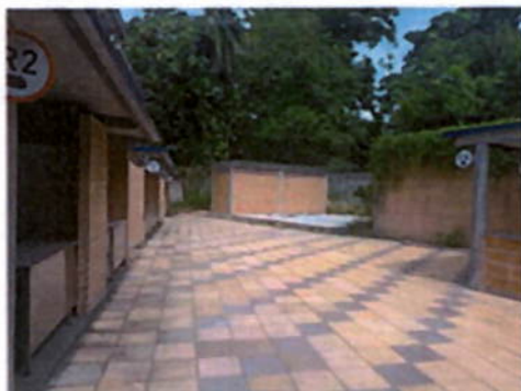
Imagen. Zona de equipamiento público transitable
