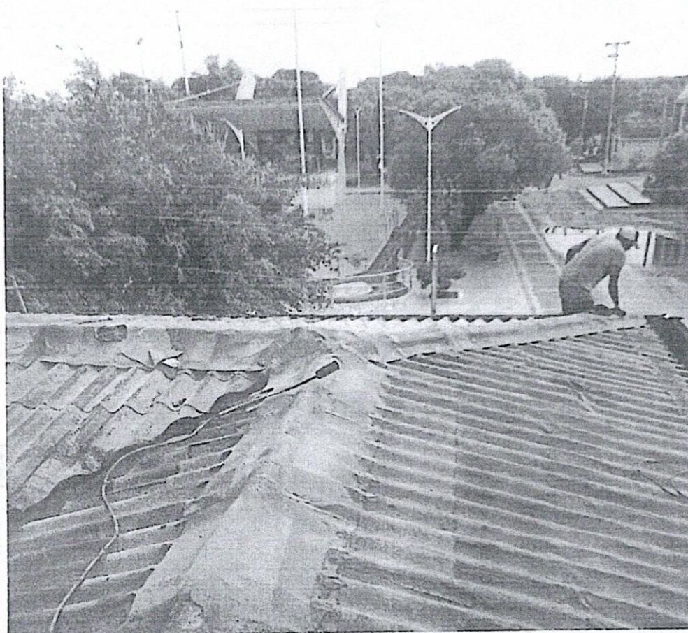
IMPERMEABILIZACION DE CUBIERTA
