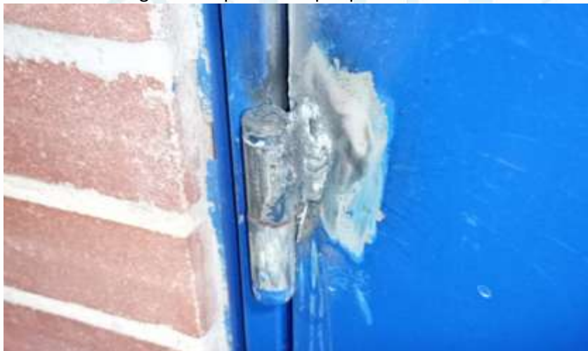
-Cambio de bisagras en la puerta del parqueadero
