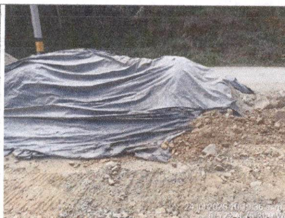
Foto 5. Protección de materiales
