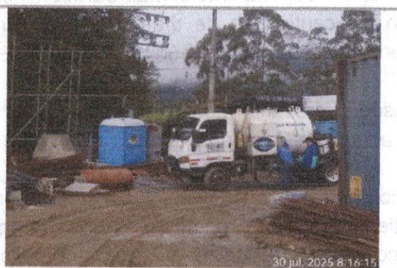
Foto 13. Estado de la bodega principal
