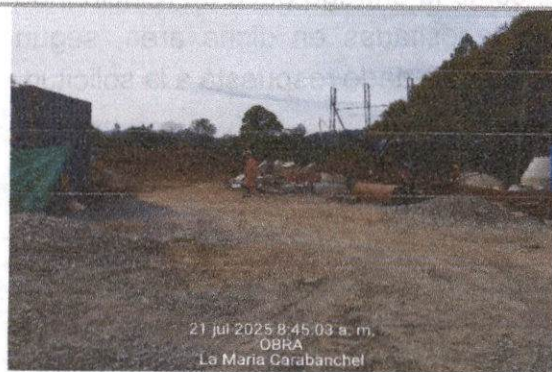
Foto 12. Estado de la bodega principal
