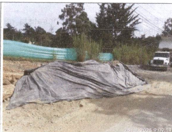
Foto 6. Protección de materiales
