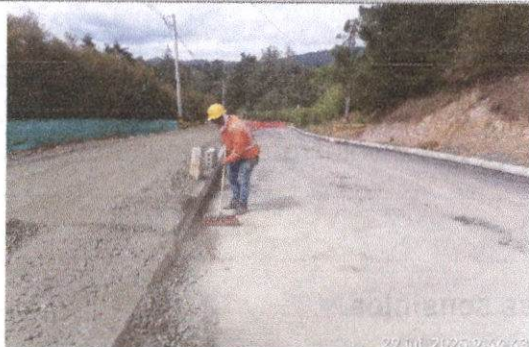
Foto 45. Limpieza de vías
