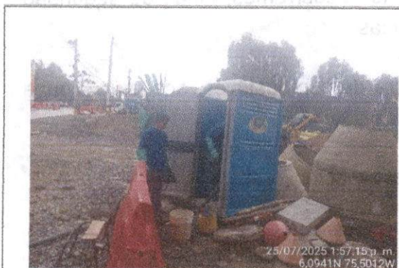
Foto 26. Limpieza de unidades sanitarias
