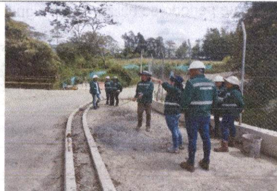
Foto 50. Recorrido de obra
