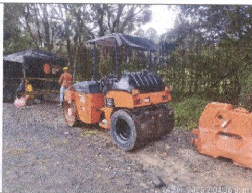
Foto 61. Rodillo compactador para asfalto
