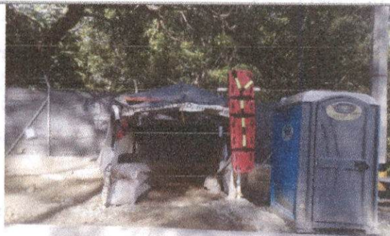
Foto 46. Instalaciones temporales en obra
