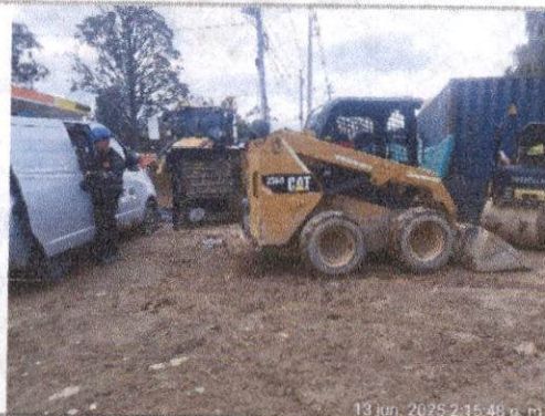
Foto 56. Minicargador utilizado en obra
