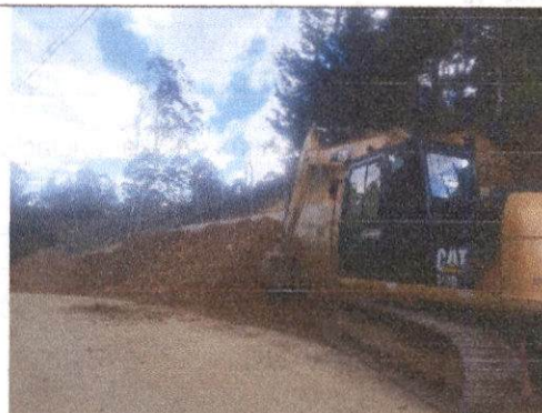
Foto 17. Evacuación de material de excavación
