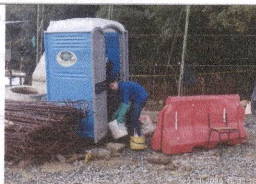
Foto 27. Limpieza de unidades sanitarias
