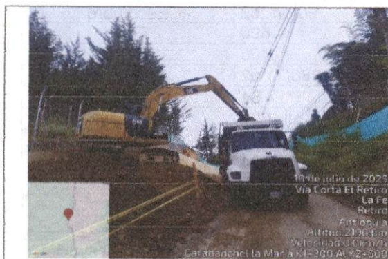
Foto 16. Evacuación material de excavación
