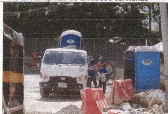
Foto 29. Limpieza de unidades sanitarias
