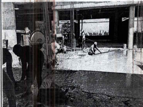
FOTO 13: Fundicion de placa entrepiso de losa de pasarela n 3
