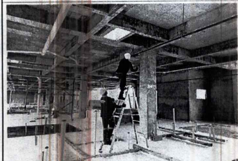
FOTO 16: Instalacion de redes rci para bloque n 1
