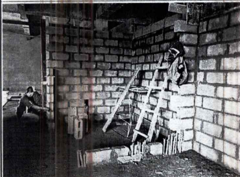
FOTO 10: Levante bloque n 12, relleno para los muros de subestacion
