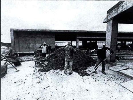
FOTO 1: Relleno para área de pasarela 3
