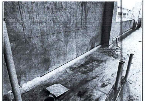
FOTO 6: Instalacion de media caña para piso pulido, radio de cm de 10cm x8 cm
