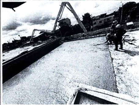
FOTO 20: Fundición de losa de cubierta para pasarela 1, en concreto 4000 psi
