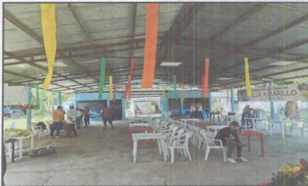
FOTO 33 - 36: Muestra la verificación de las especificaciones técnicas del ítem 1.2.3 "MERCADO CAMPESINO FLOR AMARILLO DENOMINADO LA VACA LECHERA" en el marco de la ejecución del contrato de prestación de servicios No. 255 de 2025, se verificó la instalación en el sitio de 25 mesas plásticas para la acomodación de los productos.
