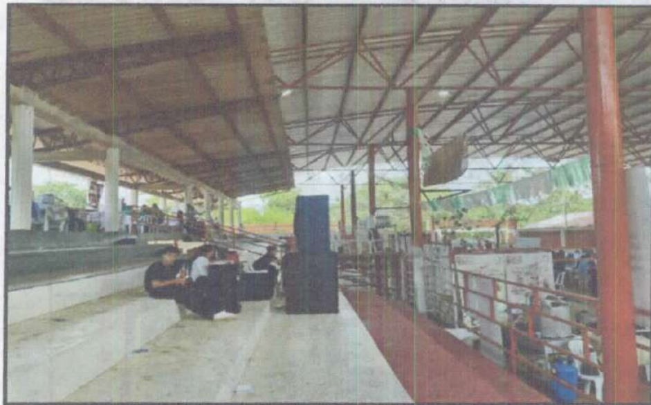
FOTO 01 - 04: Muestra la verificación de las especificaciones técnicas del ítem 1.3.1 "MERCADO CAMPESINO DENOMINADO CAMPESENA" en el marco de la ejecución del contrato de prestación de servicios No. 255 de 2025, Se verificó el montaje y funcionamiento del sonido profesional en sistema convencional de mínimo 12000v de potencia con consola digital de 32 canales microfonería.
