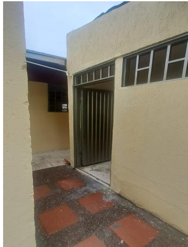
Suministro e Instalación de marco metálico, pintura de marco y puerta y vinilo para muros.
