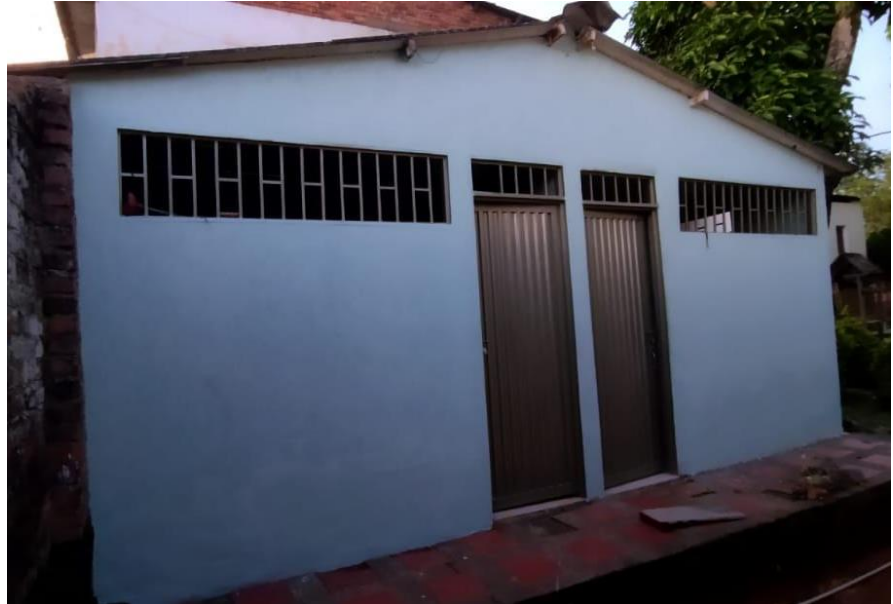
Pintura final batería sanitaria camilo torres
