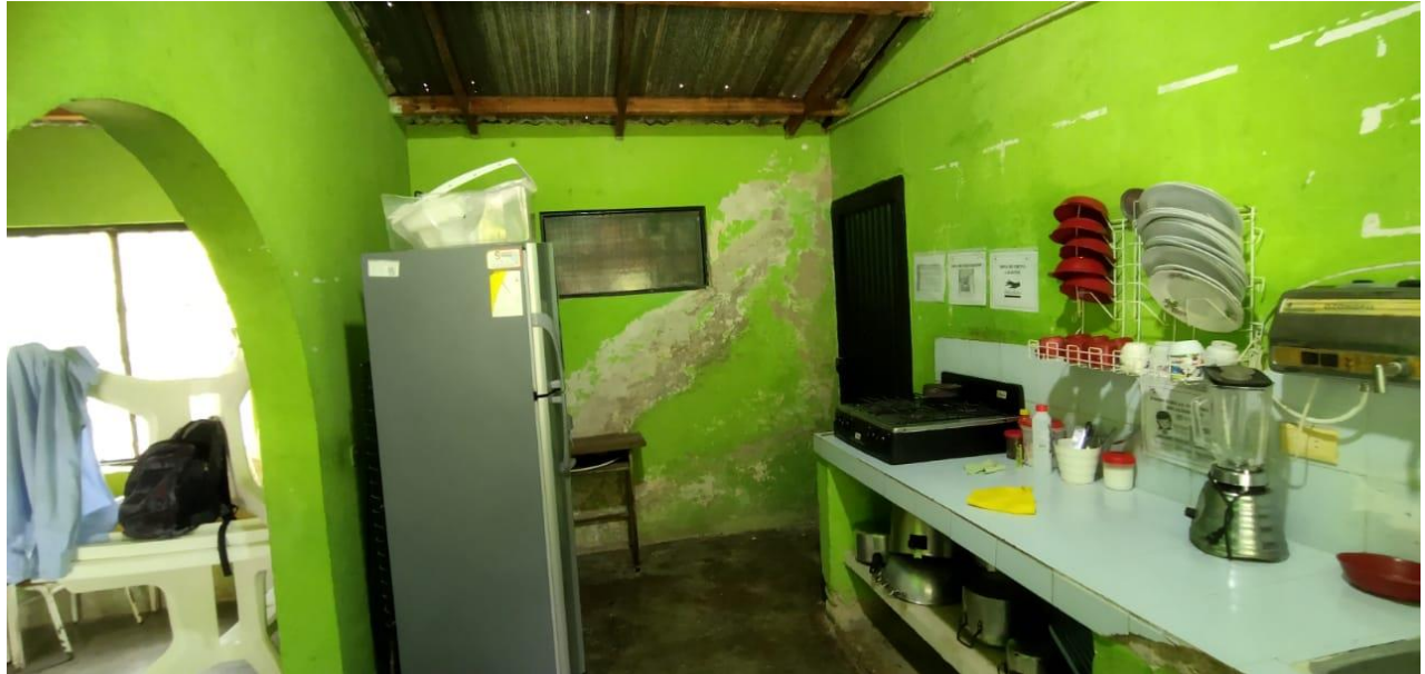
Pintura de muros existente
