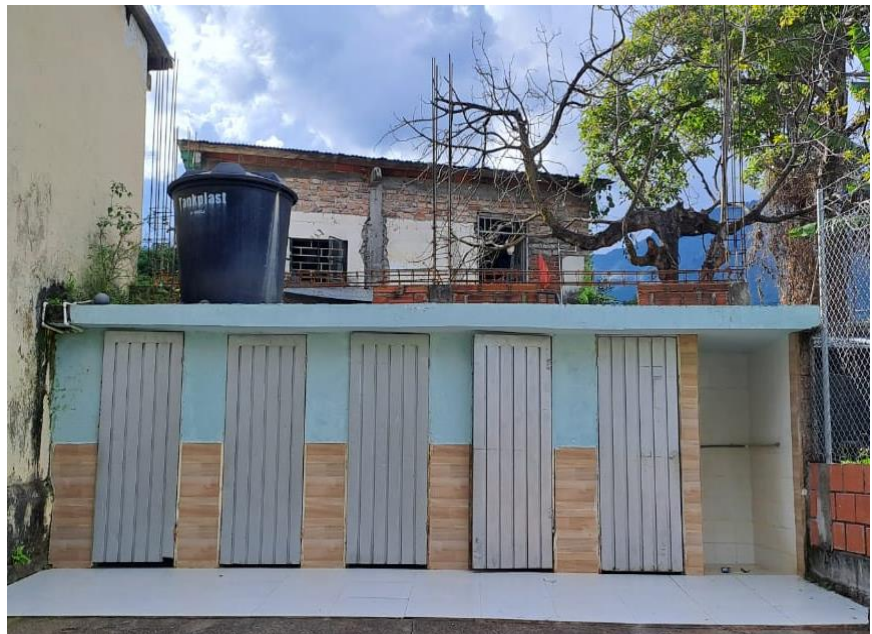
Fachada final Batería sanitaria camilo torres, resane y pintura en vinilo.
