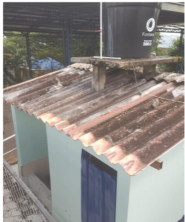
Instalación tejas de eternit, existentes.
