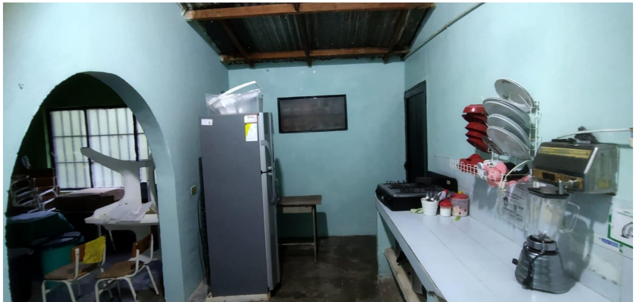
Pintura final de cocina
