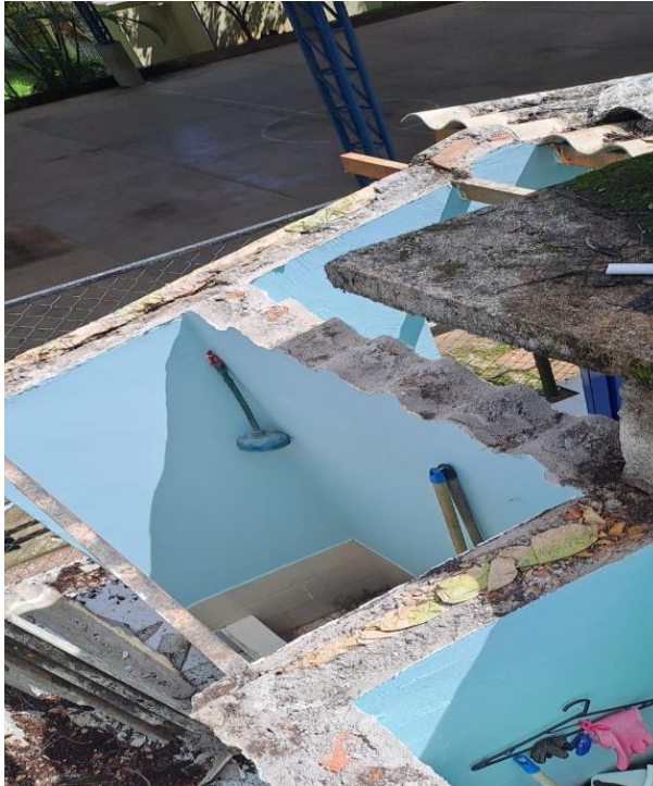
Desmante de tejas de eternit, para cambio.
