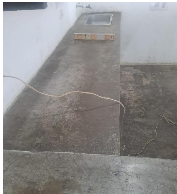
Mesón en concreto existente.
