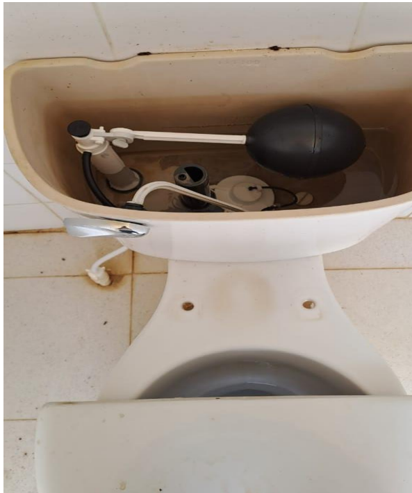
Suministro e instalación de kit de llenado y Vaciado sanitario sede Camilo Torres
