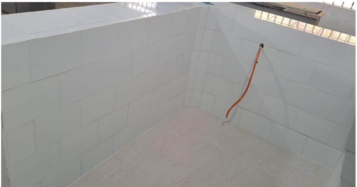
Se observa el enchape final del mesón sede Villa María
