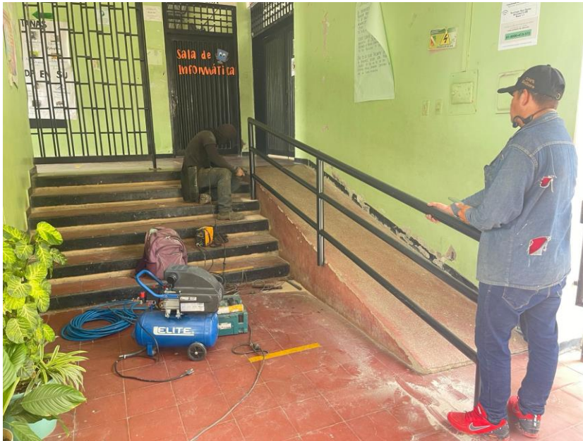
Instalación de pasamanos en tubo cold rolled
