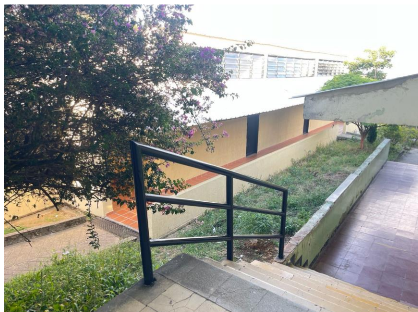
Se observa la instalación de pasamanos
