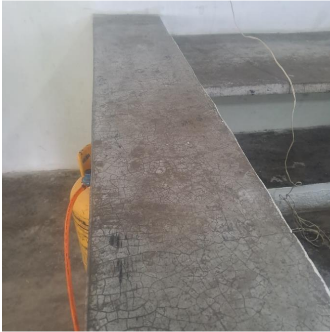
Mesón en concreto existente
