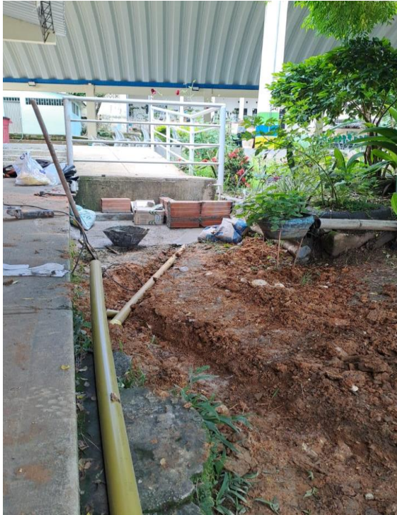
Construcción de poceta sede camilo torres
