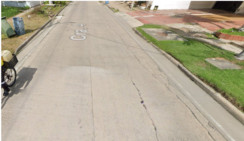
Intervención carrera 4 entre 5 y 6 (Antes – Después)
