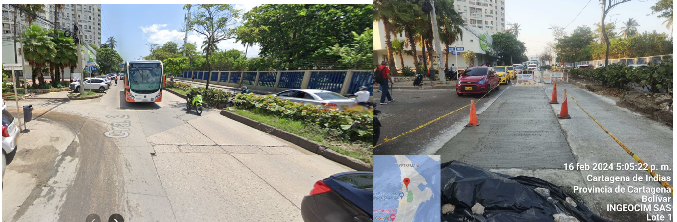
Intervención Entrada Boca grande carrera 2 con 14 (Antes – Después)
