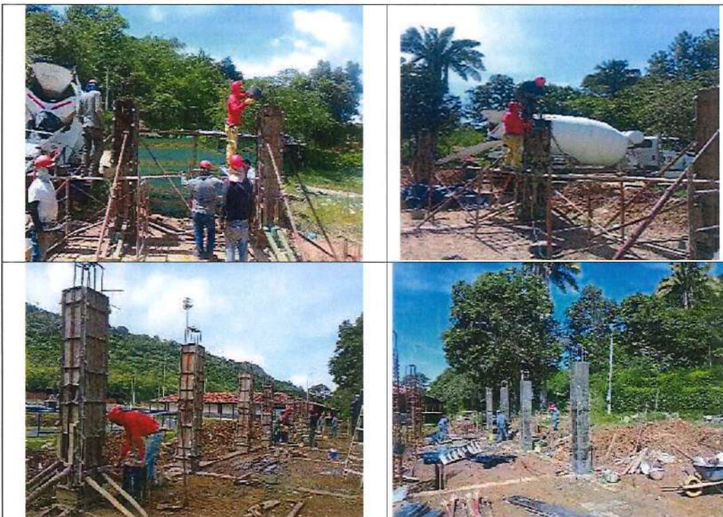
Fundidas de columnas para la zona administrativa
