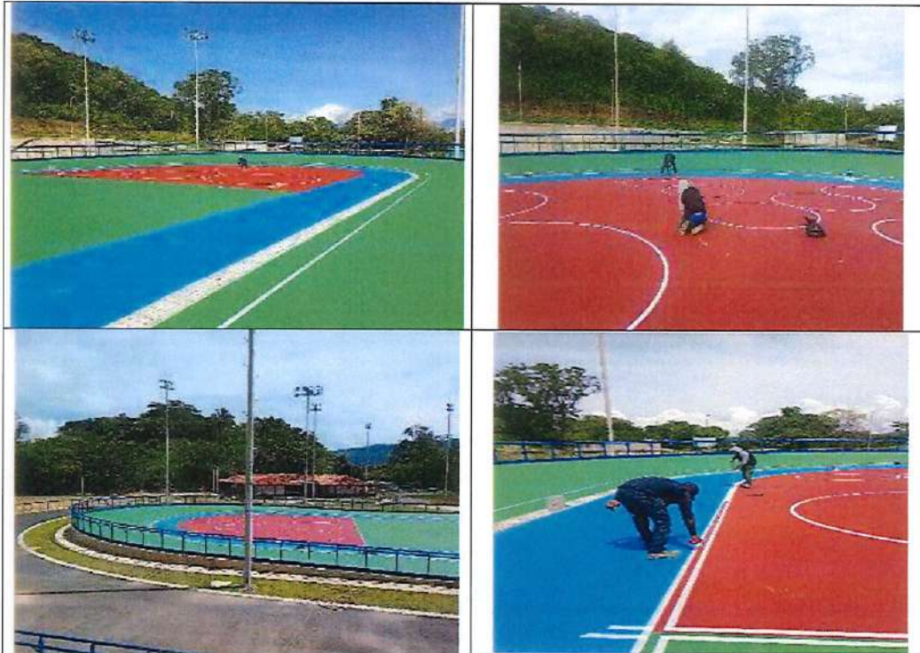
Recubrimiento para la pista de 200m interna
