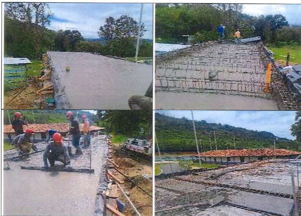
Fundidas de placa aligerada para la zona administrativa
