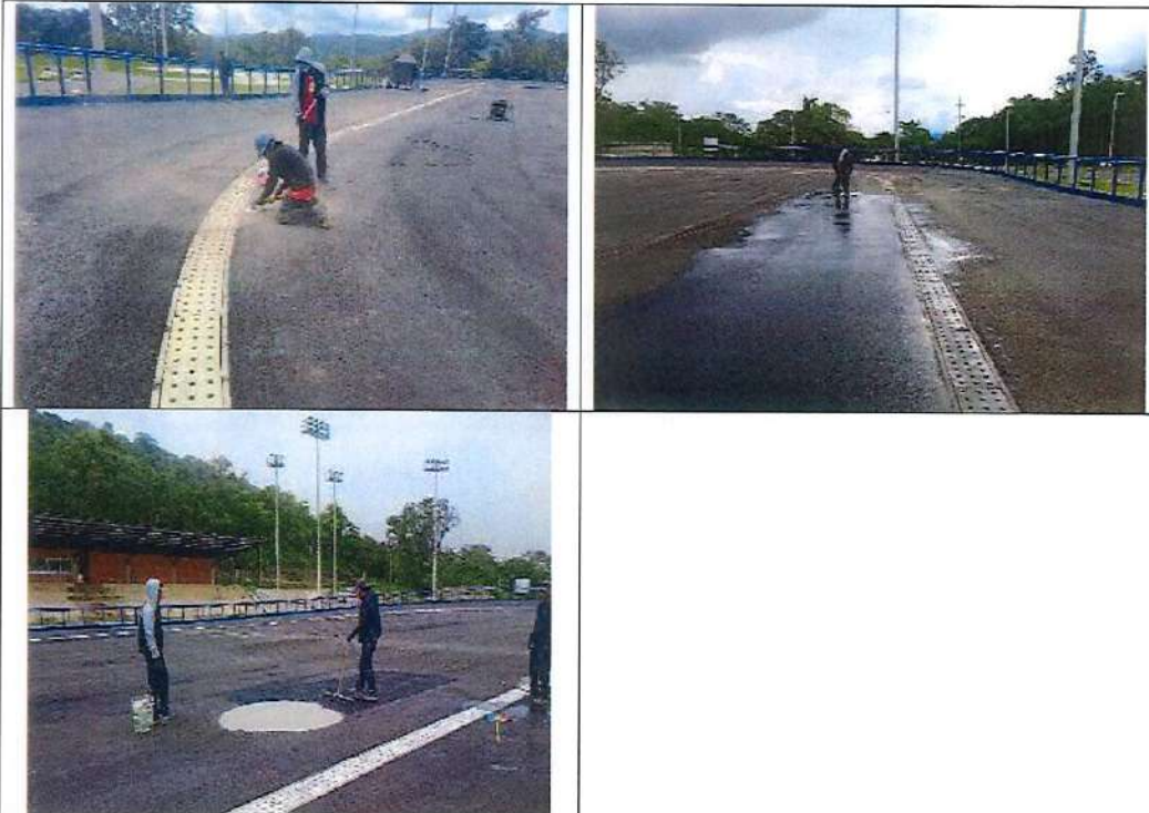
Preparacion de la pista de 200m interna
