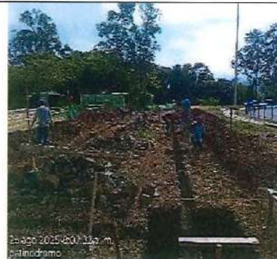
Excavaciones para la cimentación de las zapatas y vigas
