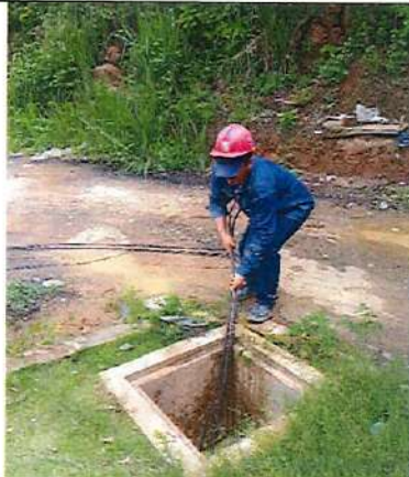
Extendido de cable #02 de cobre para apantallamiento
