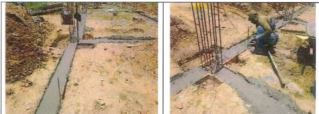
Fundidas de vigas de amarre para la zona administrativa
