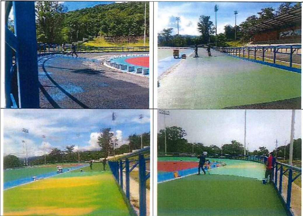
Recubrimiento de la pista de 200m ovalo
