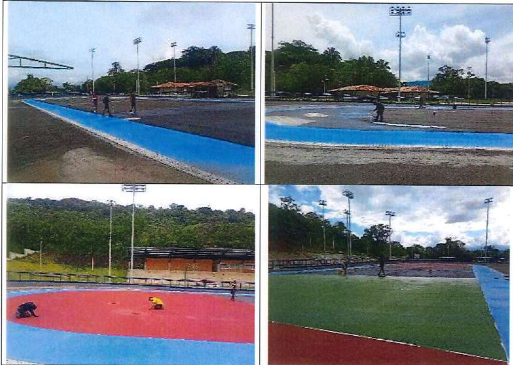
Recubrimiento para la pista de 200m interna
