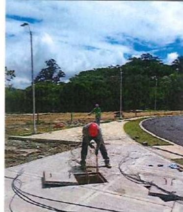
Extendido de cable #02 de cobre para apantallamiento
