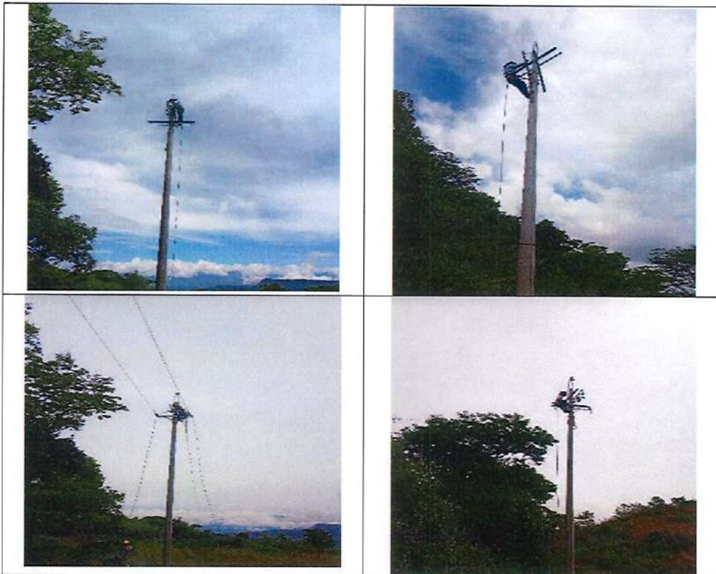
Instalacion de estructura Media tensión en postes
