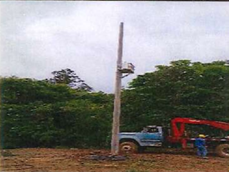
Instalación de transformador para el proyecto
