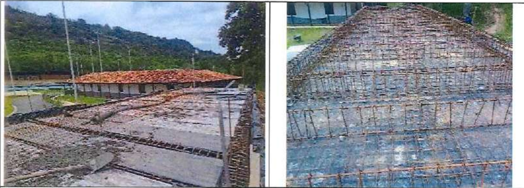
Malla electrosoldada para placa superior de la zona administrativa
