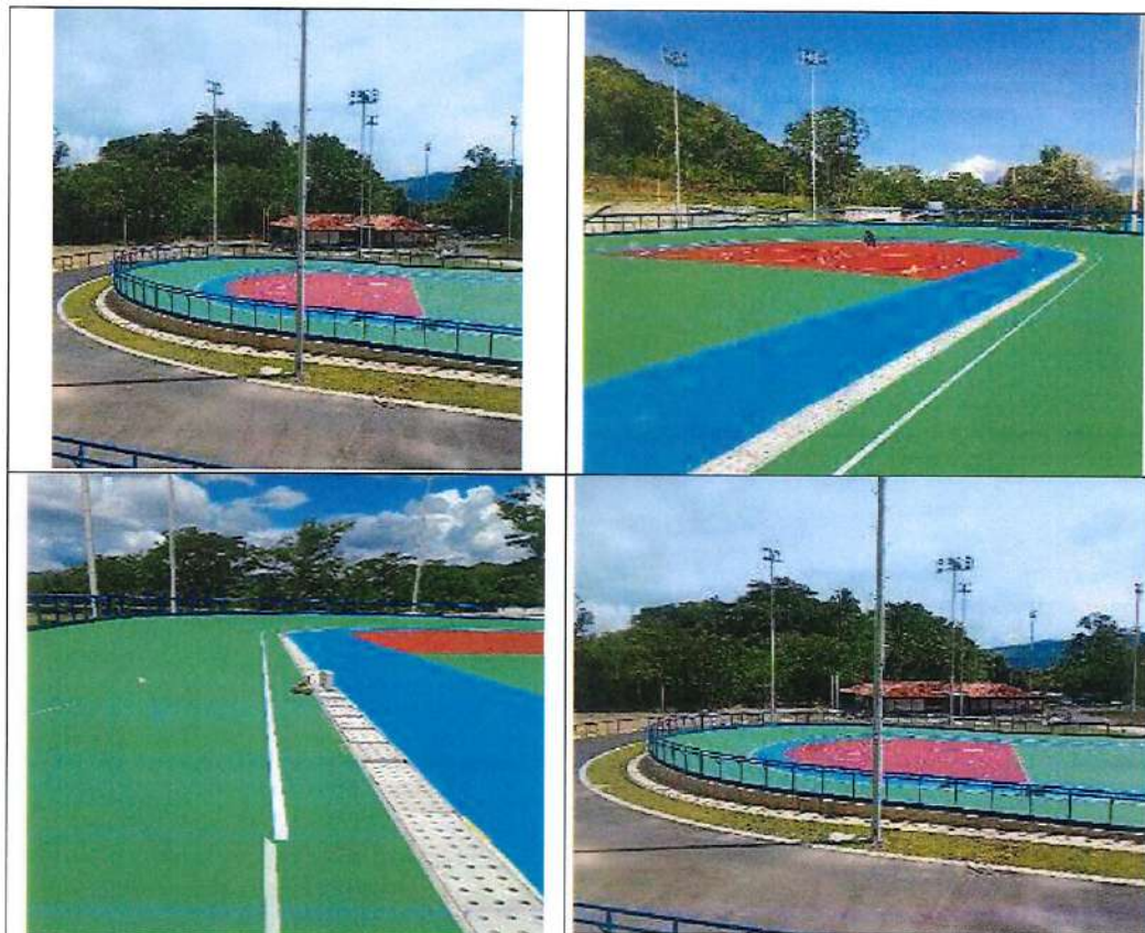
Recubrimiento de la pista de 200m ovalo
