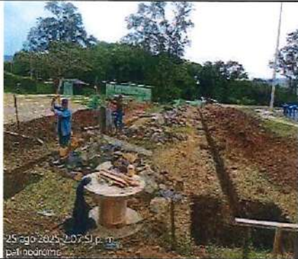
Excavaciones para la cimentación de las zapatas y vigas
