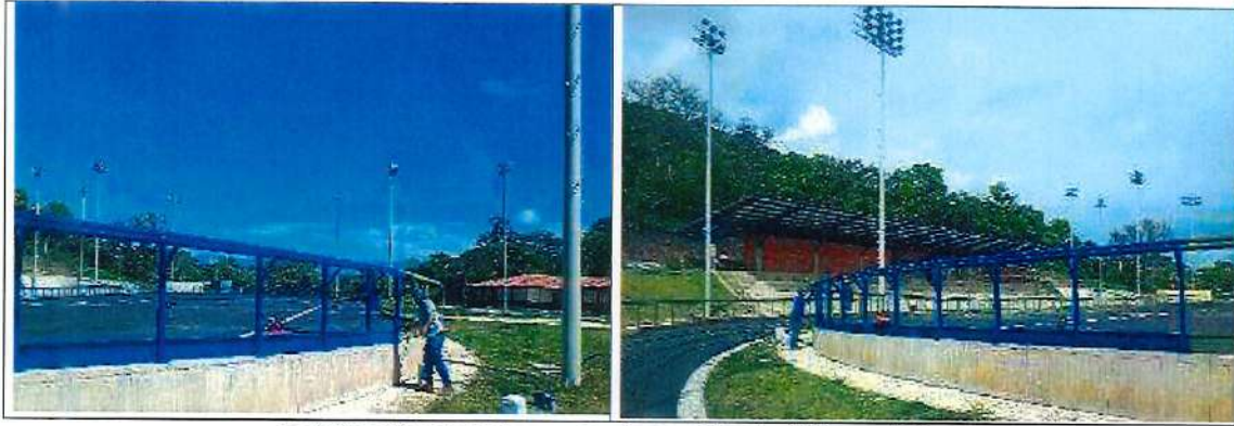
Fabricación de la baranda de la pista de 200m y 400m
