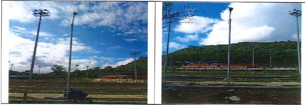
Instalación de luminarias para postes de 6.5m
