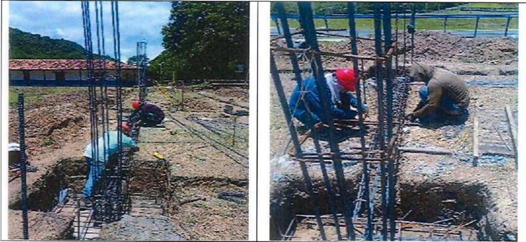
Acero de refuerzo para zapatas columnas, vigas y viguetas para la zona administrativa
