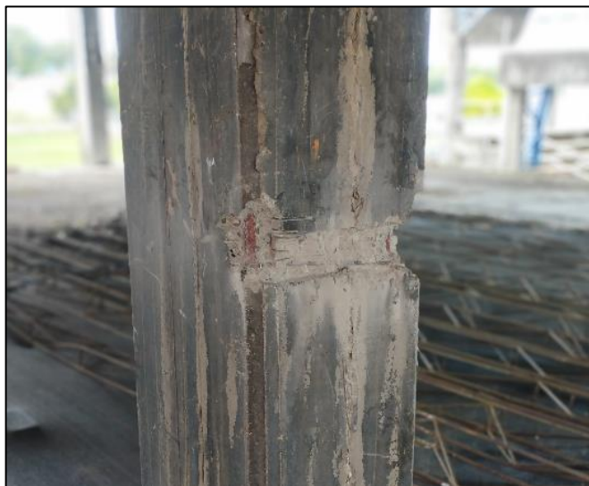
Ilustración 31: Regatas sobre concreto (Col C2 Piso 2). Ilustración 32
