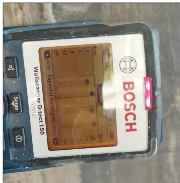
Ilustración 20: Resultado escaneo de refuerzo transversal de columnas en zona confinada.
