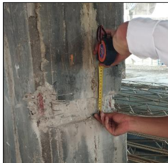
Ilustración 33: Medición diámetro y separación refuerzo longitudinal y transversal de columnas (Col C2 Piso 2).
