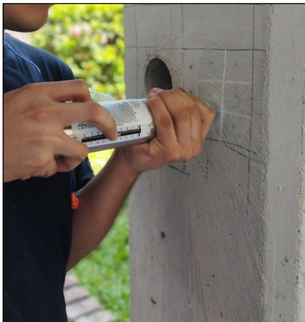
Ilustración 15: Ensayo de rebote (Col D5 Piso 1).
