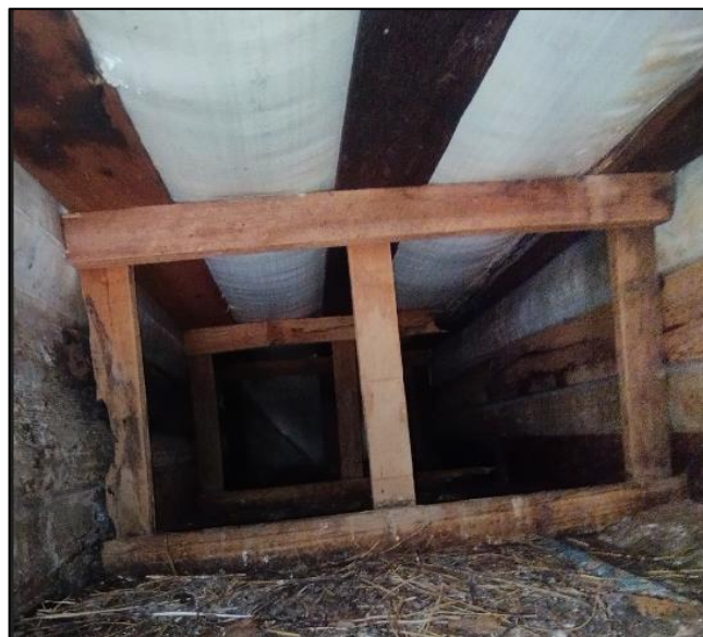
Ilustración 23: Configuración placa aligerada de entrepiso.
