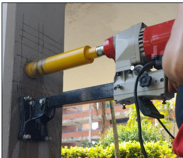
Ilustración 11: Extracción núcleo No. 1 (Col D5 Piso 1)
