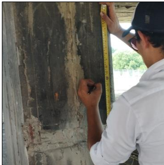
Ilustración 21: Medición separación de estribos de columnas
