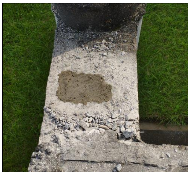
Ilustración 35: Cobertura de regata hecha en vigas (Viga D1-2 Piso 2).
