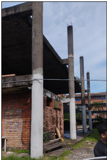
Ilustración 6: Fachada lateral eje 1 estructural. Ilustración 7:
