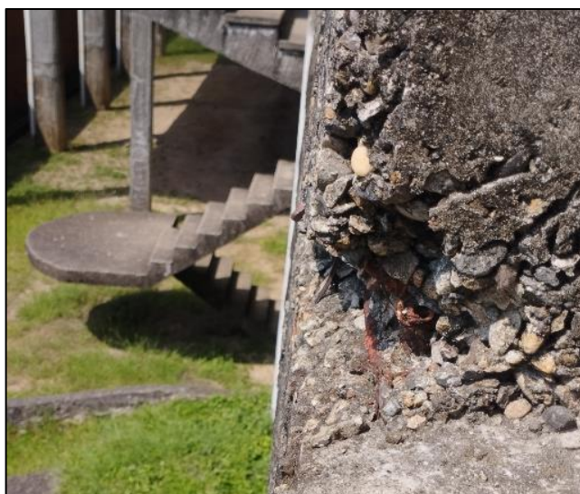
Ilustración 40: Hormigoneo de concreto.
