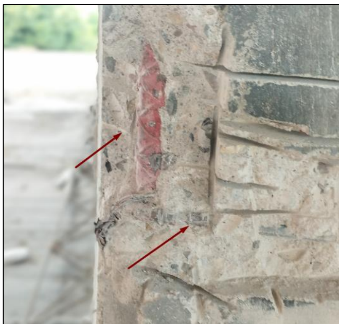
Ilustración 34: Identificación de acero de refuerzo de columnas.
