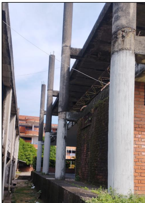
Ilustración 9: Fachada lateral eje 6 estructural. Ilustración 10
