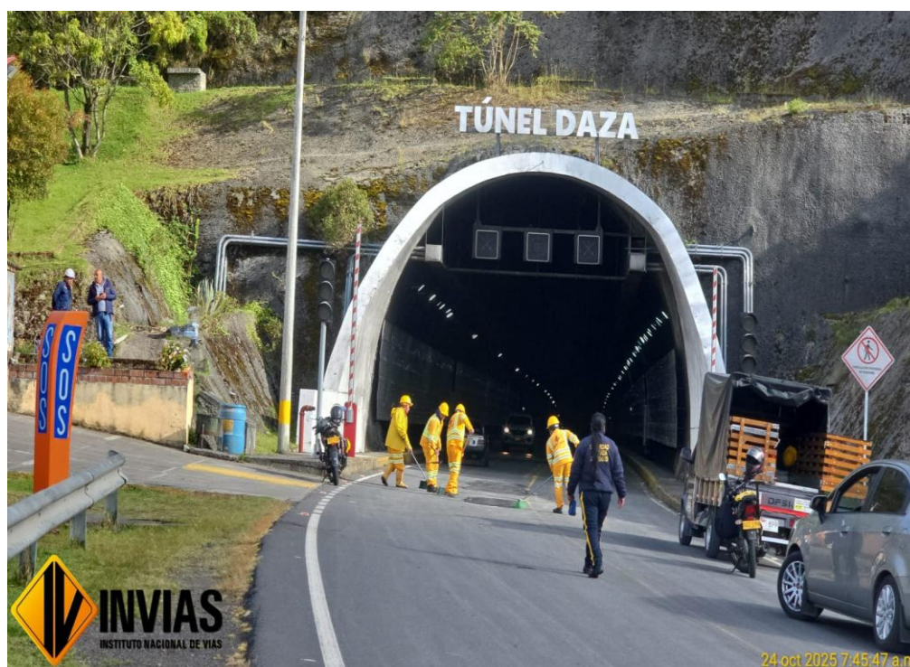
Limpieza túnel Daza con personal de mantenimiento rutinario, ruta 25NRD
