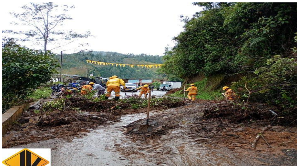
Atención de emergencia con personal de mantenimiento rutinario, ruta 2501B PR63+0900
